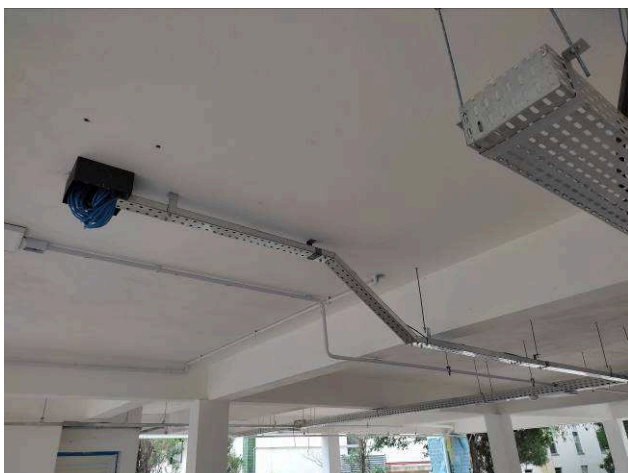
Figura 27E: Iluminação garagem
