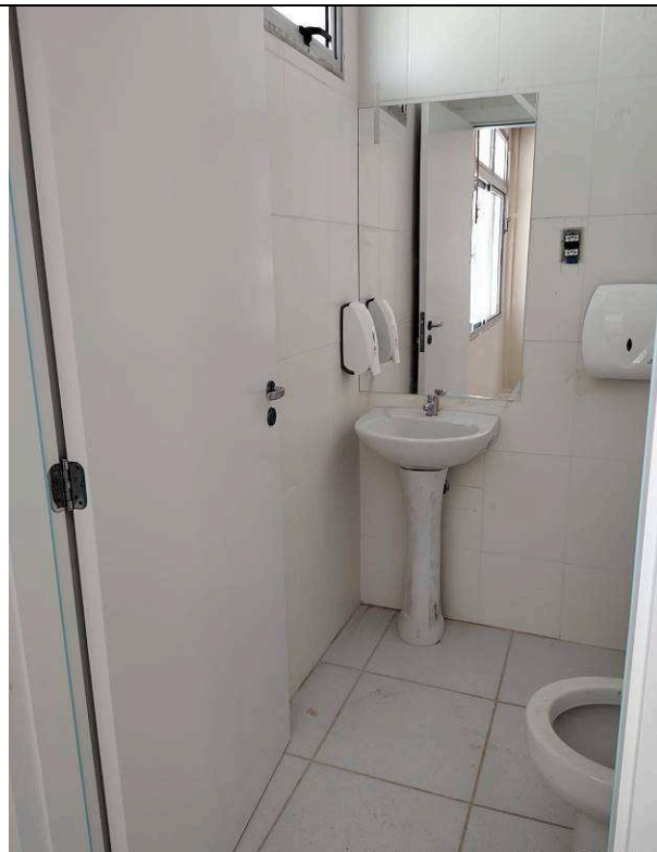
Figura 34: Banheiros – 4ª Vara.
