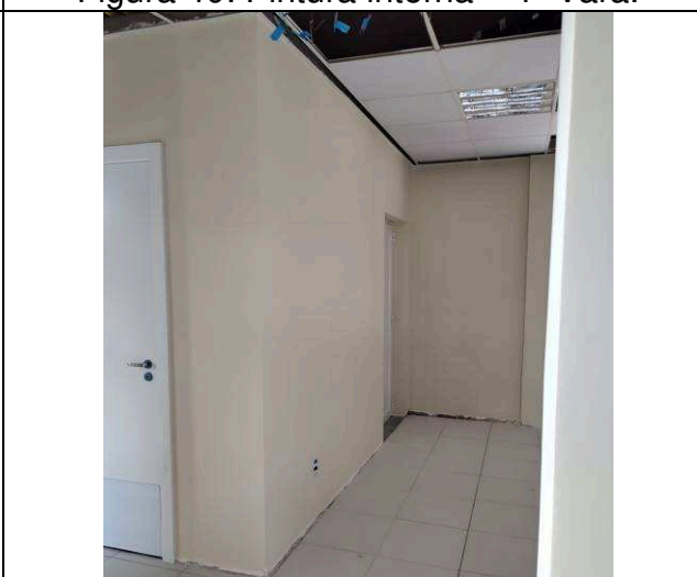
Figura 42: Pintura interna – 4ª Vara.
