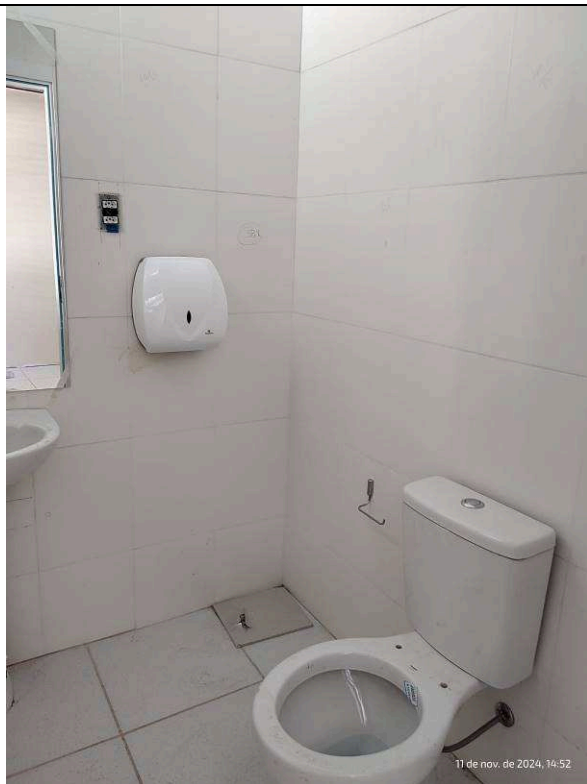
Figura 33: Banheiros – 4ª Vara.
