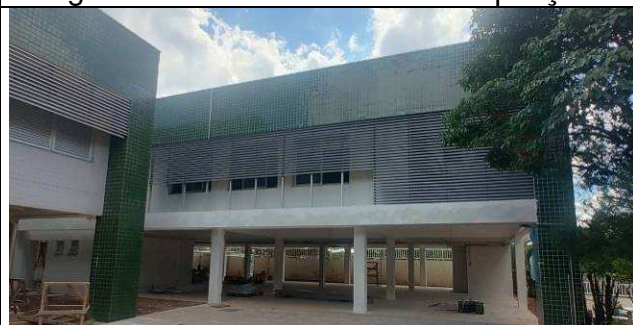
Figura 45: Pintura externa – Ampliação.
