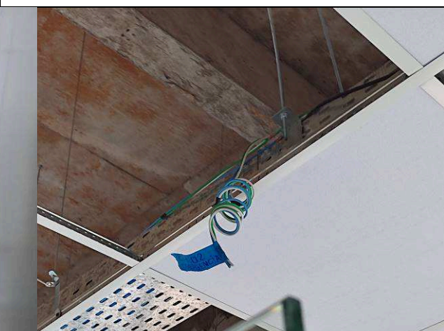
Figura 04E: cabeamento 2,5mm 2 4ª VT
