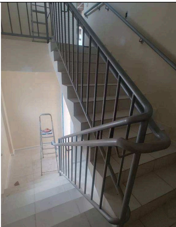
Figura 29: Guarda corpo e corrimãos – 4ª Vara.
