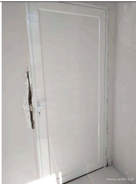
Figura 16: Portas de alumínio – 4ª Vara.
