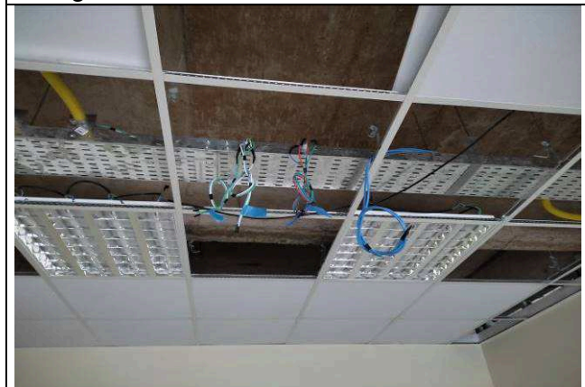
Figura 05E: cabeamento 2,5mm 2 4ª VT
