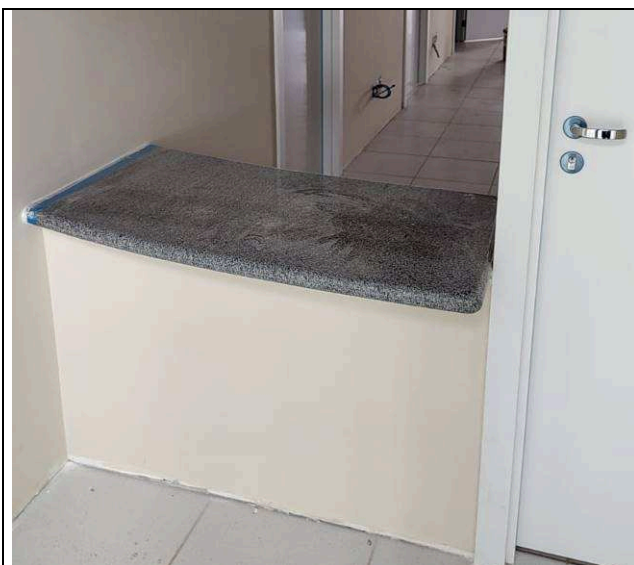
Figura 01: Balcão de atendimento – 4ª Vara.
