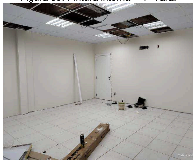
Figura 41: Pintura interna – 4ª Vara.
