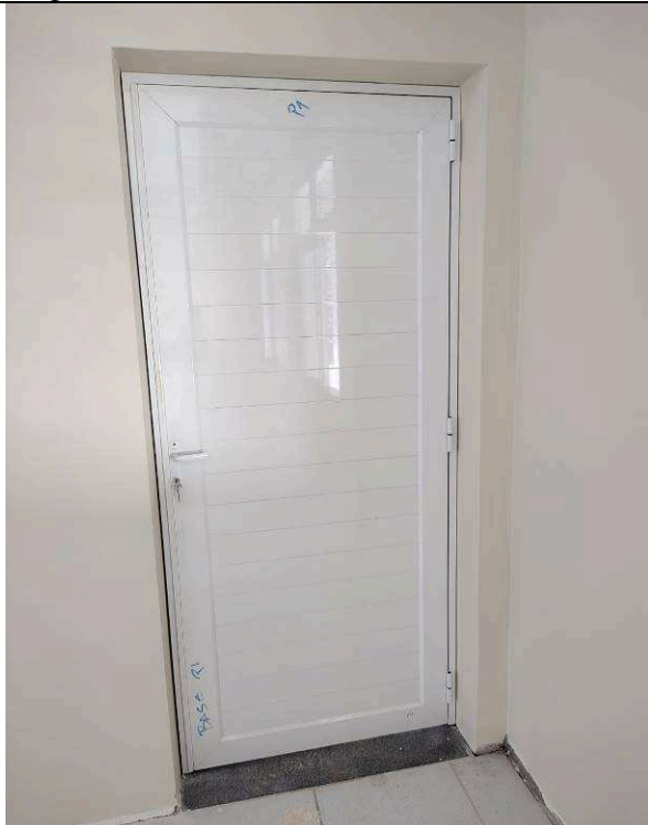
Figura 17: Portas de alumínio – 4ª Vara.
