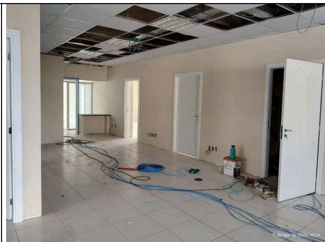
Figura 38: Pintura interna – 4ª Vara.
