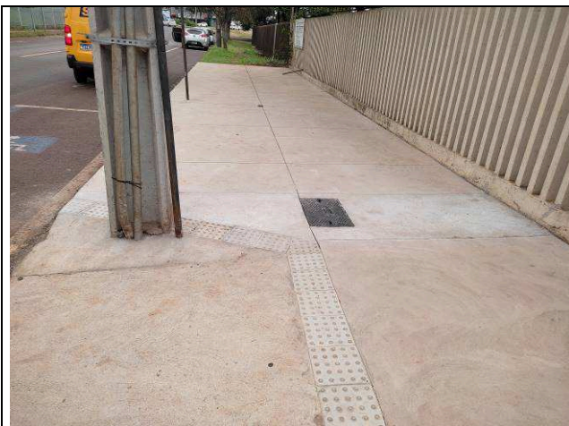
Figura 33E: Entrada Telecomunicações
