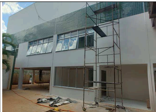
Figura 43: Pintura externa – Ampliação.
