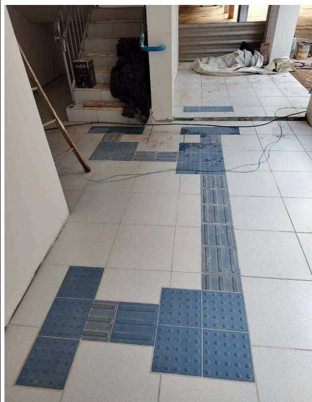
Figura 10: Pisos cerâmicos, podotáteis e soleiras – subsolo.
