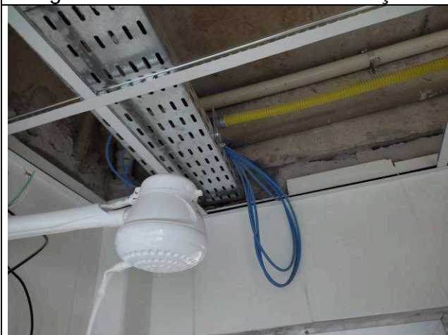
Figura 35E: Cabo UTP cat6 câmeras
