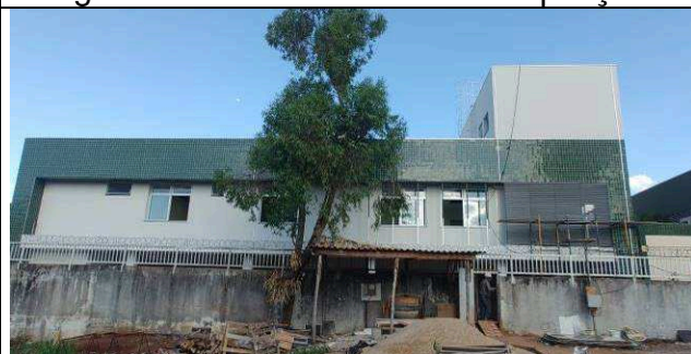
Figura 46: Pintura externa – Ampliação.
