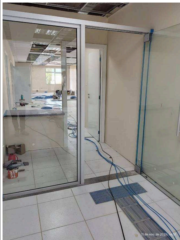
Figura 28: Porta de Vidro – Balcão 4ª Vara.
