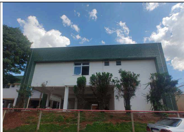
Figura 44: Pintura externa – Ampliação.
