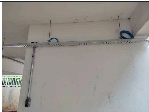
Figura 39E: Cabo UTP cat6 câmeras
