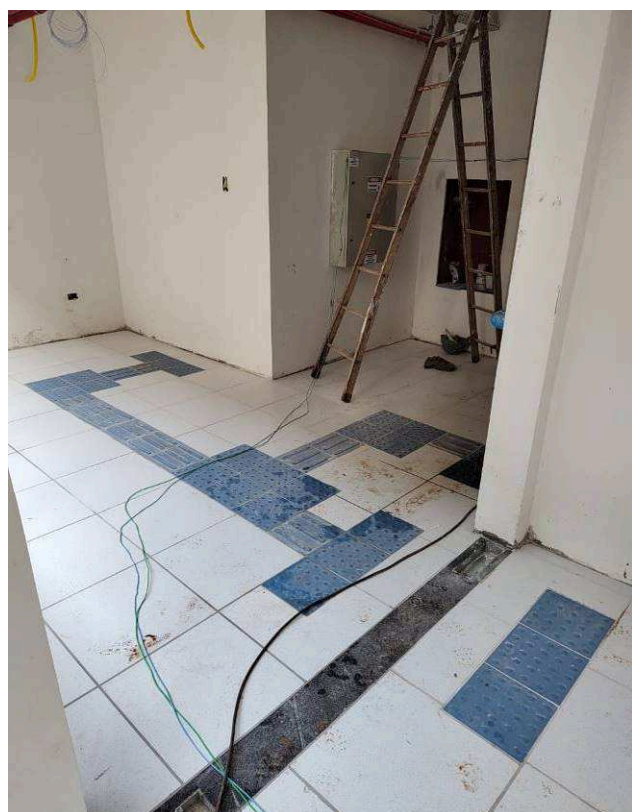
Figura 09: Pisos cerâmicos, podotáteis e soleiras – subsolo.
