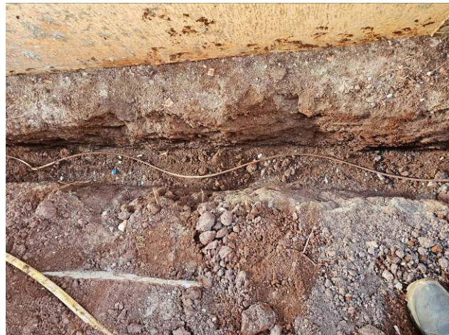
Figura 23E: Aterramento – cabo de cobre nu 50mm 2
