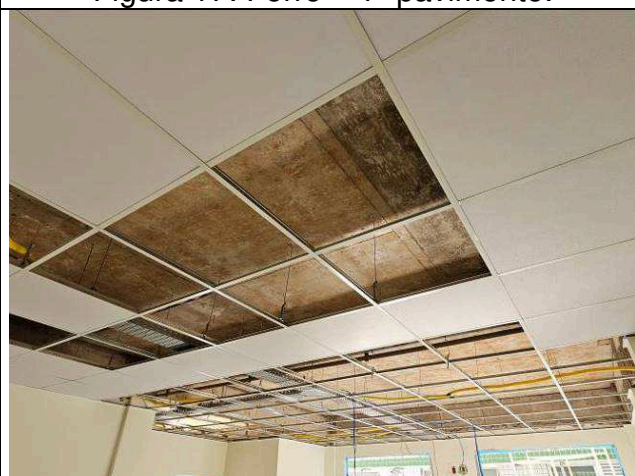
Figura 19: Forro – 1º pavimento.
