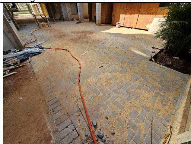
Figura 75: Paver - estacionamento.
