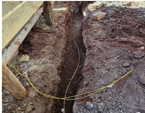
Figura 24E: Aterramento – cabo de cobre nu 50mm 2
