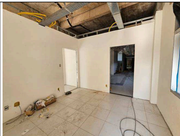
Figura 44: Pintura interna – 1º pavimento.
