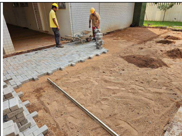
Figura 68: Paver - estacionamento.
