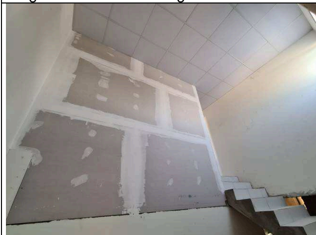
Figura 05: Paredes de gesso acartonado.
