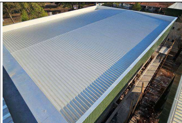
Figura 49: Pintura face interna platibandas.
