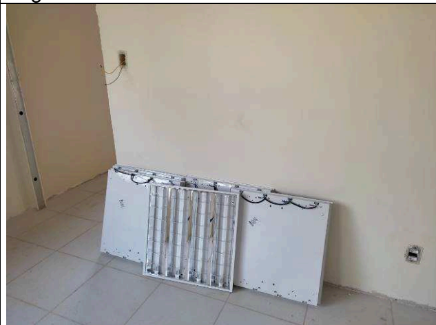
Figura 13E: Luminárias com aletas – 4ª VT
