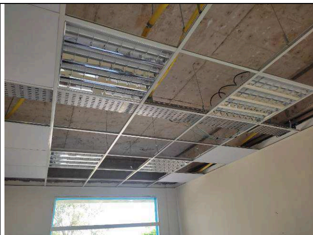
Figura 11E: Luminárias com aletas – 4ª VT
