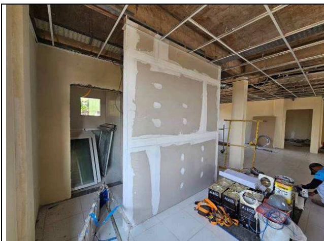
Figura 03: Paredes de gesso acartonado.
