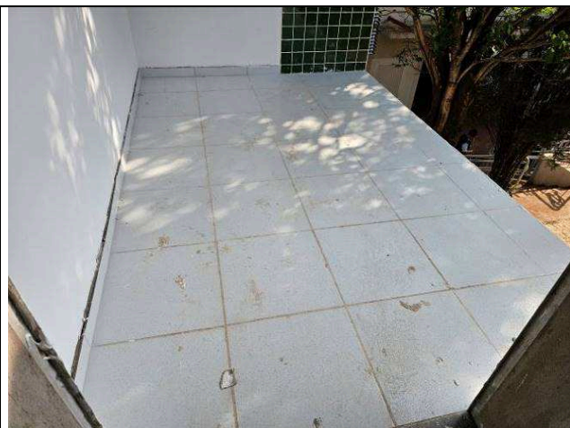
Figura 28: Piso cerâmico – salas técnicas.
