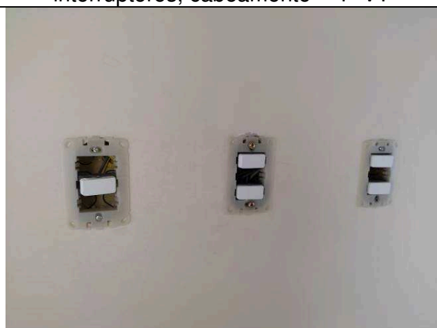
Figura 09E: Caixas 2x4", tomadas, interruptores, cabeamento – 4ª VT
