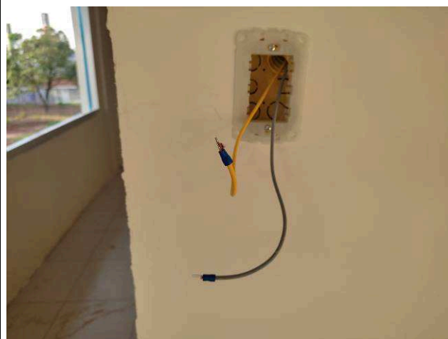
Figura 04E: Caixas 2x4", tomadas, interruptores, cabeamento – 4ª VT
