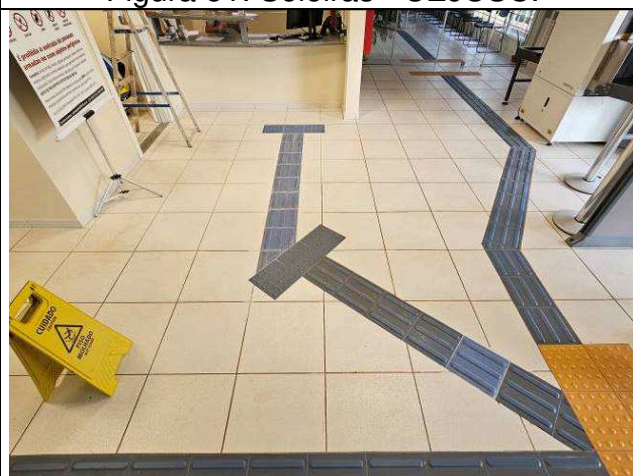
Figura 53: Piso podotátil – balcão Hall.
