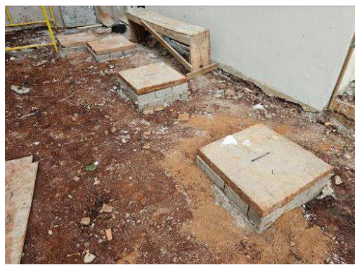
Figura 41: Rede de esgoto e águas pluviais. Figura 42: Rede de esgoto e águas pluviais.
