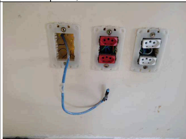
Figura 08E: Caixas 2x4", tomadas, interruptores, cabeamento – 4ª VT
