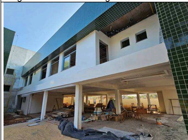
Figura 07: Revestimento das fachadas.
