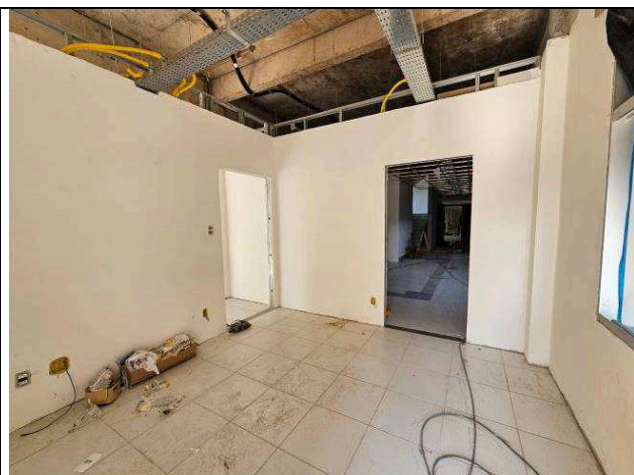
Figura 04: Paredes de gesso acartonado.
