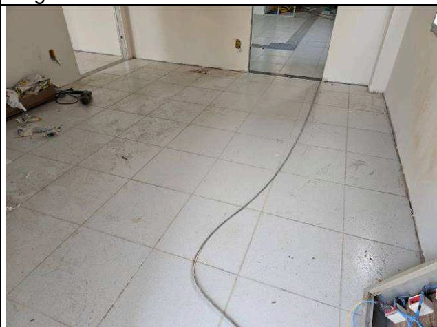
Figura 29: Piso cerâmico – sala conciliação.
