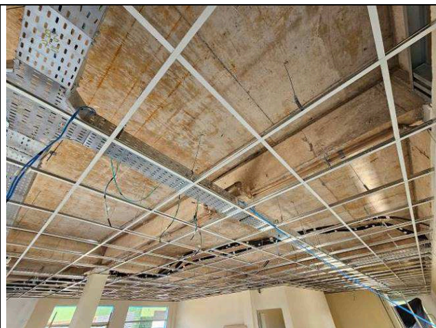
Figura 21: Forro – 1º pavimento.
