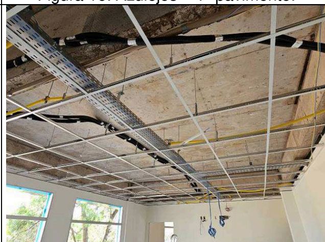
Figura 18: Forro – 1º pavimento.
