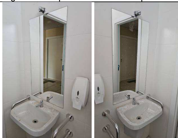
Figura 58: Espelhos – banheiros públicos.
