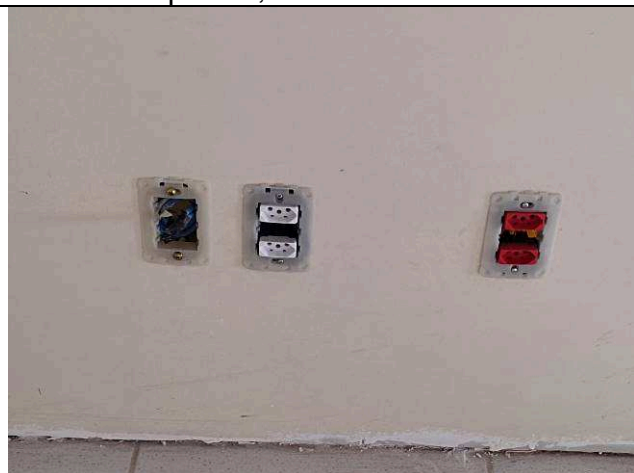
Figura 07E: Caixas 2x4", tomadas, interruptores, cabeamento – 4ª VT
