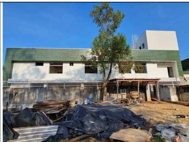
Figura 10: Revestimento das fachadas.
