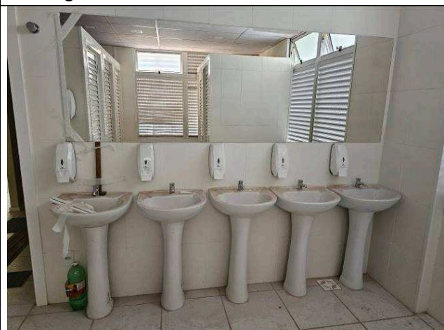
Figura 57: Espelhos – banheiros públicos.
