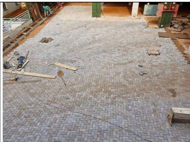
Figura 73: Paver - estacionamento.
