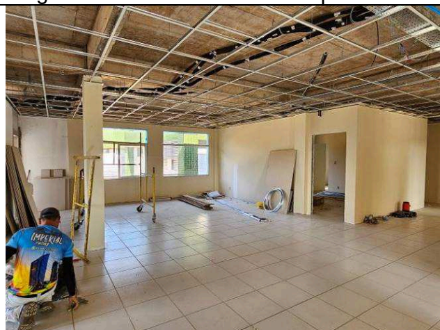
Figura 45: Pintura interna – 1º pavimento.
