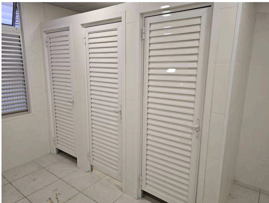
Figura 3 – Vista interna dos banheiros públicos.
