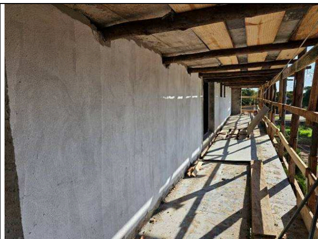
Figura 10: Alvenarias e revestimento.
