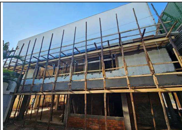
Figura 04: Andaimos nas fachadas.
