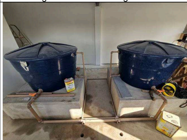
Figura 34: Reservatórios de água.
