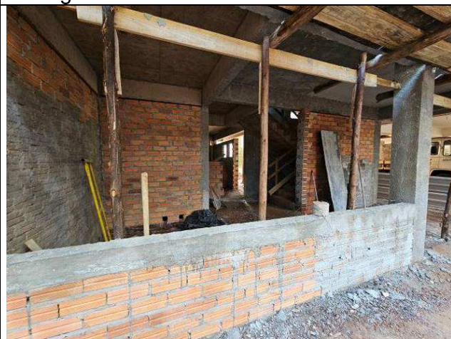
Figura 14: Alvenarias e revestimento.
