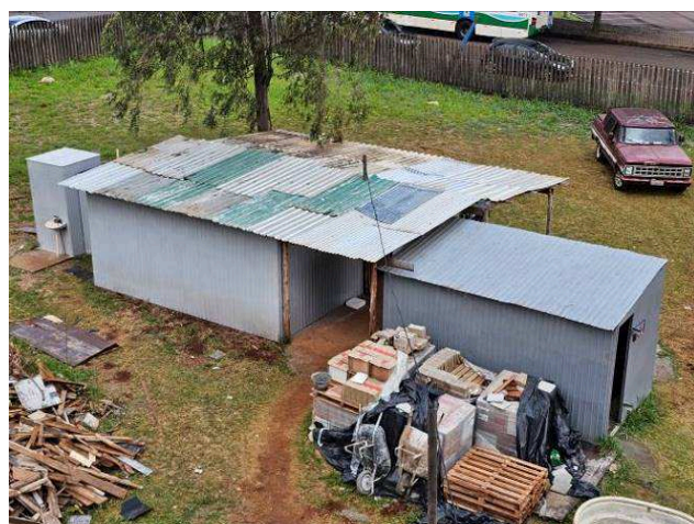
Figura 01: Barracão canteiro de obras.
