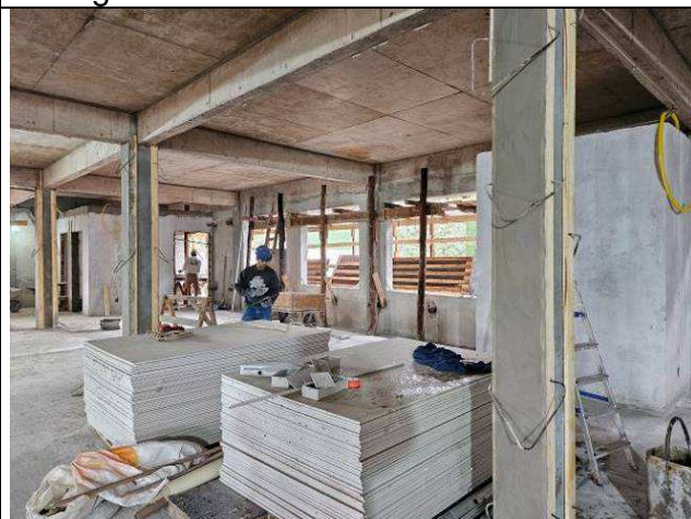
Figura 13: Alvenarias e revestimento.
