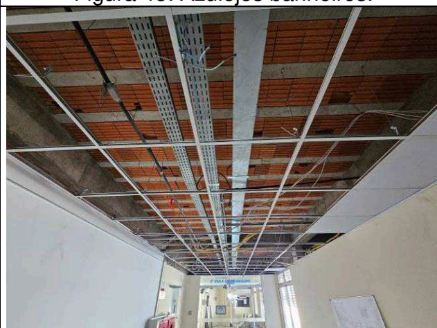
Figura 50: Forros modulares - perfis.
