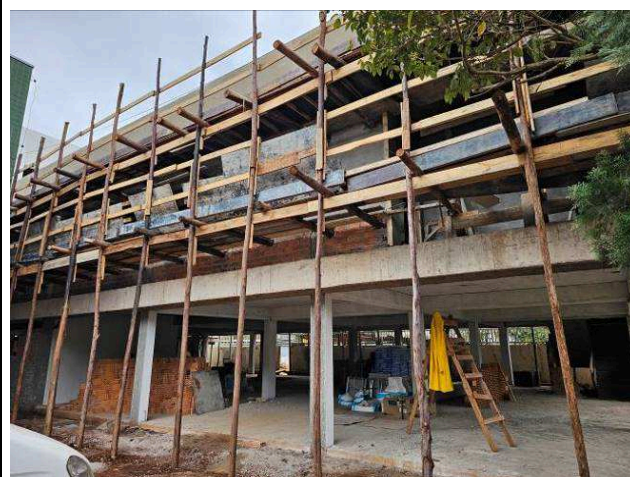
Figura 02: Andaimos nas fachadas.
