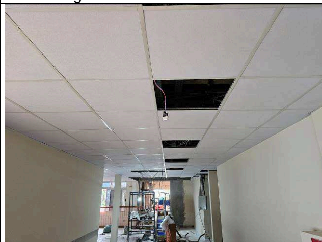
Figura 56: Forros modulares.
