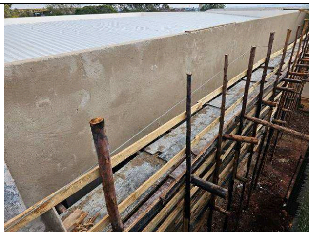
Figura 09: Alvenarias e revestimento.
