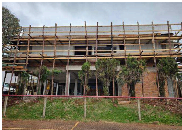
Figura 03: Andaimos nas fachadas.
