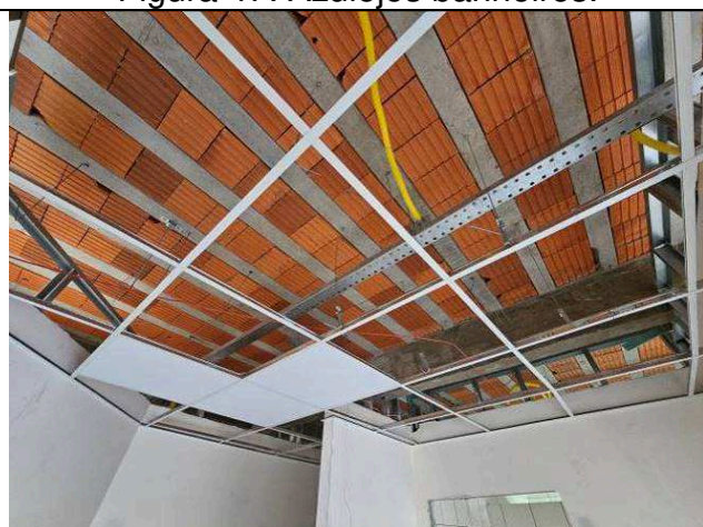
Figura 49: Forros modulares - perfis.
