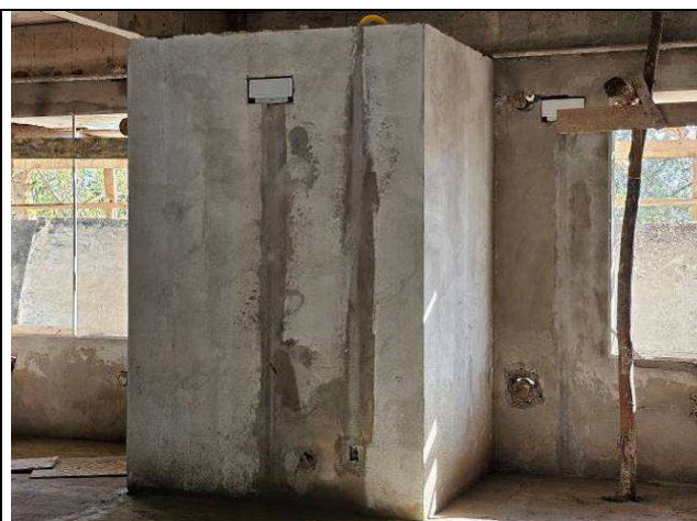
Figura 06: Alvenarias e revestimento.
