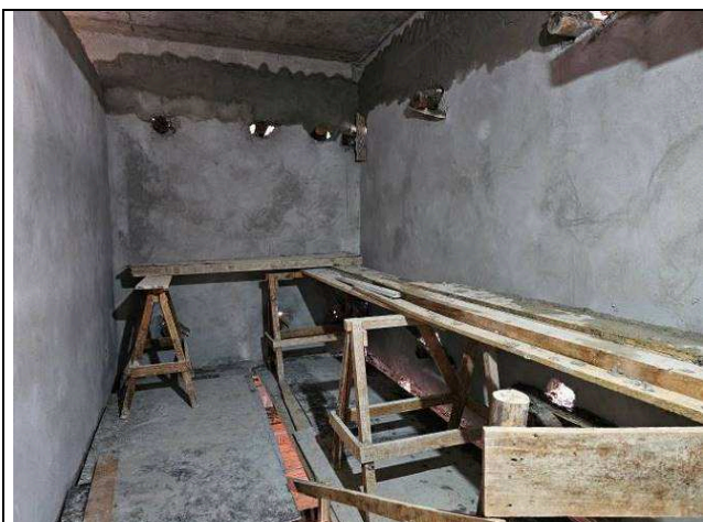
Figura 05: Alvenarias e revestimento.
