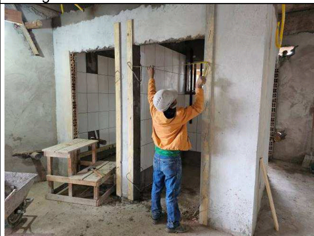
Figura 12: Alvenarias e revestimento.
