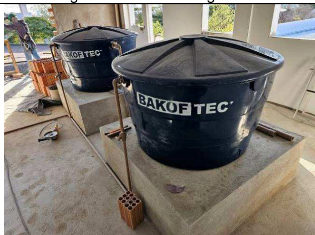
Figura 33: Reservatórios de água.
