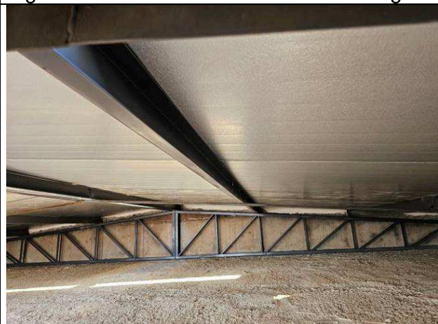
Figura 06: Telhas de cobertura - montagem.
