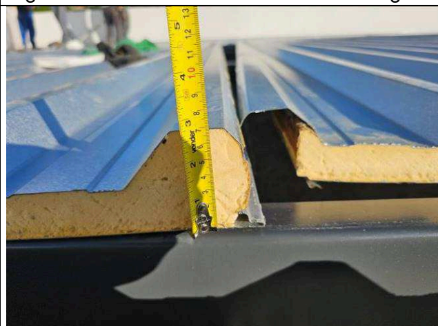
Figura 07: Telhas de cobertura - montagem.
