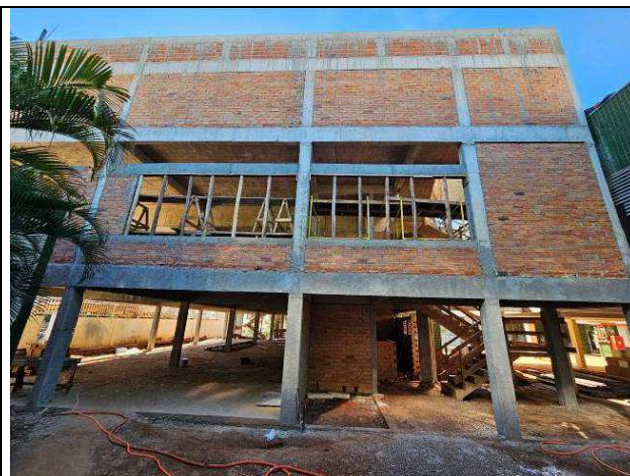
Figura 34: Alvenarias de vedação.
