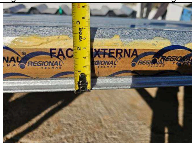
Figura 08: Telhas de cobertura - montagem.
