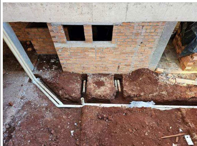
Figura 70: Redes de águas pluviais e esgoto.
