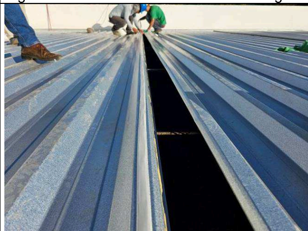
Figura 12: Telhas de cobertura – fita de vedação.
