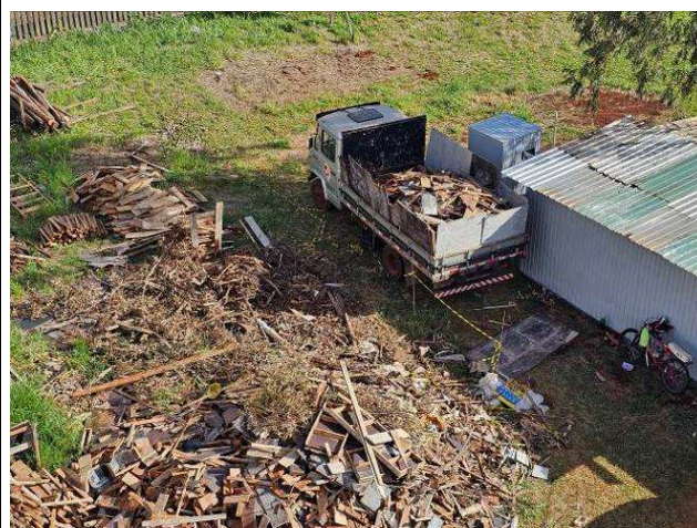
Figura 02: Retirada de restos de madeira.
