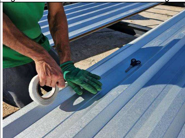
Figura 11: Telhas de cobertura - fita de vedação.
