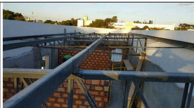
Figura 16: Estrutura metálica de cobertura - barrilete.
