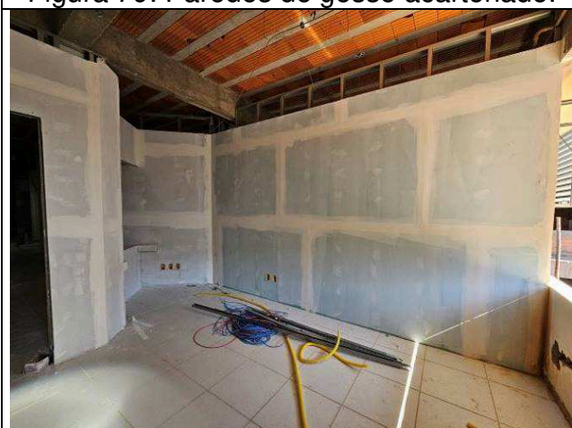
Figura 81: Paredes de gesso acartonado.
