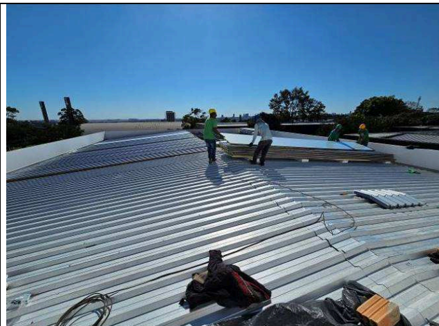
Figura 03: Telhas de cobertura - montagem.
