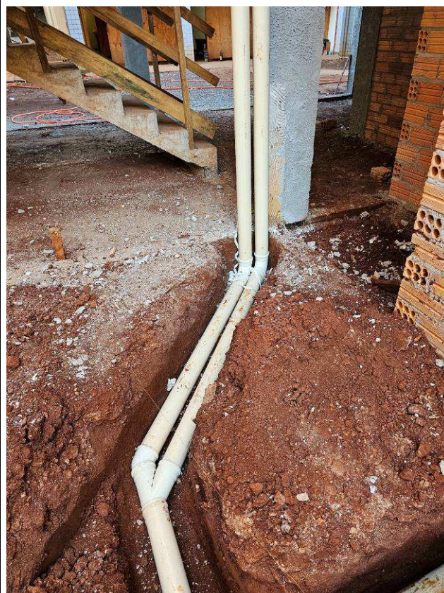
Figura 66: Redes de águas pluviais.
