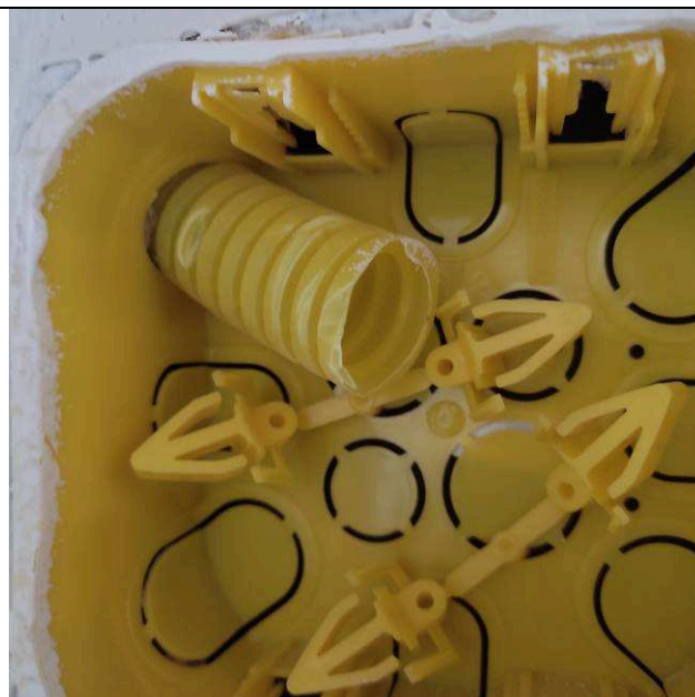
Figura 04E: Infraestrutura eletrodutos e caixas 2x4" e 4x4" - Cejusc.
