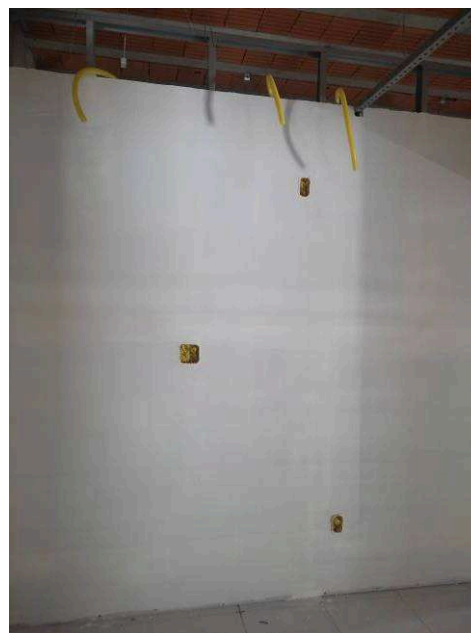
Figura 02E: Infraestrutura eletrodutos e caixas 2x4" e 4x4" - Cejusc.
