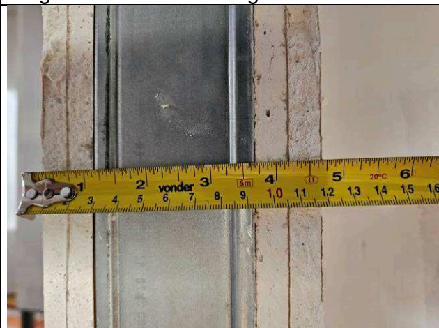
Figura 86: Paredes de gesso acartonado dupla.
