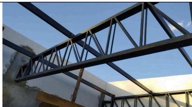
Figura 15: Estrutura metálica de cobertura - barrilete.
