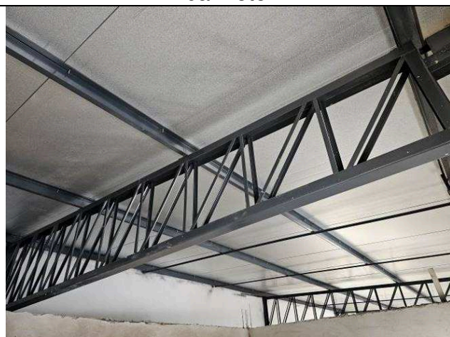
Figura 17: Estrutura metálica de cobertura - barrilete.
