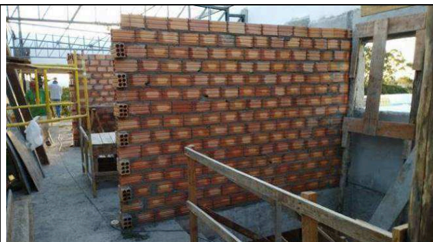
Figura 40: Alvenarias de vedação.
