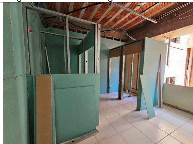
Figura 75: Paredes de gesso acartonado.
