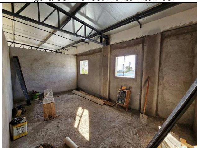
Figura 55: Revestimento internos.
