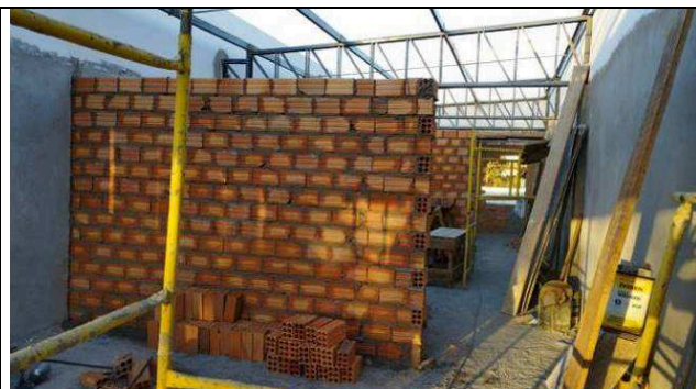
Figura 39: Alvenarias de vedação.
