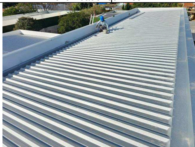
Figura 23: Telhas de cobertura - barrilete.
