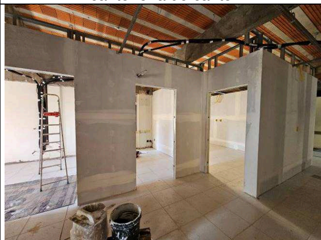
Figura 80: Paredes de gesso acartonado.
