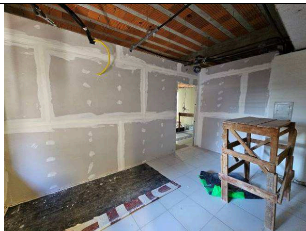
Figura 83: Paredes de gesso acartonado.
