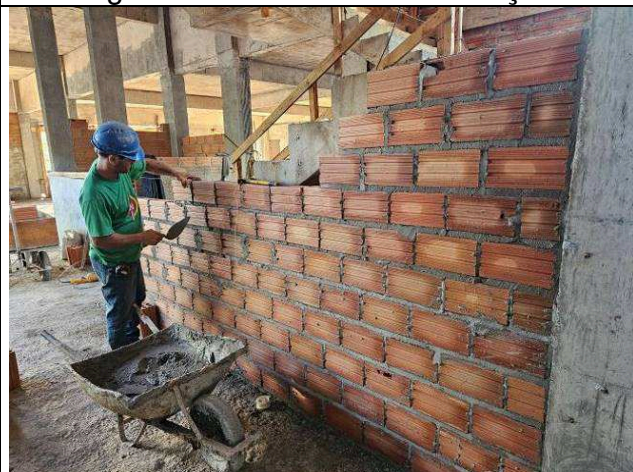
Figura 42: Alvenarias de vedação.
