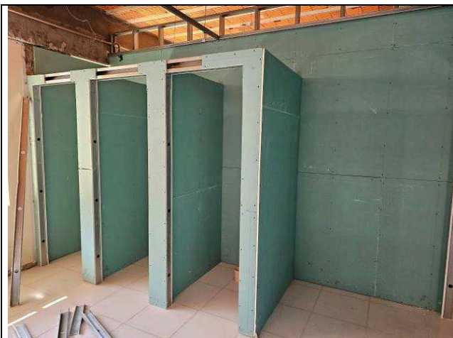
Figura 77: Paredes de gesso acartonado.
