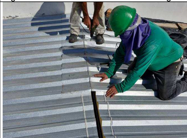
Figura 05: Telhas de cobertura - montagem.
