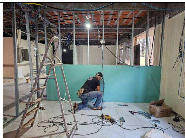
Figura 74: Paredes de gesso acartonado.
