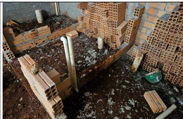
Figura 72: Redes de esgoto.
