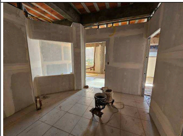
Figura 79: Paredes de gesso acartonado.
