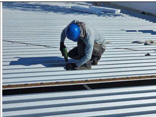
Figura 09: Telhas de cobertura - montagem.
