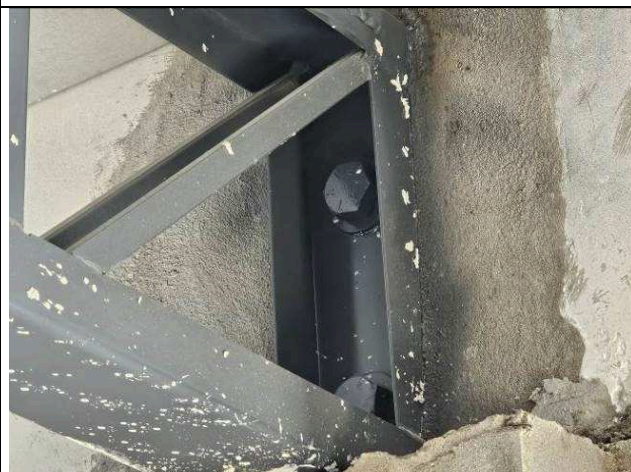
Figura 20: Fixação da estrutura metálica de cobertura - barrilete.
