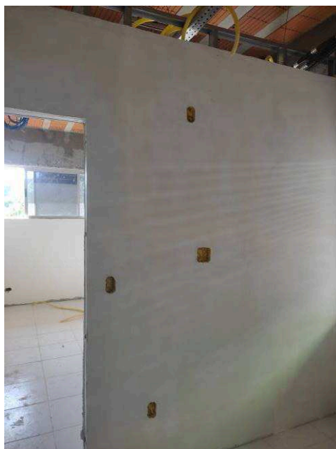
Figura 01E: Infraestrutura eletrodutos e caixas 2x4" e 4x4" - Cejusc.
