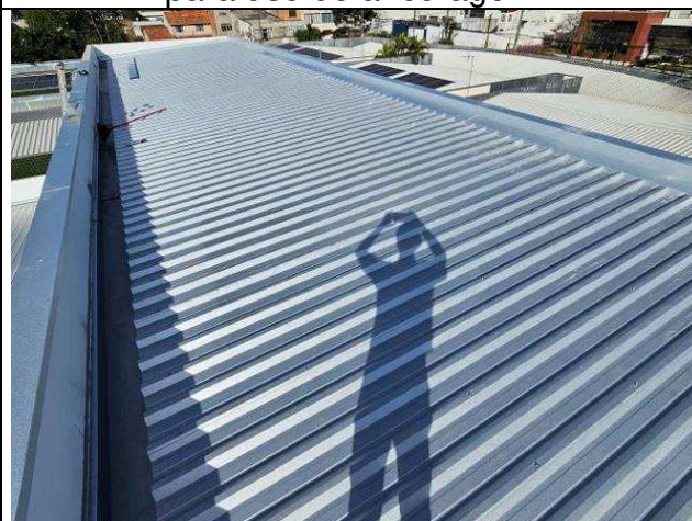
Figura 24: Telhas de cobertura - barrilete.
