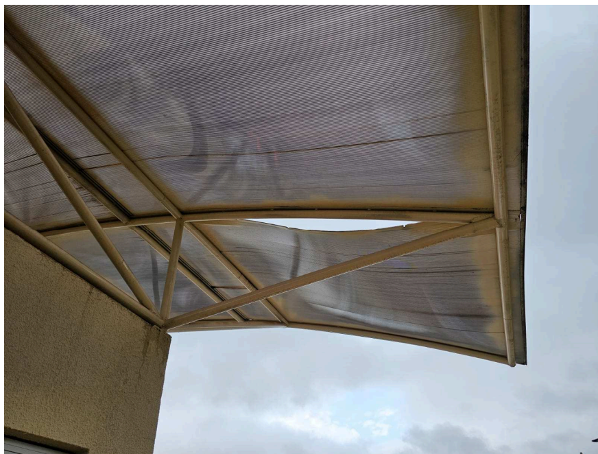
Figura 7 – foto atual da guarita – placa de policarbonato solta
