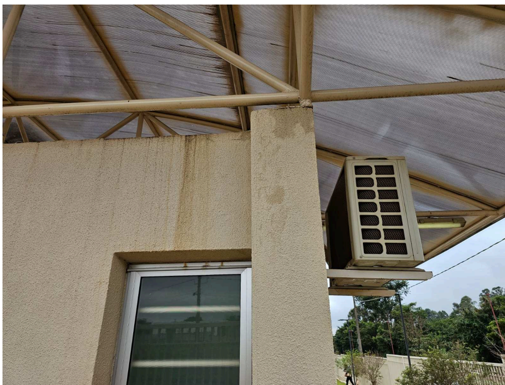
Figura 8 – foto atual da guarita – alvenaria manchada
