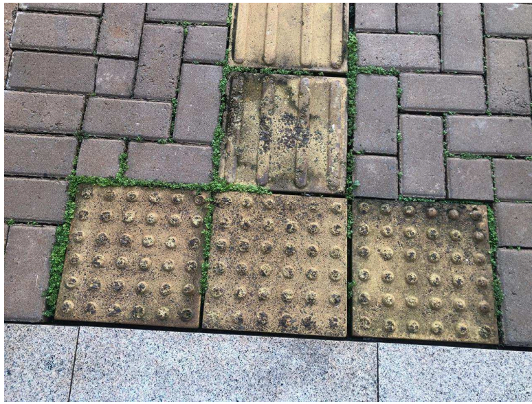
Figura 2 – foto do piso podotátil em calçada interna, a ser recuperado
