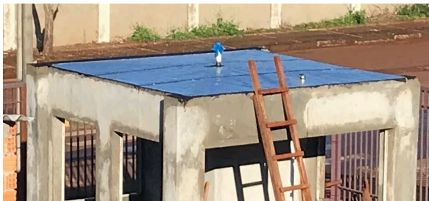
Figura 5 – laje impermeabilizada existente, à época da construção do FT de Toledo
