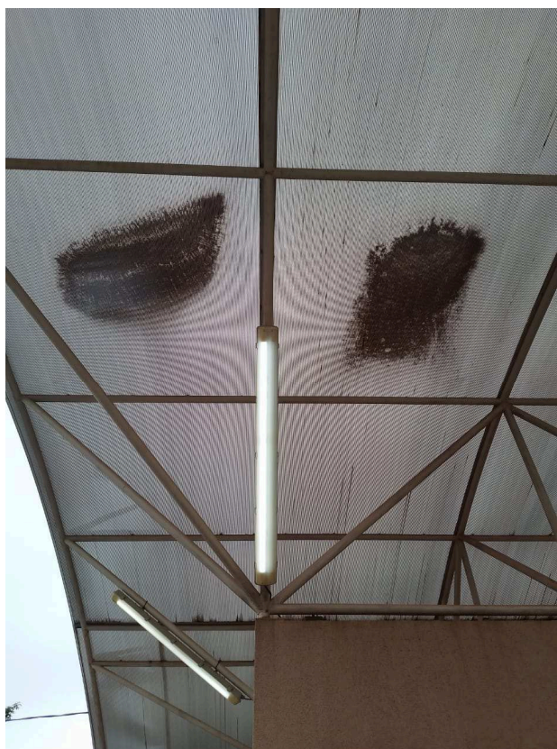
Figura 10 – foto atual da guarita – placas de policarbonato alveolar deterioradas
