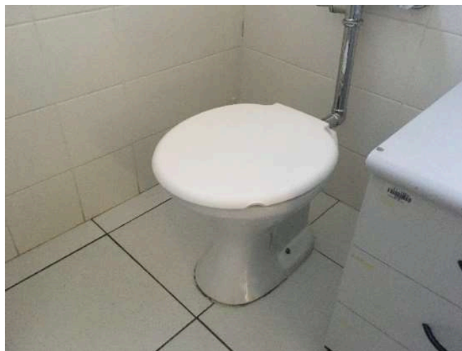
Bacia sanitária convencional, a ser substituída por bacia adaptada para PCR
