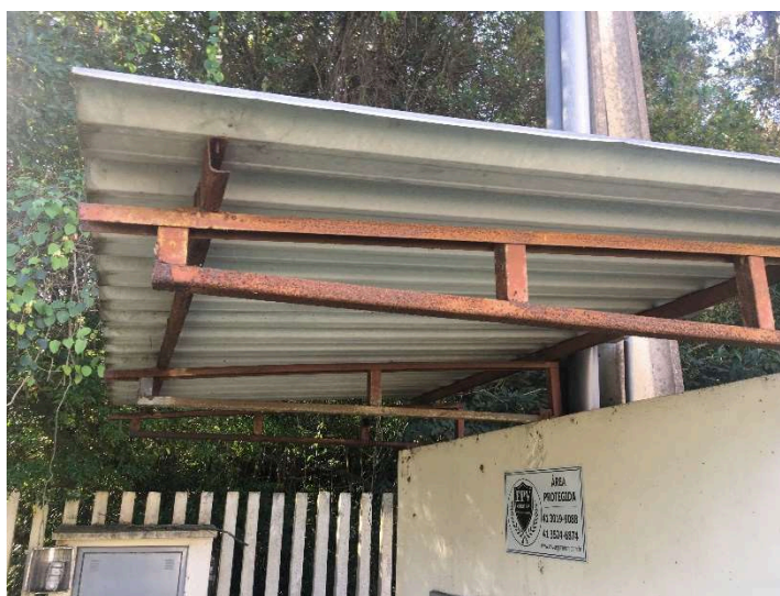
Estrutura metálica a ser recuperada
