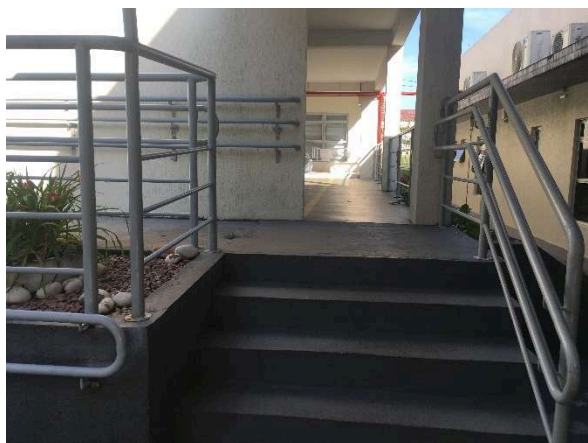
Escada com corrimão faltante do lado esquerdo
