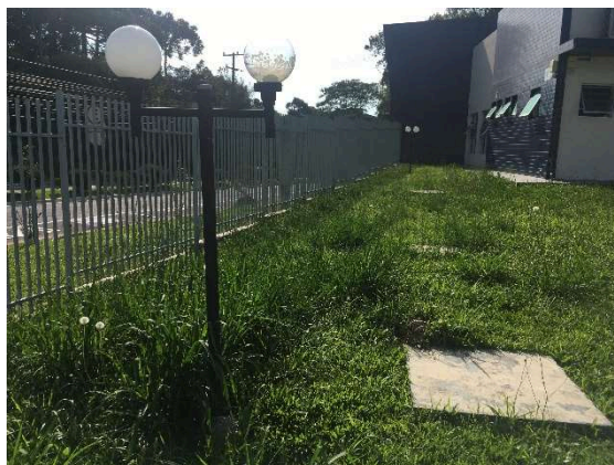
Luminária externa com globo descascado
