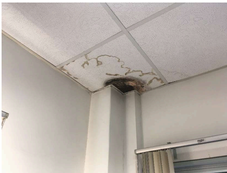
Placa de forro deteriorada, a ser substituída
