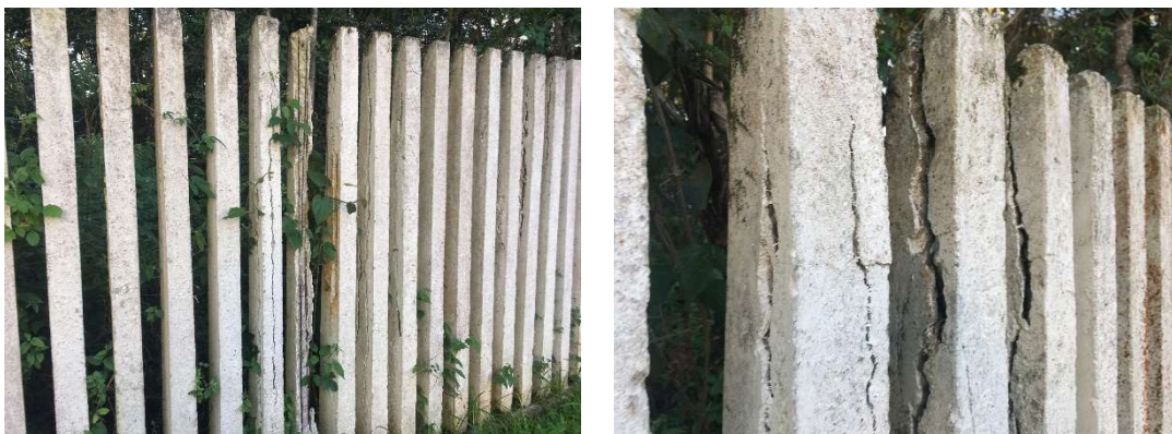
Muro palito a ser substituído
