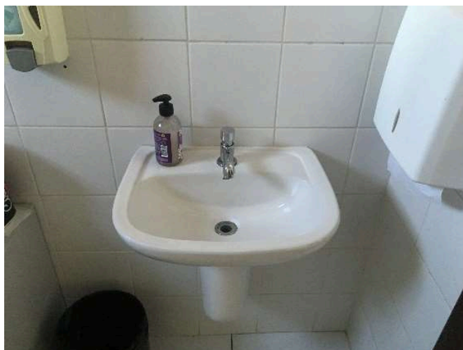
Lavatório sem barras de apoio
