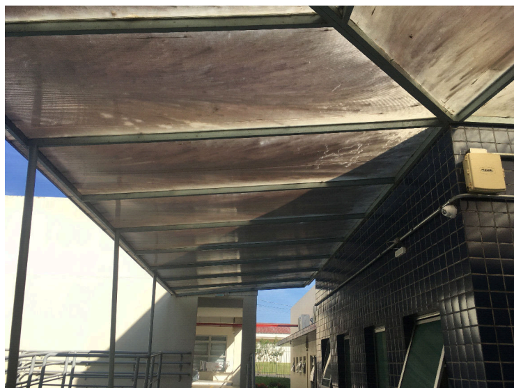
Polycarbonato alveolar existente, a ser substituído por polycarbonato compacto
