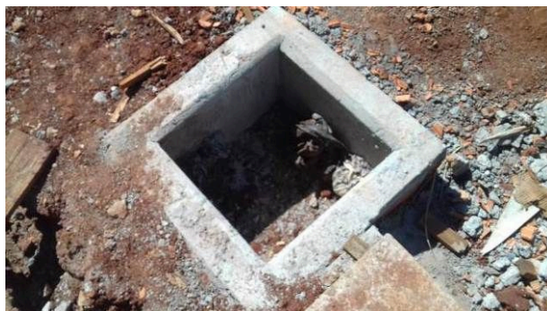
Caixa de inspeção - esgoto
