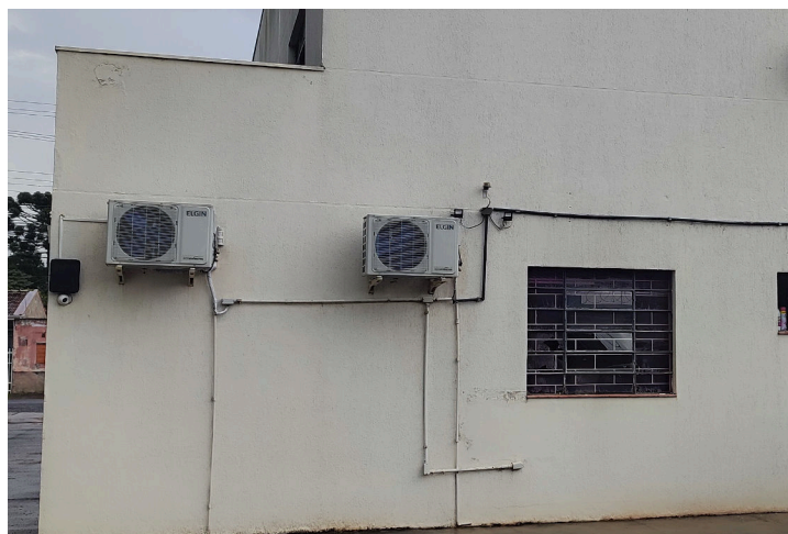
Figura 5 – Eletrodutos a embutir
