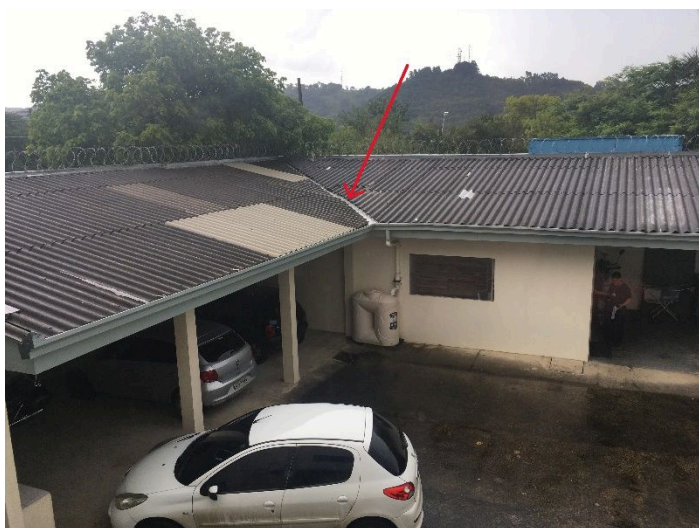
Calha (água furtada) a substituir
