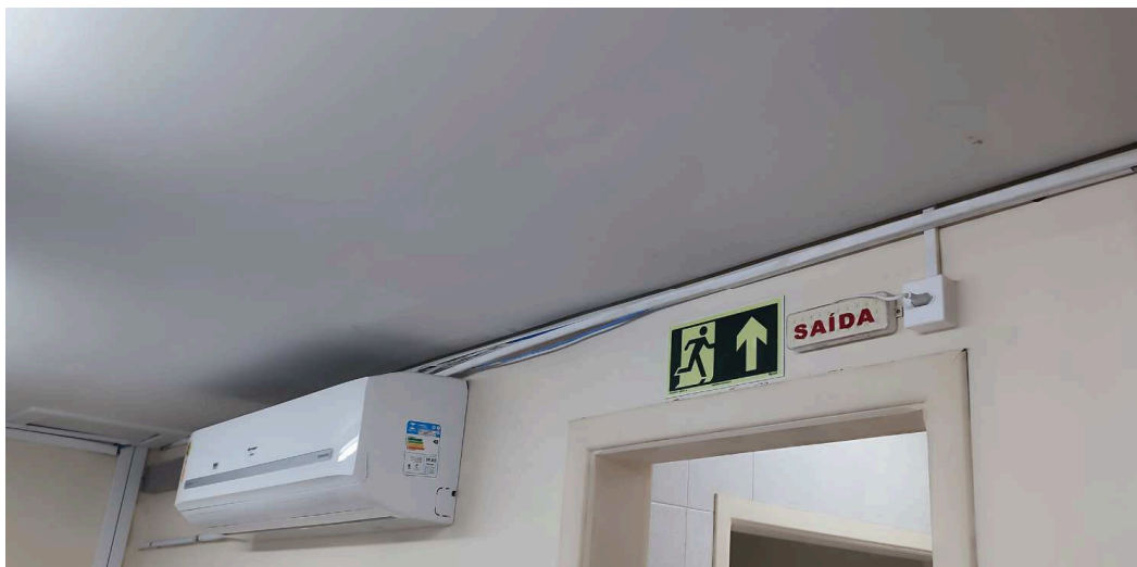
Figura 4 - Canaletas de parede a substituir
