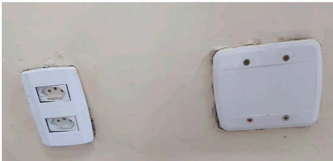
Figura 2: Tomada e placa cega a serem substituídas
