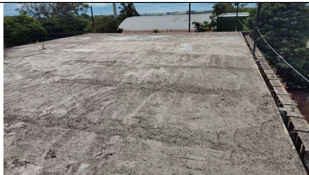
Figura 30: Concretagem cobertura/barrilete.
