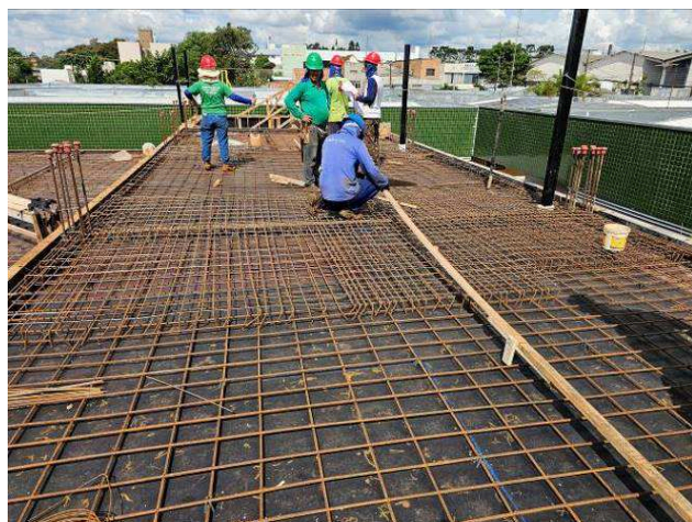
Figura 17: Formas e armaduras - barrilete.
