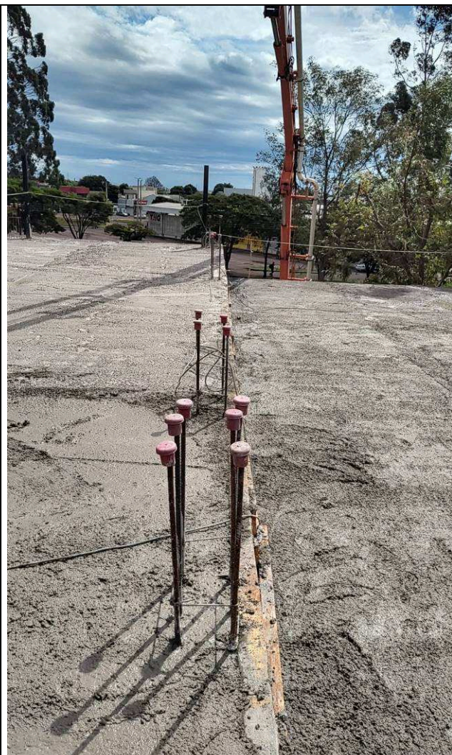
Figura 32: Concretagem cobertura/barrilete.
