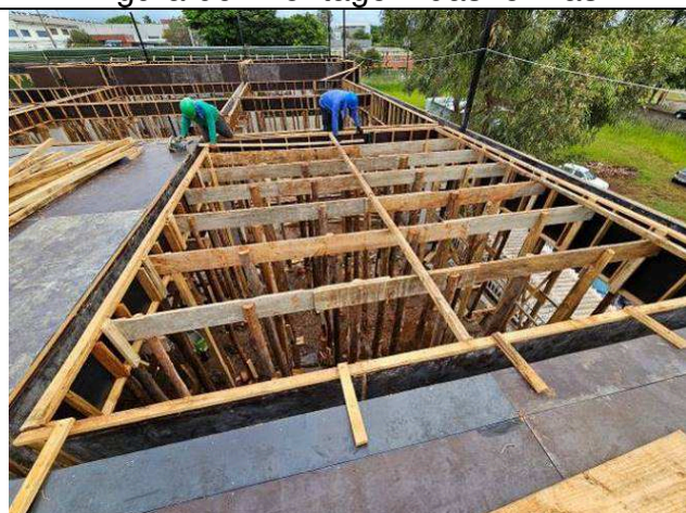
Figura 08: Montagem das formas.
