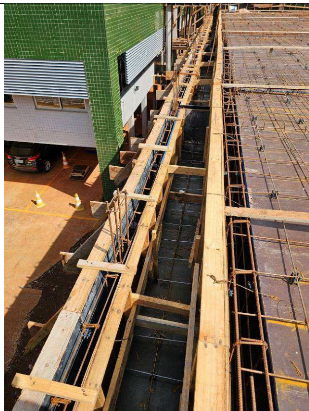
Figura 16: Formas e armaduras - cobertura.
