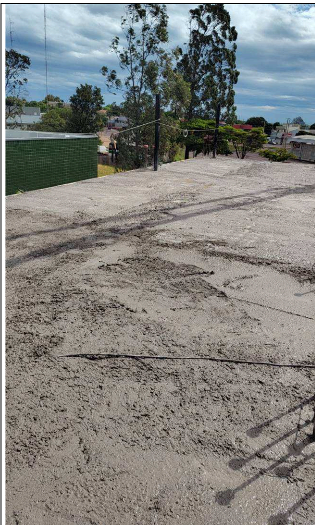
Figura 31: Concretagem cobertura/barrilete.
