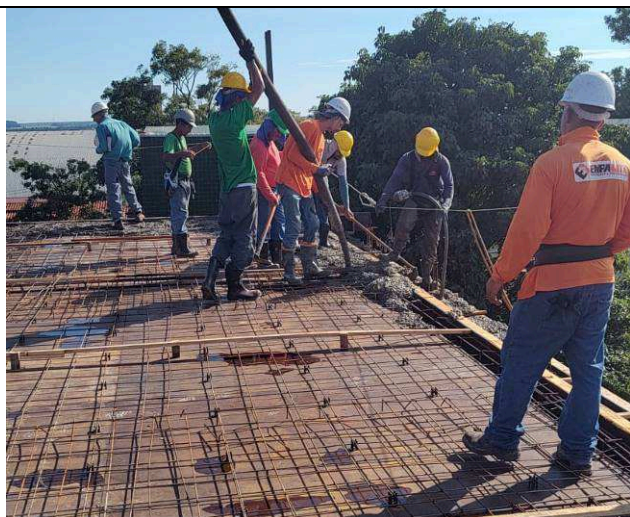
Figura 27: Concretagem cobertura/barrilete.
