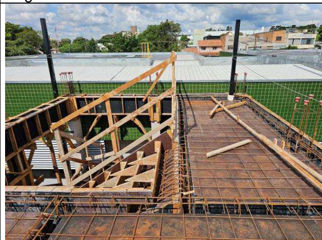
Figura 21: Formas e armaduras - escada.
