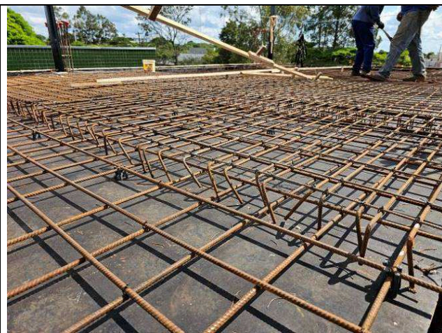
Figura 19: Formas e armaduras - barrilete.
