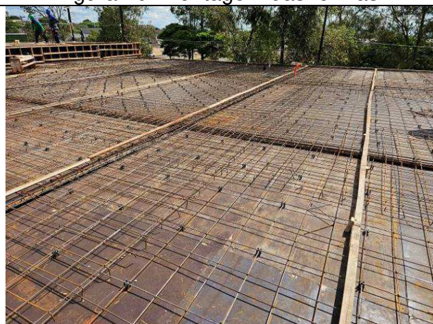
Figura 12: Formas e armaduras - cobertura.
