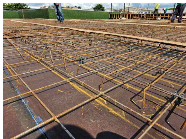
Figura 13: Formas e armaduras - cobertura.
