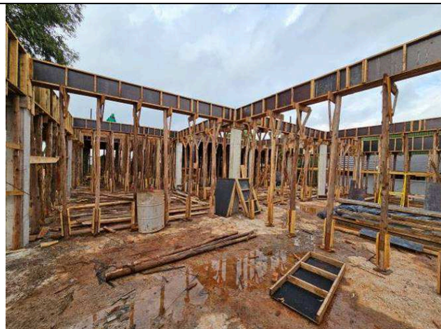
Figura 04: Montagem das formas.
