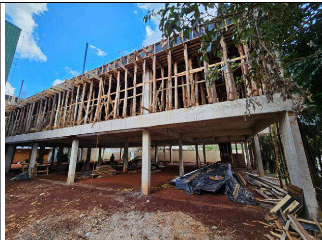
Figura 03: Montagem das formas.
