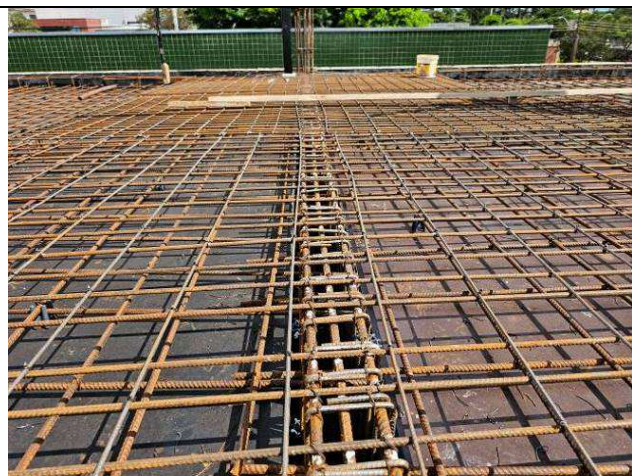
Figura 20: Formas e armaduras - barrilete.
