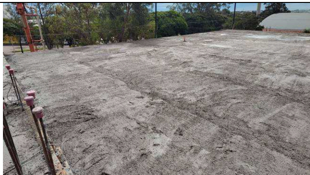
Figura 29: Concretagem cobertura/barrilete.
