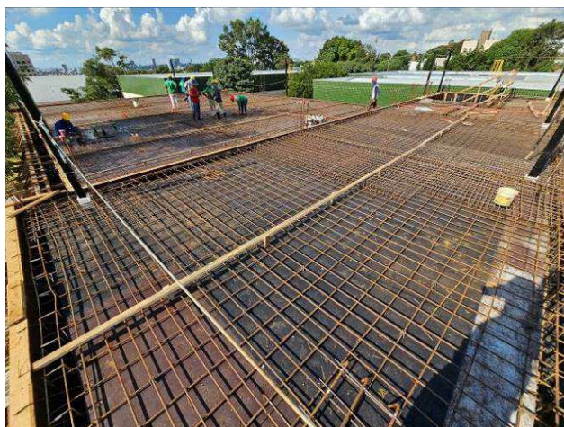
Figura 18: Formas e armaduras - barrilete.
