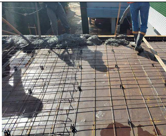
Figura 28: Concretagem cobertura/barrilete.
