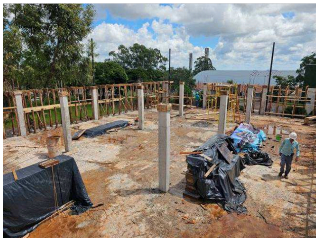
Figura 12: Pilares 1º Pavimento.
