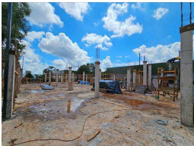
Figura 11: Pilares 1º Pavimento.
