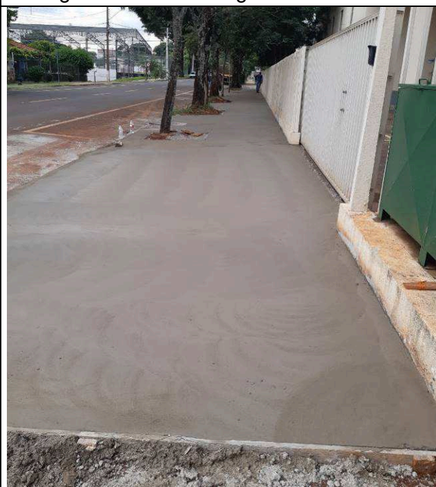
Figura 30: Concretagem – Guaracas.
