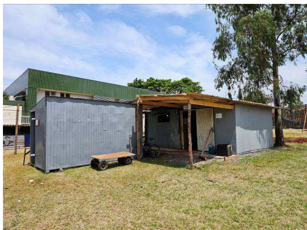
Figura 01: Canteiro de obras.
