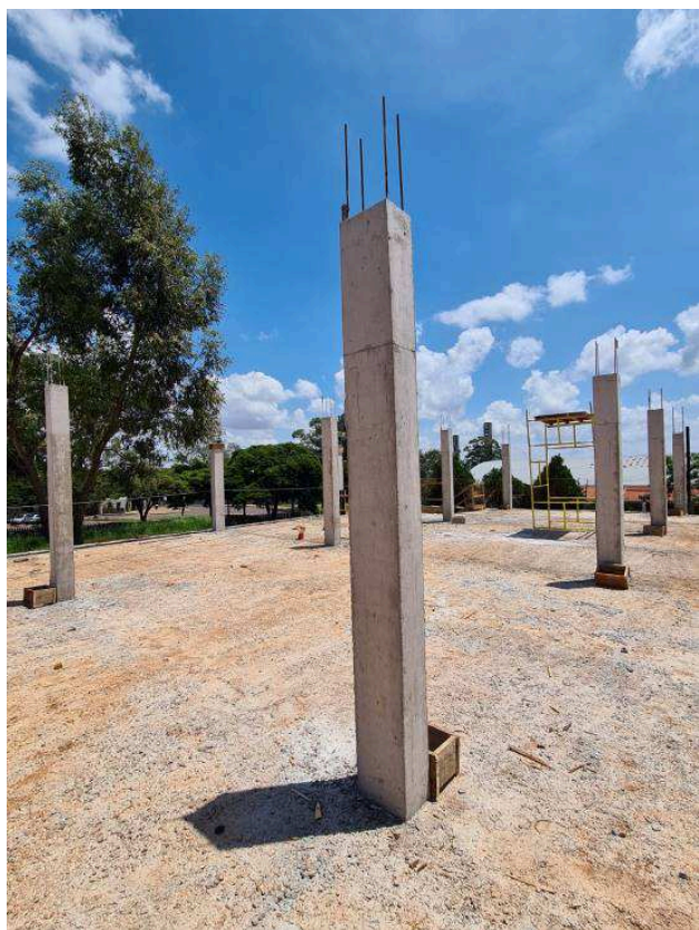
Figura 13: Pilares 1º Pavimento.
