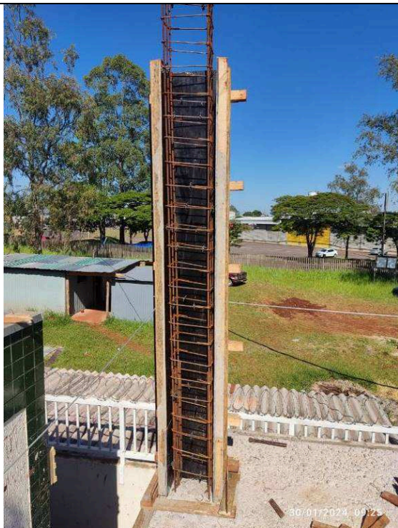
Figura 03: Pilares 1º Pavimento.
