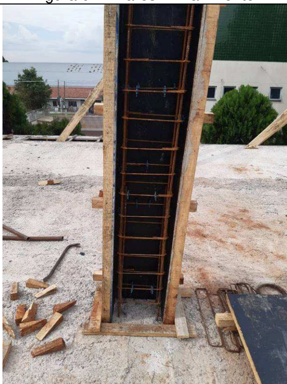
Figura 09: Pilares 1º Pavimento.
