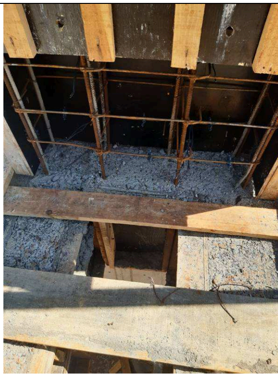
Figura 08: Pilares 1º Pavimento.
