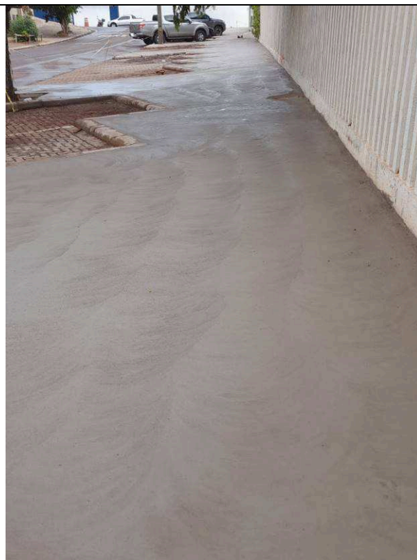
Figura 20: Concretagem – Calçada Parecis.
