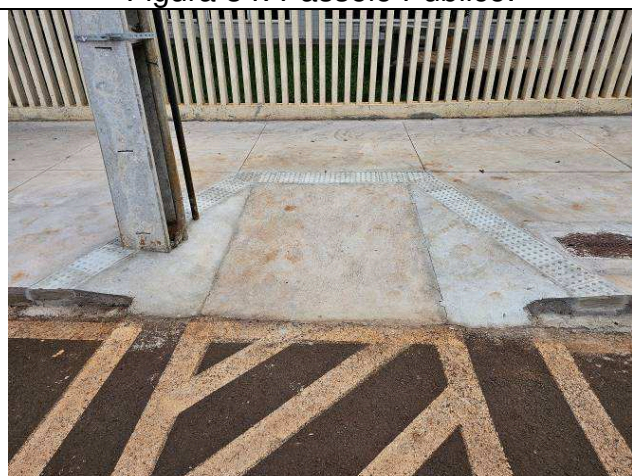
Figura 36: Piso Podotátil – Passeio Público.
