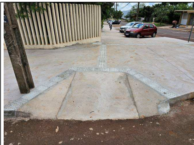
Figura 37: Piso Podotátil – Passeio Público.
