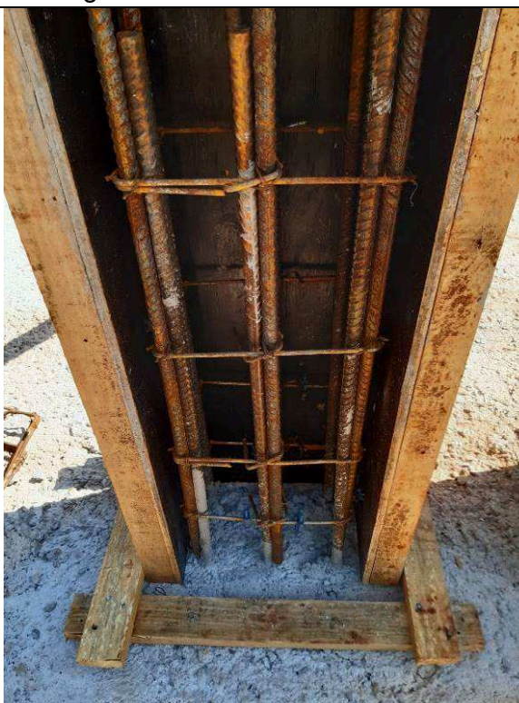
Figura 10: Pilares 1º Pavimento.
