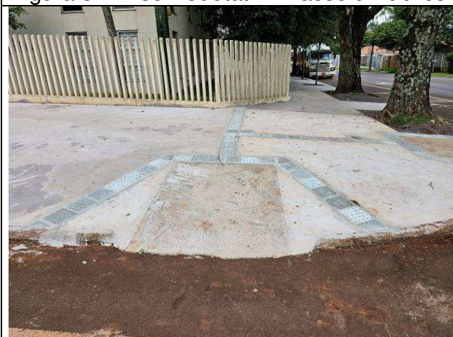
Figura 39: Piso Podotátil – Passeio Público.
