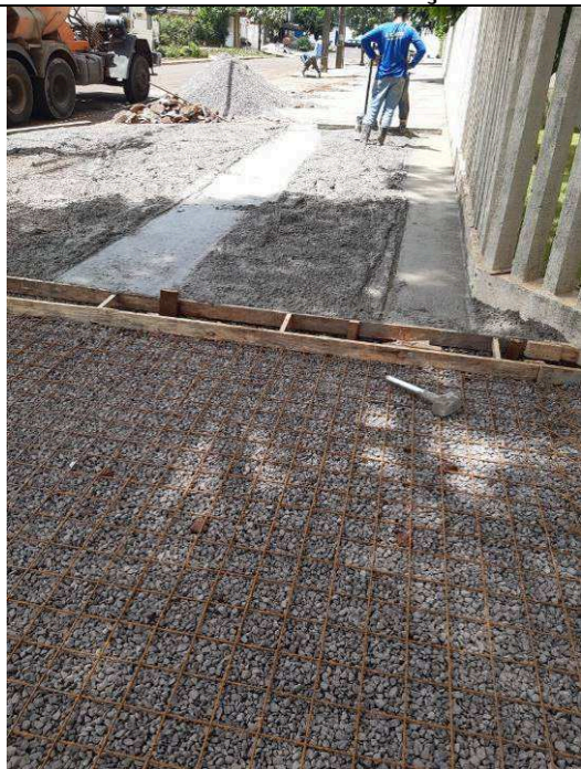
Figura 17: Concretagem – Calçada Parecis.
