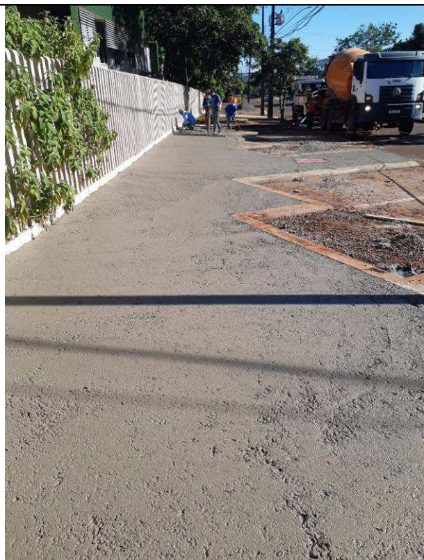
Figura 19: Concretagem – Calçada Parecis.
