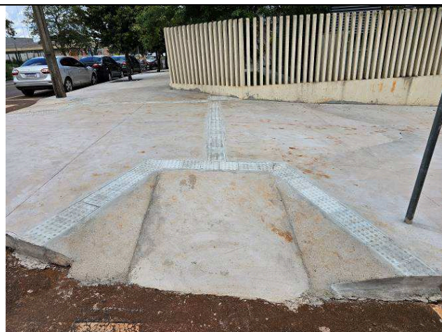
Figura 38: Piso Podotátil – Passeio Público.
