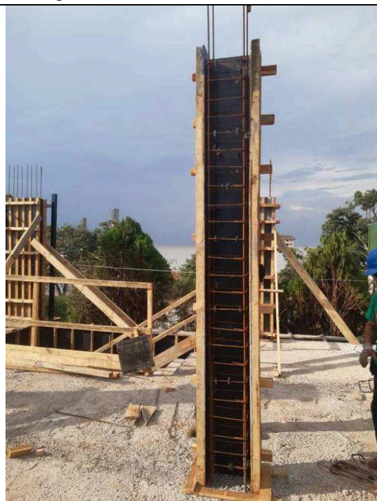
Figura 06: Pilares 1º Pavimento.
