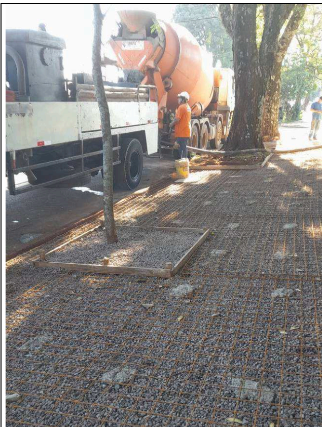
Figura 27: Concretagem – Guaracas.
