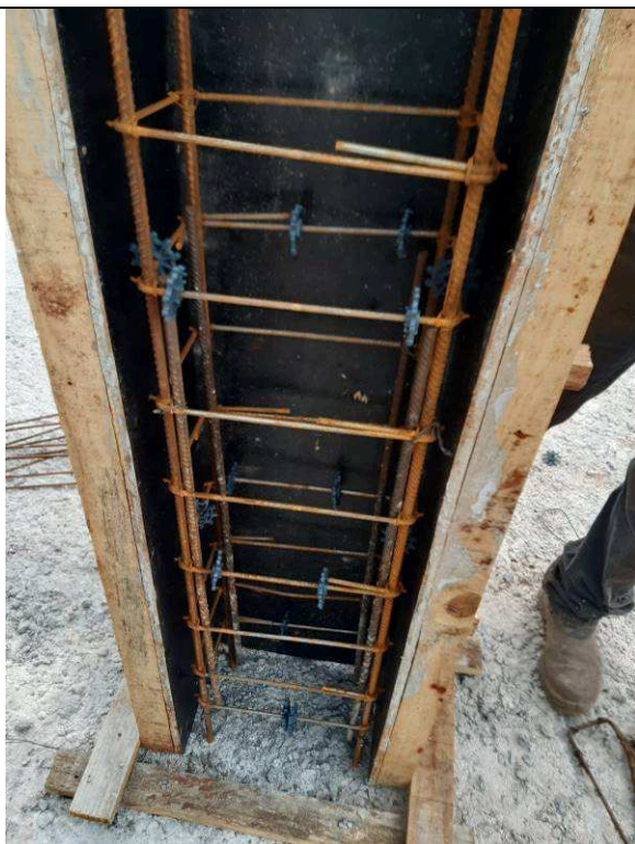
Figura 07: Pilares 1º Pavimento.
