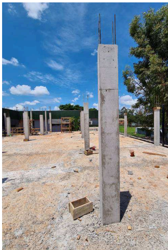
Figura 14: Pilares 1º Pavimento.
