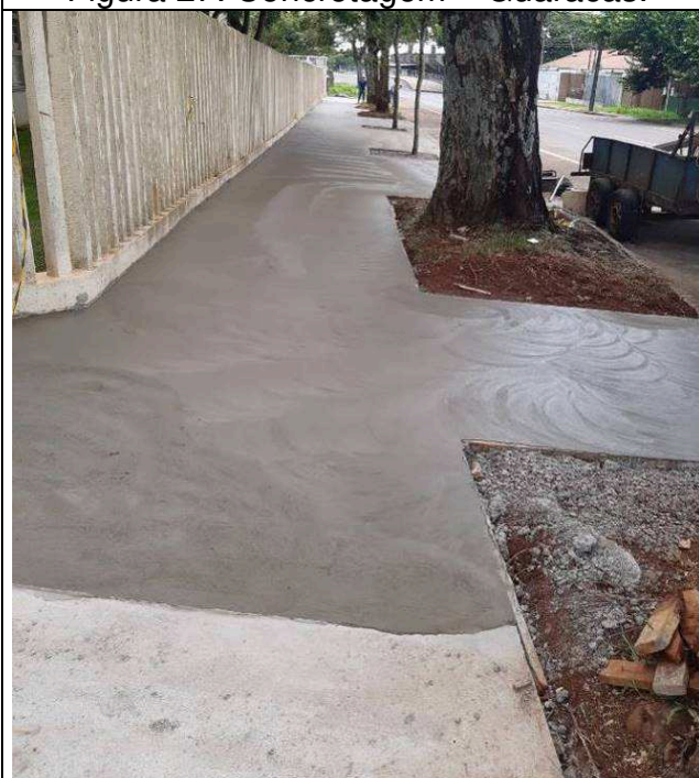
Figura 29: Concretagem – Guaracas.
