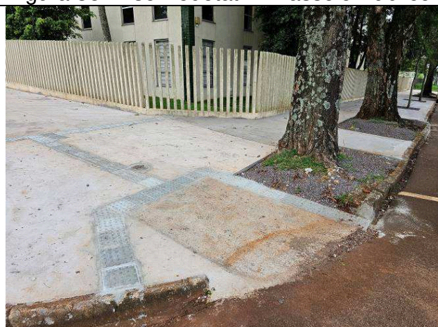
Figura 40: Piso Podotátil – Passeio Público.
