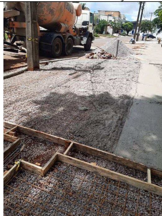
Figura 18: Concretagem – Calçada Parecis.
