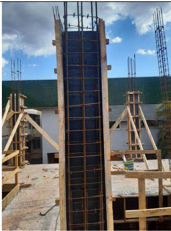
Figura 04: Pilares 1º Pavimento.
