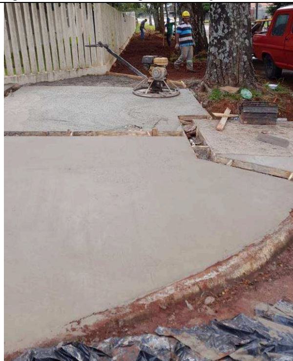
Figura 22: Concretagem – Calçada Parecis.
