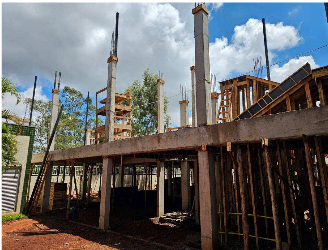
Figura 2 – Vista da laje e dos pilares do 1º pavimento.
