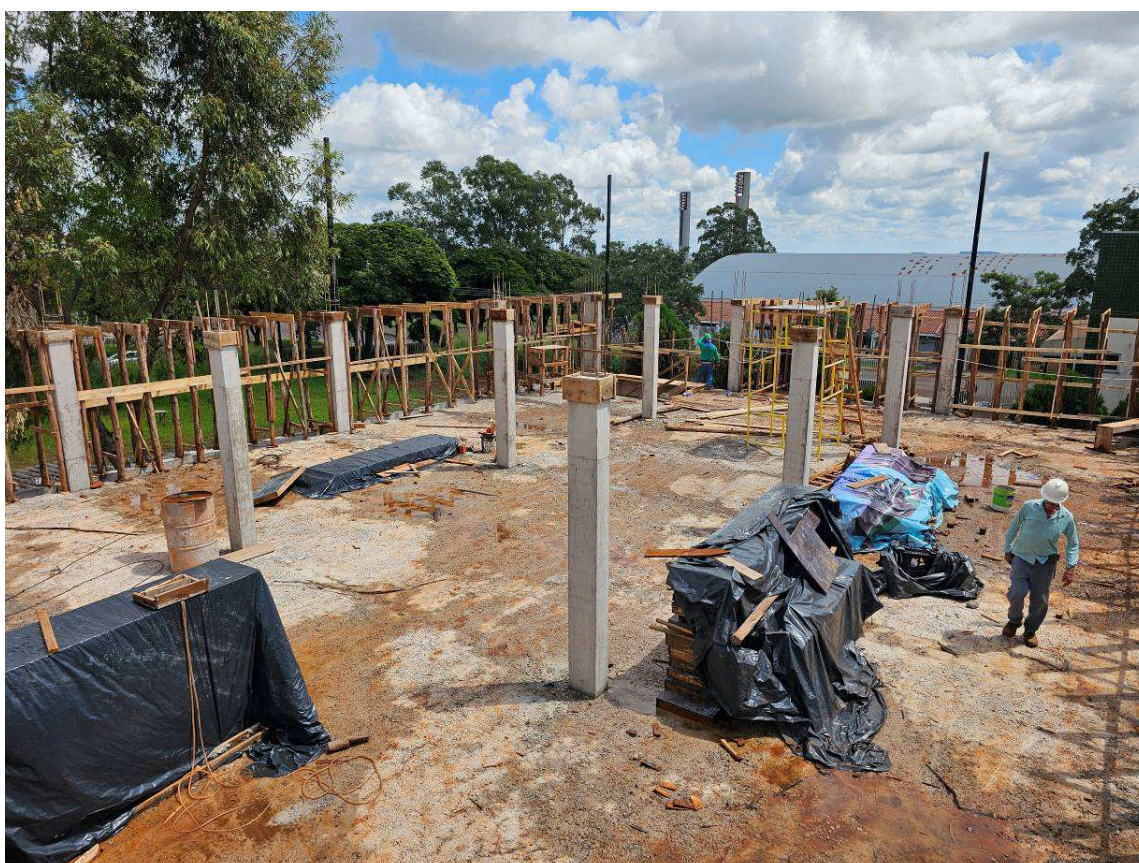
Figura 1 – Vista da laje e dos pilares do 1º pavimento.
