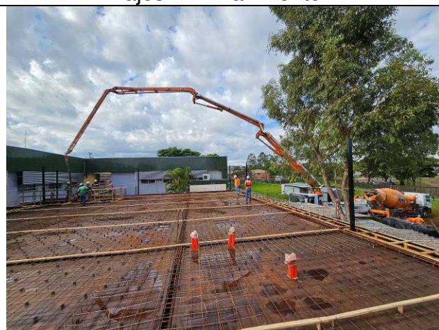
Figura 23: Concretagem – vigas e lajes – 1º Pavimento.
