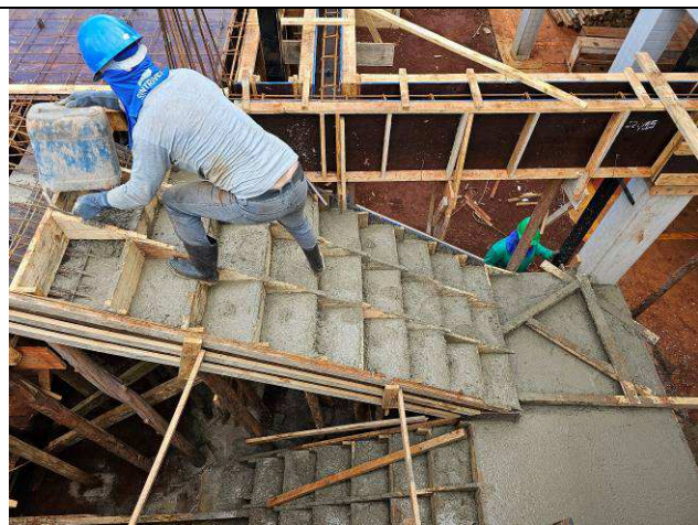
Figura 26: Concretagem – vigas e lajes – 1º Pavimento.
