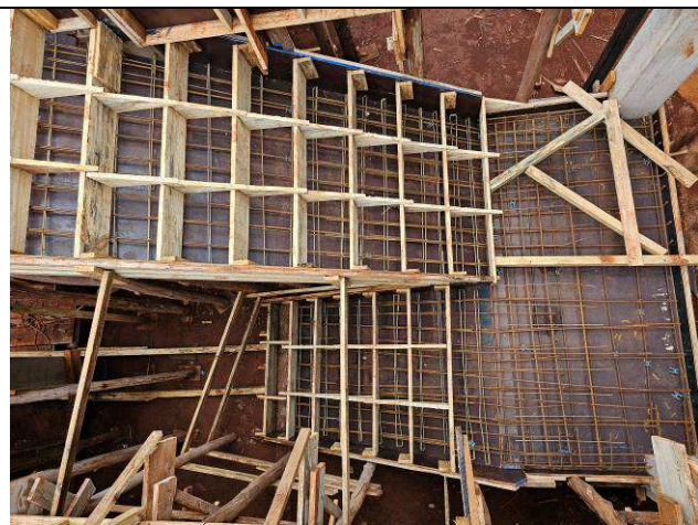
Figura 19: Formas e armaduras – vigas e lajes – 1º Pavimento.
