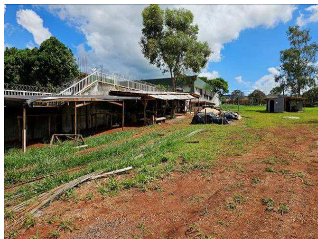
Figura 02: Canteiro de obras.
