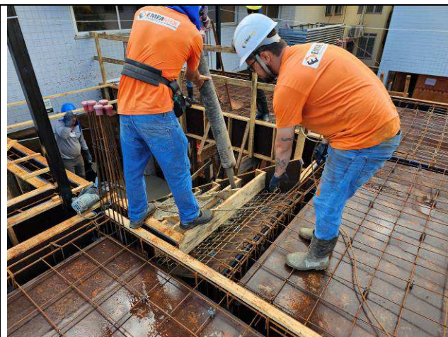
Figura 25: Concretagem – vigas e lajes – 1º Pavimento.
