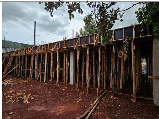
Figura 11: Montagem de formas e armaduras – vigas e lajes – 1º Pavimento.
