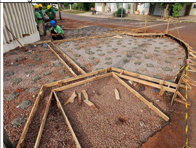
Figura 45: Formas das rampas e meio fio.
