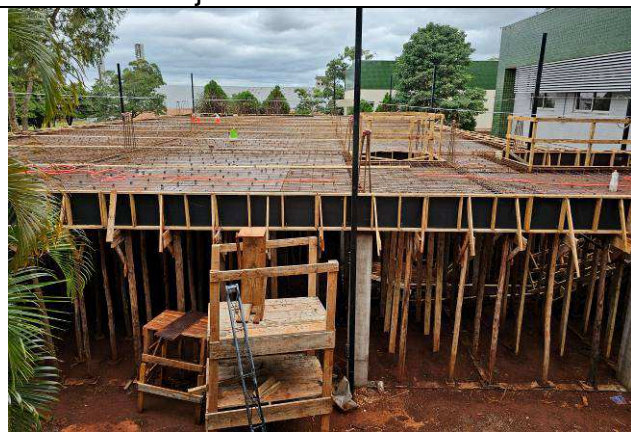
Figura 22: Formas e armaduras – vigas e lajes – 1º Pavimento.
