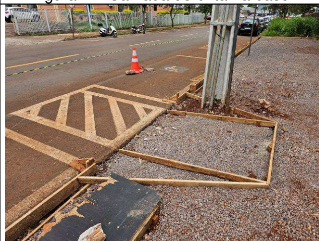
Figura 46: Formas das rampas e meio fio.
