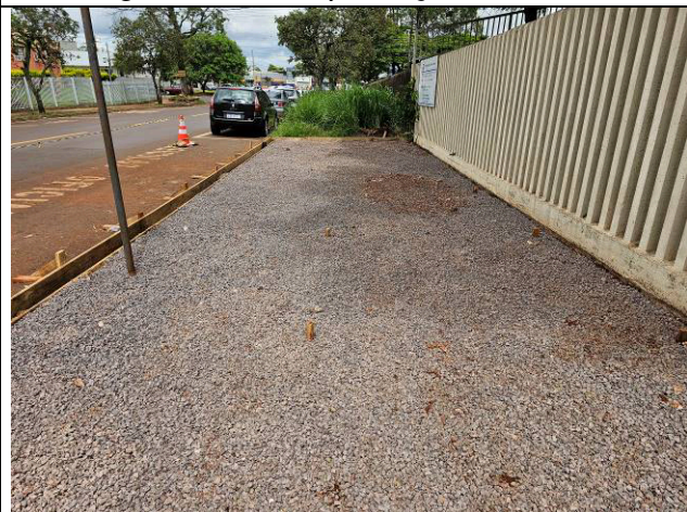
Figura 44: Camada de brita na base.
