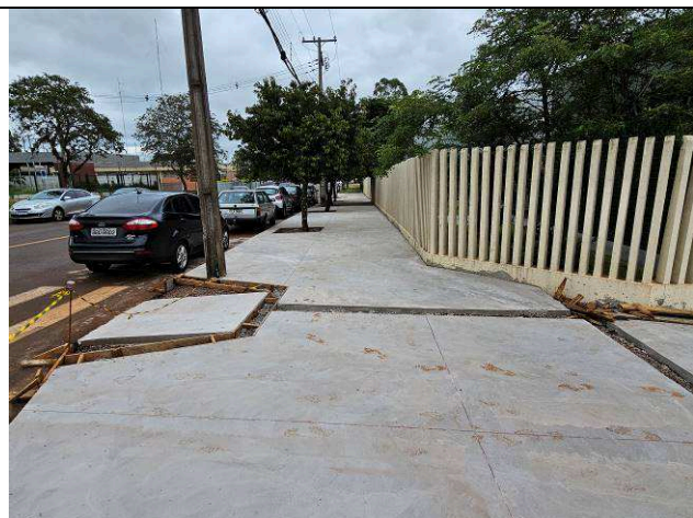
Figura 56: Calçada concretada.
