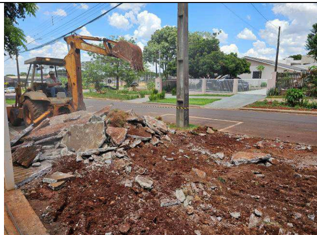
Figura 36: Demolição da calçada existente.
