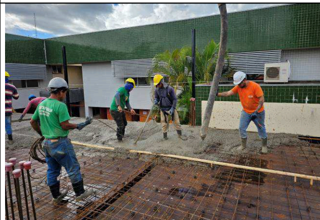
Figura 29: Concretagem – vigas e lajes – 1º Pavimento.
