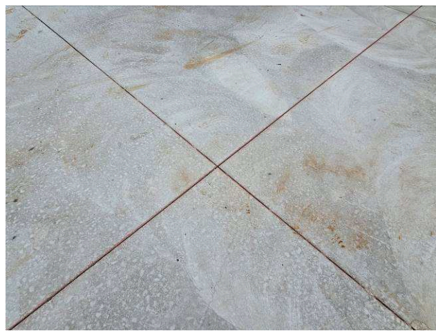
Figura 54: Corte do concreto.
