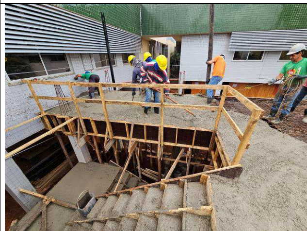
Figura 27: Concretagem – vigas e lajes – 1º Pavimento.
