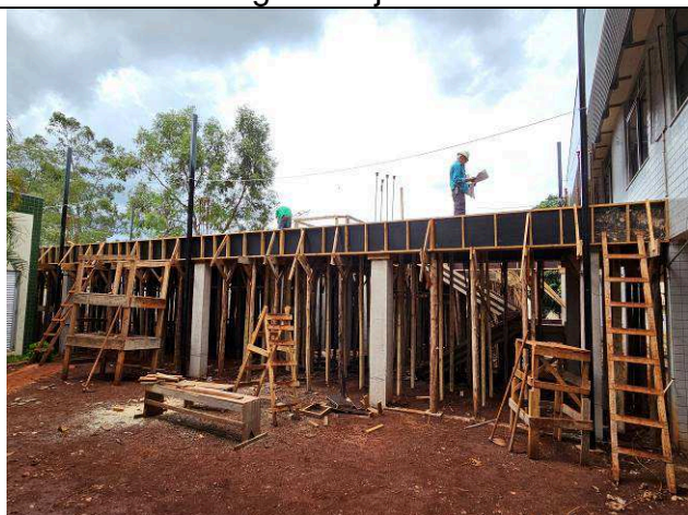
Figura 12: Montagem de formas e armaduras – vigas e lajes – 1º Pavimento.
