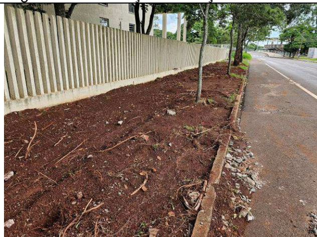
Figura 38: Demolição da calçada existente.
