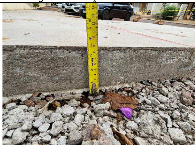
Figura 58: Calçada - espessura.
