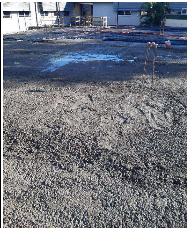
Figura 31: Concretagem – vigas e lajes – 1º Pavimento.
