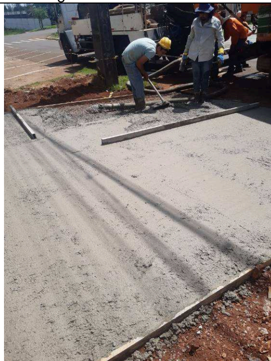
Figura 50: Concretagem da calçada.
