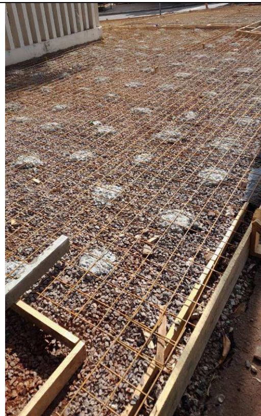
Figura 48: Telas metálicas.
