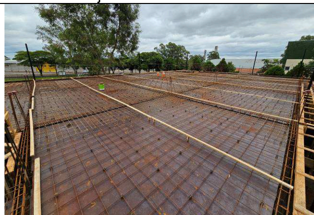
Figura 21: Formas e armaduras – vigas e lajes – 1º Pavimento.
