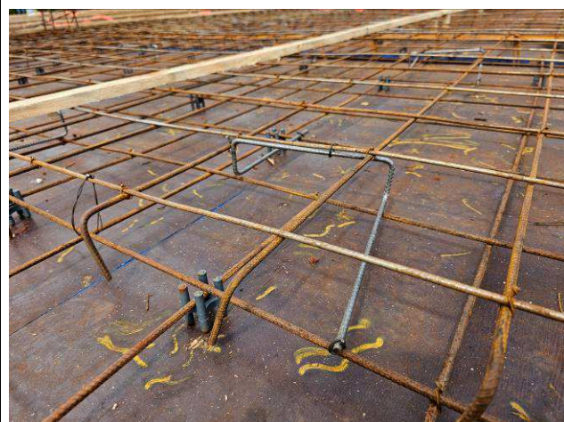
Figura 18: Formas e armaduras – vigas e lajes – 1º Pavimento.
