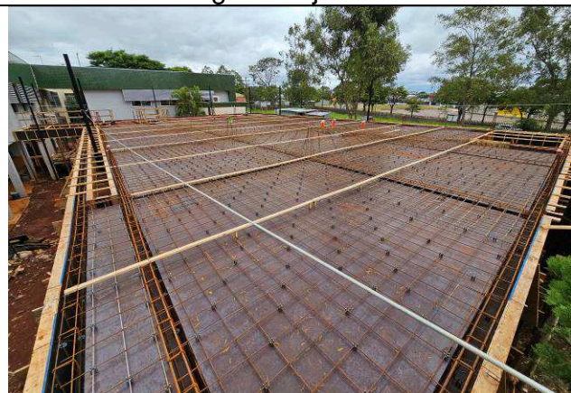
Figura 13: Formas e armaduras – vigas e lajes – 1º Pavimento.
