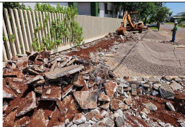
Figura 03: Remoção de entulhos da demolição do passeio público.
