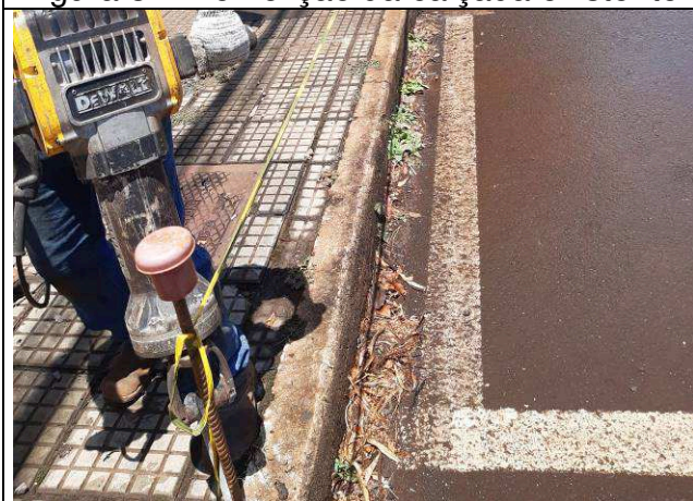
Figura 39: Demolição da calçada existente.
