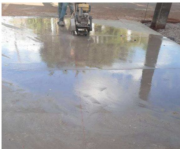
Figura 53: Corte do concreto.
