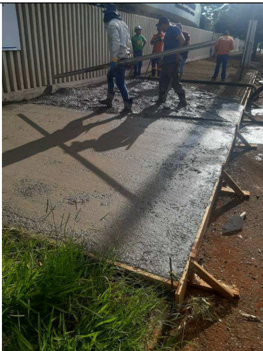
Figura 49: Concretagem da calçada.
