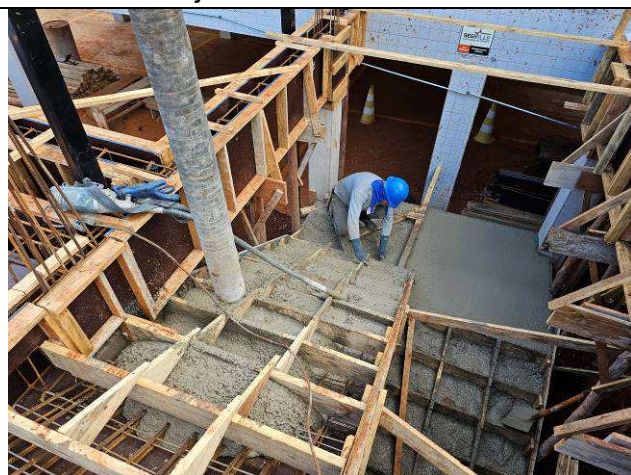
Figura 24: Concretagem – vigas e lajes – 1º Pavimento.
