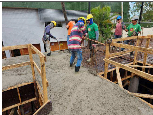
Figura 28: Concretagem – vigas e lajes – 1º Pavimento.
