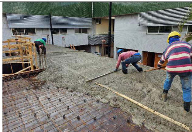
Figura 30: Concretagem – vigas e lajes – 1º Pavimento.
