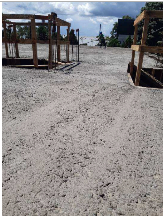
Figura 33: Concretagem – vigas e lajes – 1º Pavimento.
