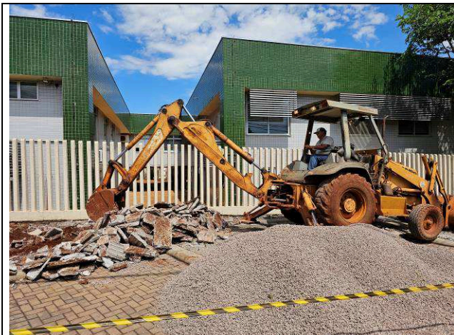
Figura 35: Demolição da calçada existente.
