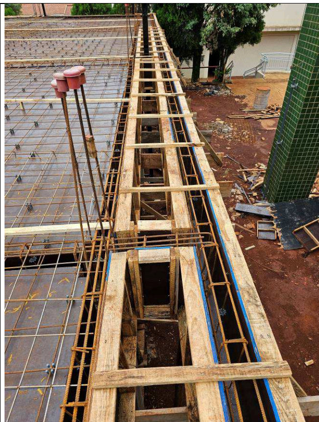
Figura 15: Formas e armaduras – vigas e lajes – 1º Pavimento.
