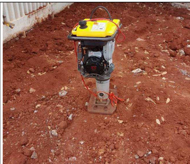
Figura 41: Compactação da base.
