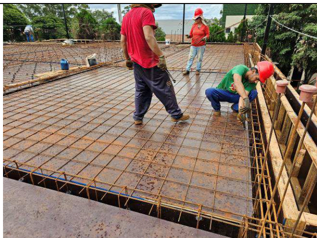
Figura 10: Montagem de formas e armaduras – vigas e lajes – 1º Pavimento.
