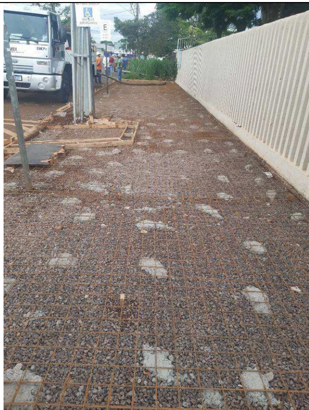
Figura 47: Telas metálicas.
