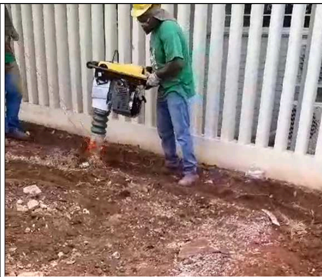
Figura 42: Compactação da base.
