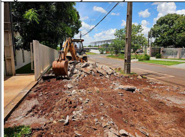
Figura 37: Demolição da calçada existente.
