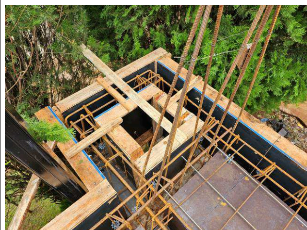
Figura 17: Formas e armaduras – vigas e lajes – 1º Pavimento.
