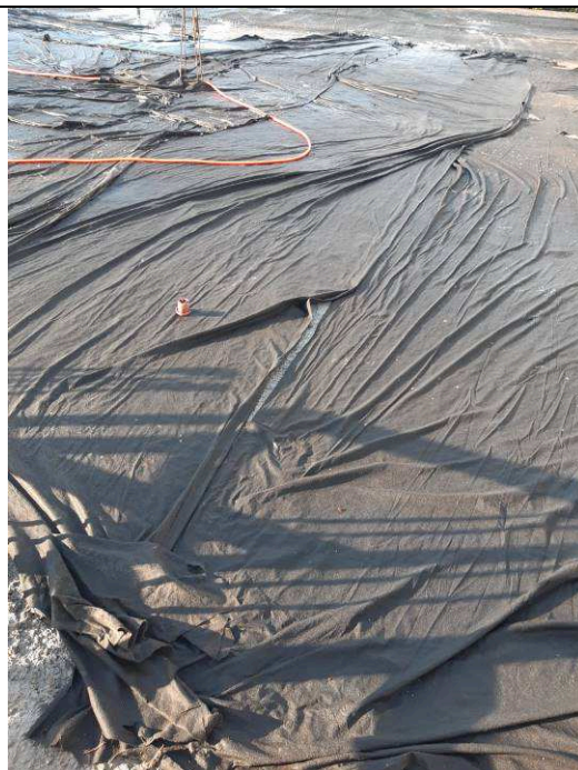
Figura 34: Concretagem – vigas e lajes – 1º Pavimento.
