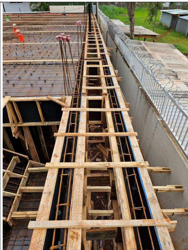
Figura 16: Formas e armaduras – vigas e lajes – 1º Pavimento.
