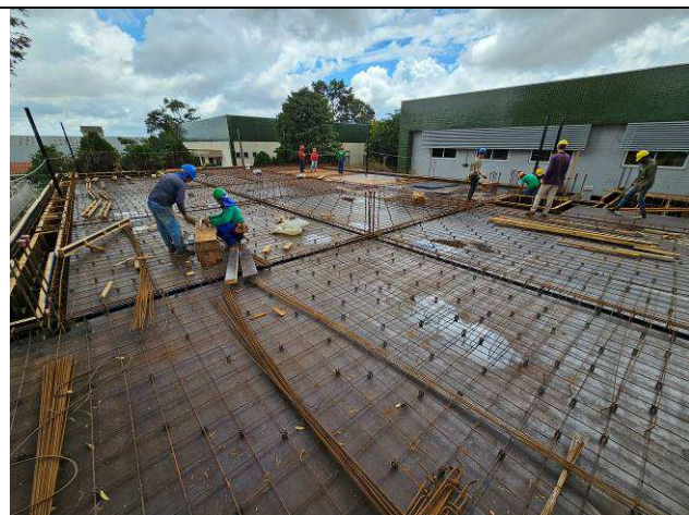
Figura 09: Montagem de formas e armaduras – vigas e lajes – 1º Pavimento.
