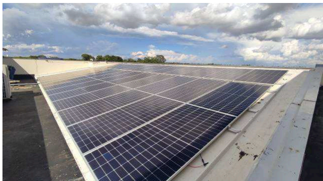
Figuras 01 – Cobertura com placas instaladas - Setorial
