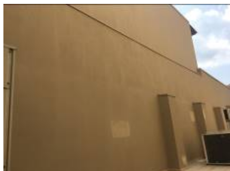
Figura 07 – Pintura Muro Fundos
