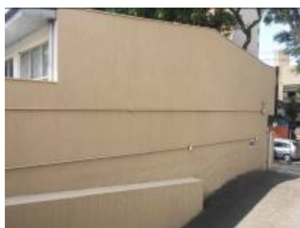
Figura 06 – Pintura Muro lateral direita
