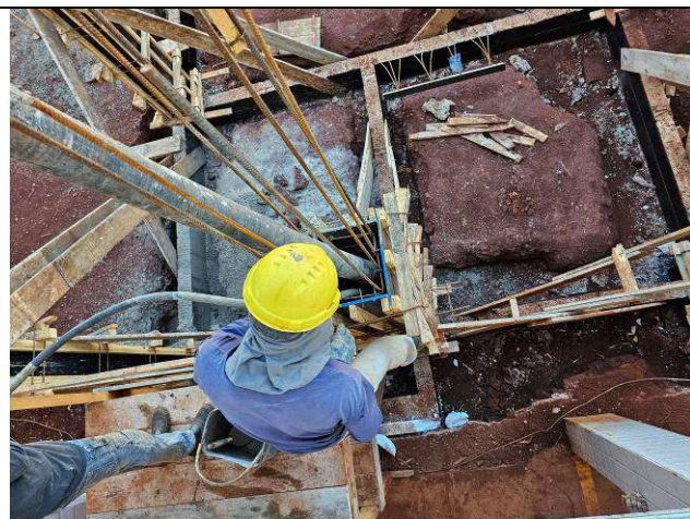
Figura 47: Concretagem dos pilares.
