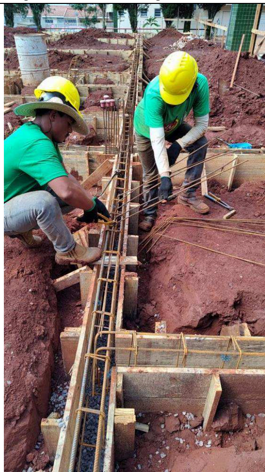
Figura 12: Armação Vigas Baldrames.
