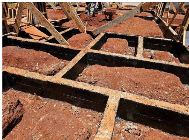
Figura 26: Impermeabilização - baldrames.
