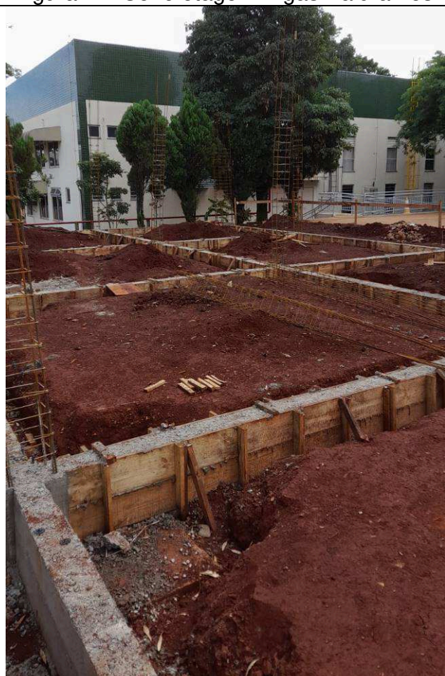
Figura 23: Desforma Vigas Baldrames.
