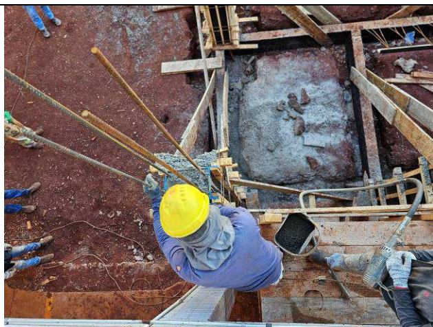
Figura 48: Concretagem dos pilares.
