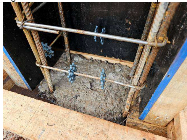
Figura 35: Formas e armaduras dos pilares.
