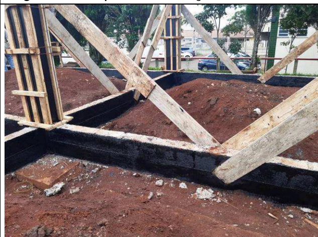
Figura 27: Impermeabilização - baldrames.
