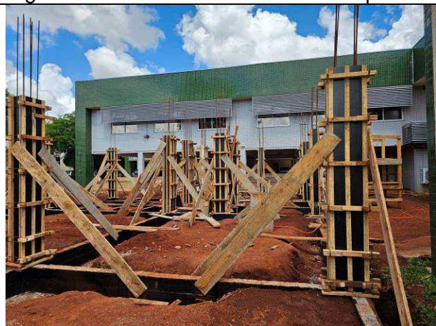
Figura 34: Formas e armaduras dos pilares.
