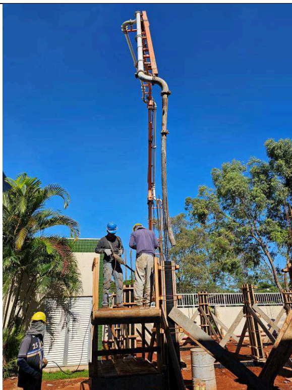
Figura 43: Concretagem dos pilares.
