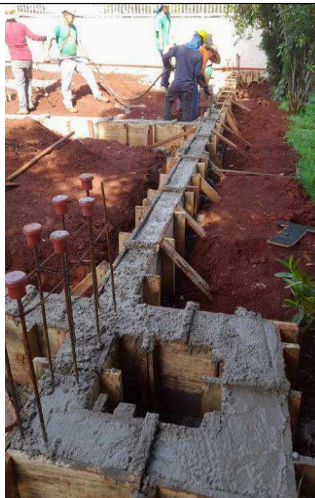
Figura 18: Concretagem Vigas Baldrames.
