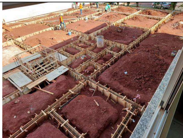
Figura 21: Concretagem Vigas Baldrames.
