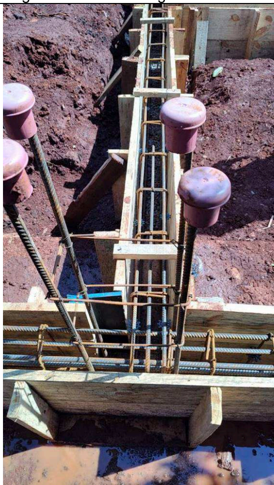
Figura 11: Armação Vigas Baldrames.
