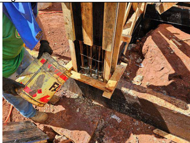
Figura 36: Formas e armaduras dos pilares.
