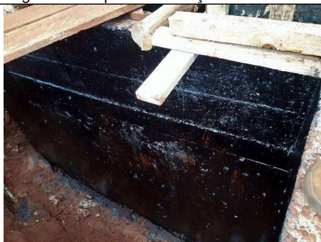
Figura 30: Impermeabilização – parede poço do elevador.
