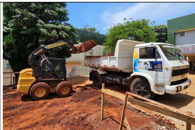
Figura 03: Remoção do excesso de terra.
