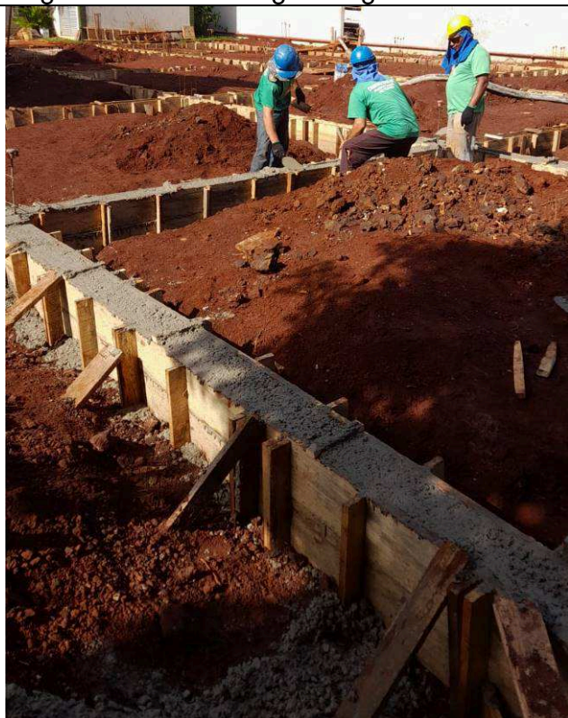
Figura 19: Concretagem Vigas Baldrames.
