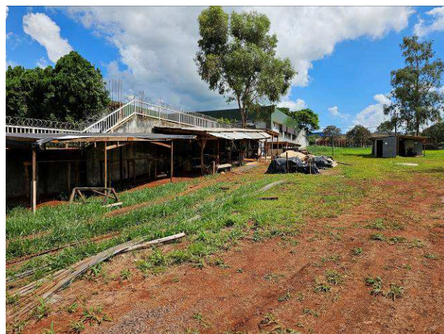
Figura 02: Canteiro de obras.
