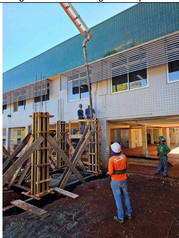
Figura 45: Concretagem dos pilares.
