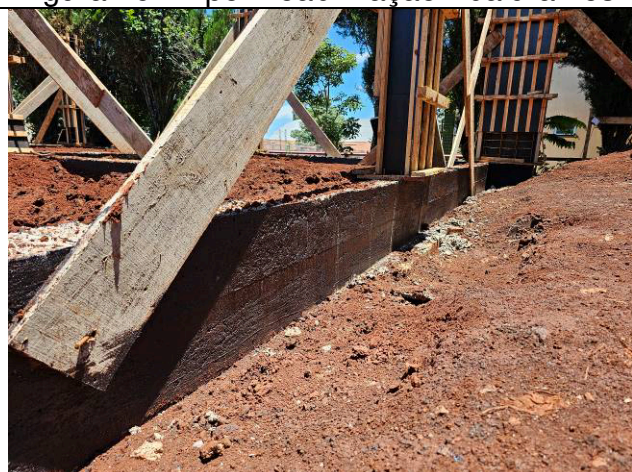
Figura 28: Impermeabilização - baldrames.
