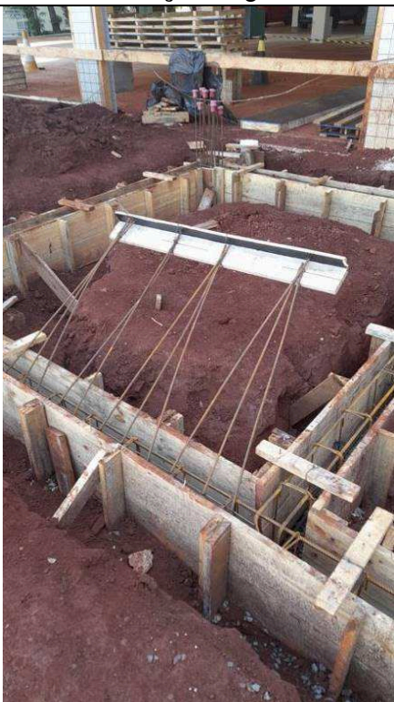
Figura 15: Armação Vigas Baldrames.
