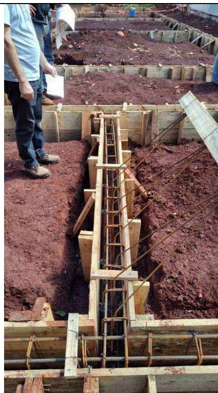
Figura 14: Armação Vigas Baldrames.
