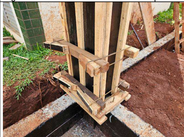
Figura 40: Formas e armaduras dos pilares.
