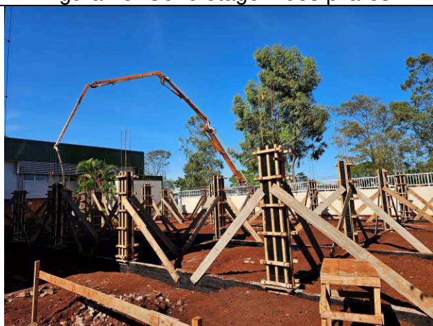
Figura 50: Concretagem dos pilares.
