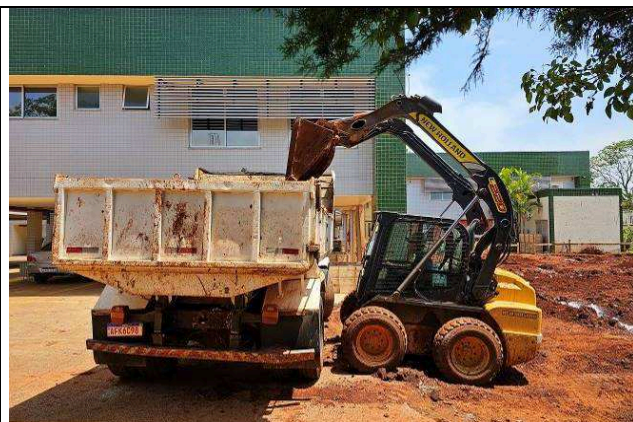
Figura 04: Remoção do excesso de terra.
