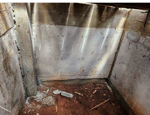
Figura 24: Vigas Baldrames e paredes de concreto armado – poço elevador.
