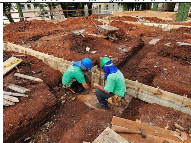
Figura 07: Formas Vigas Baldrames.
