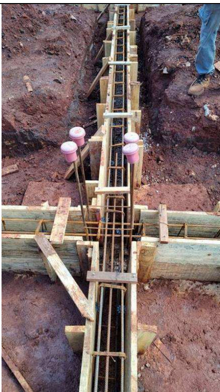
Figura 13: Armação Vigas Baldrames.
