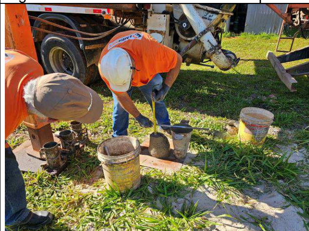
Figura 42: Concretagem dos pilares – Slump test.
