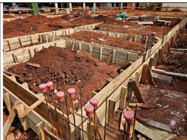
Figura 06: Formas Vigas Baldrames.
