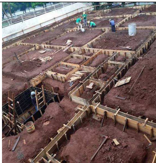
Figura 10: Formas Vigas Baldrames.
