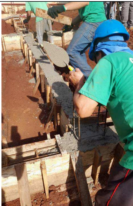
Figura 17: Concretagem Vigas Baldrames.
