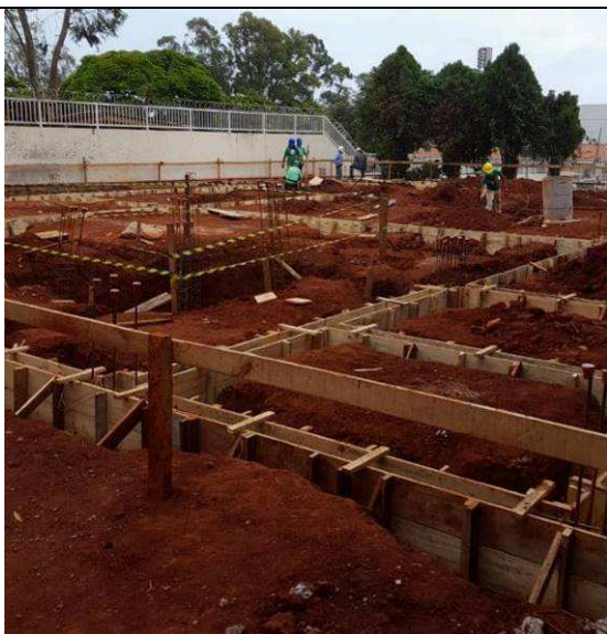
Figura 09: Formas Vigas Baldrames.
