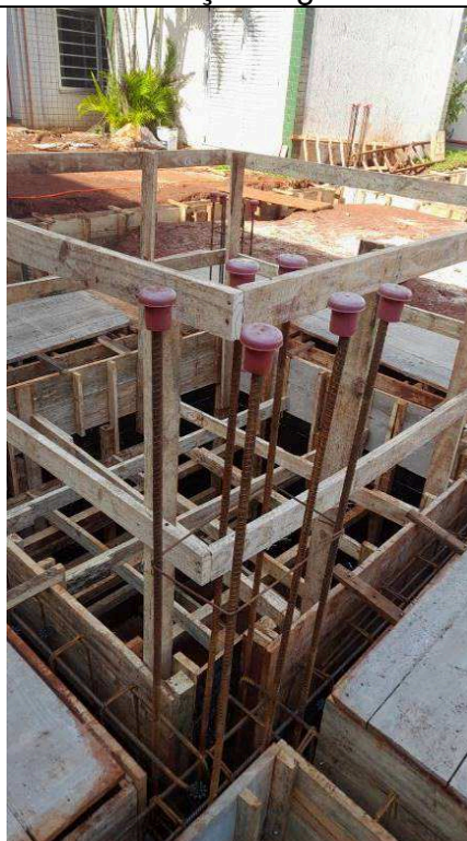
Figura 16: Armação Vigas Baldrames.
