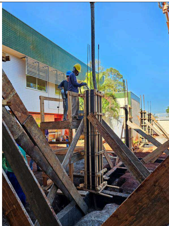
Figura 44: Concretagem dos pilares.
