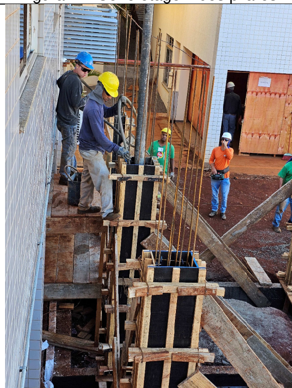
Figura 46: Concretagem dos pilares.
