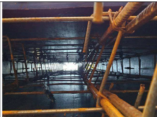
Figura 38: Formas e armaduras dos pilares.
