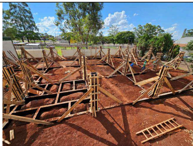
Figura 32: Formas e armaduras dos pilares.
