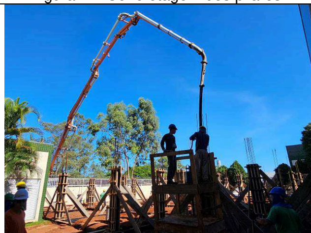
Figura 49: Concretagem dos pilares.
