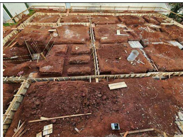
Figura 05: Formas Vigas Baldrames.
