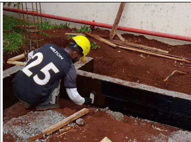
Figura 25: Impermeabilização - baldrames.
