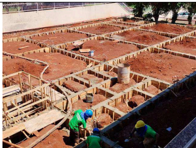
Figura 22: Concretagem Vigas Baldrames.
