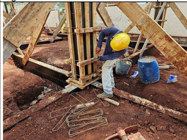
Figura 39: Formas e armaduras dos pilares.
