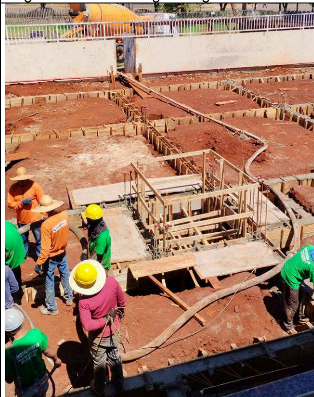
Figura 20: Concretagem Vigas Baldrames.
