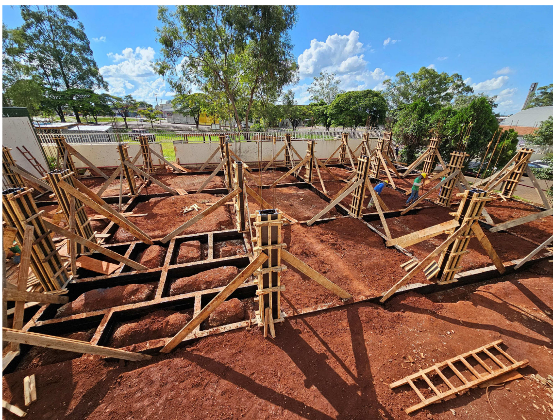
Figura 1 – Vista superior do canteiro de obras.
