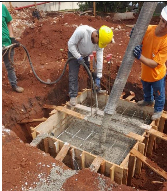
Figura 56: Concretagem dos blocos.
