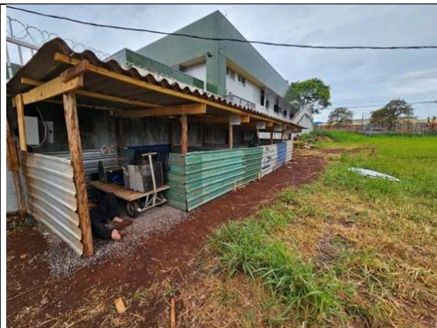
Figura 13: Depósito de Resíduos da Construção Civil.
