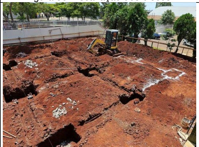
Figura 40: Escavação dos blocos.
