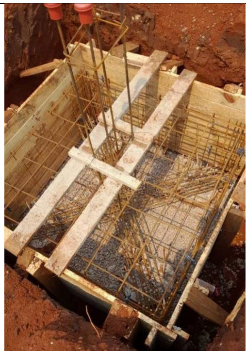
Figura 53: Formas e armaduras dos blocos.
