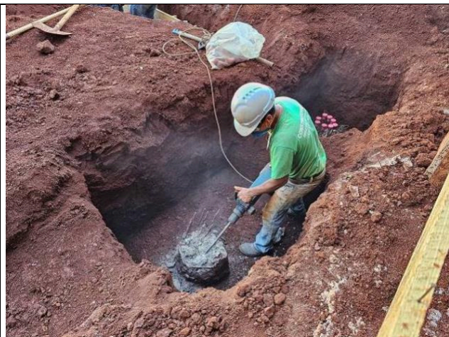
Figura 32: Arrasamento das estacas.
