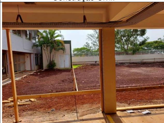
Figura 15: Gabarito de locação da obra.
