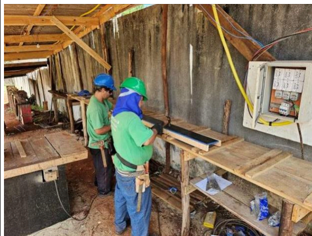
Figura 12: Canteiro de obra: cobertura para montagem de formas e armaduras.
