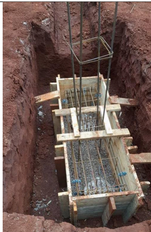
Figura 48: Formas e armaduras dos blocos.
