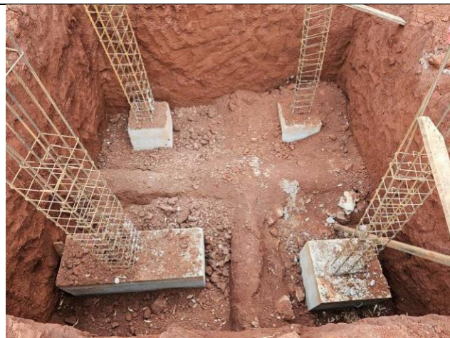
Figura 63: Blocos concretados.
