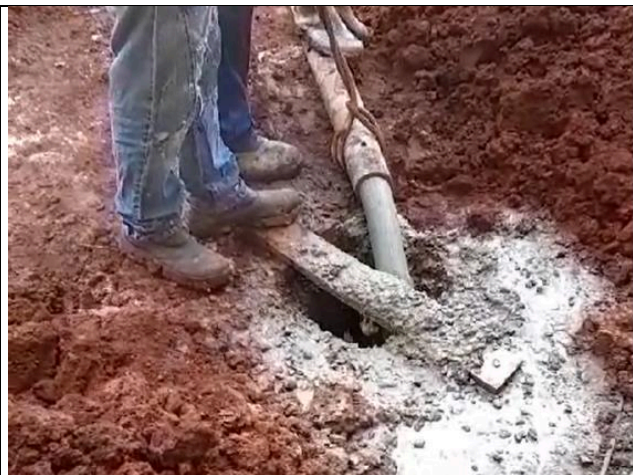
Figura 31: Concretagem das estacas.
