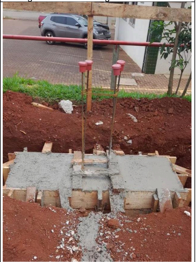
Figura 62: Concretagem dos blocos.
