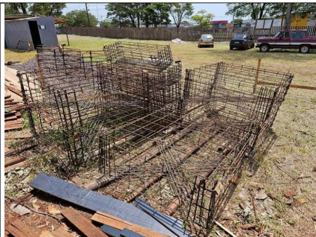
Figura 41: Armaduras dos blocos.
