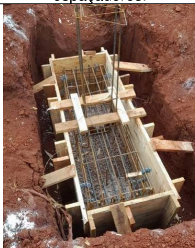
Figura 45: Formas e armaduras dos blocos.
