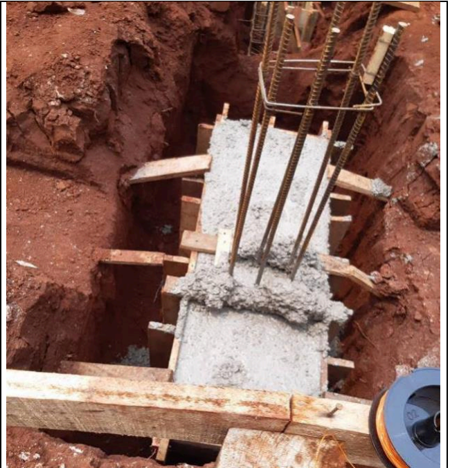
Figura 60: Concretagem dos blocos.
