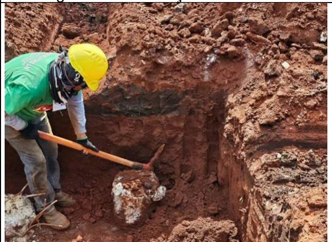
Figura 38: Escavação dos blocos.
