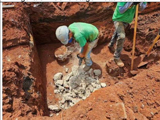
Figura 33: Arrasamento das estacas.
