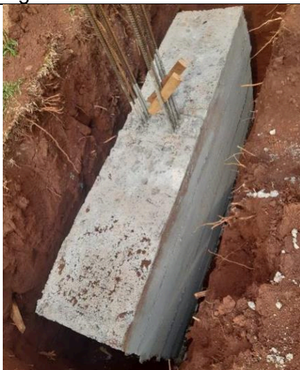
Figura 65: Blocos concretados.
