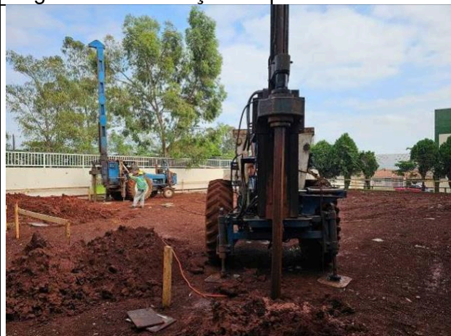
Figura 22: Perfuração das estacas.
