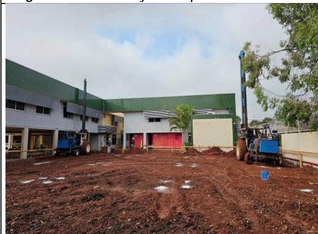
Figura 21: Perfuração das estacas.
