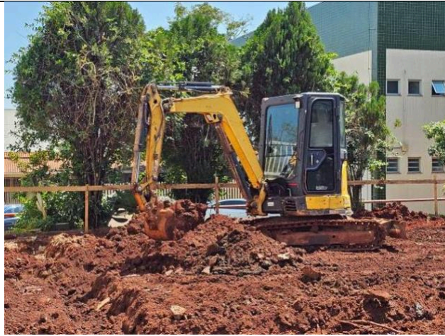
Figura 35: Escavação dos blocos.
