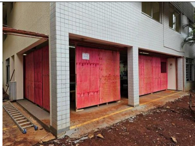
Figura 03: Canteiro de obra: escritório e refeitório.
