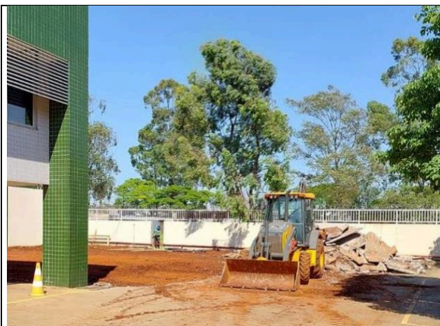
Figura 19: Demolição do piso de concreto.
