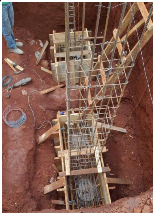
Figura 50: Formas e armaduras dos blocos.
