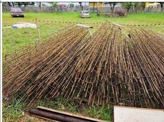
Figura 30: Armaduras das estacas.
