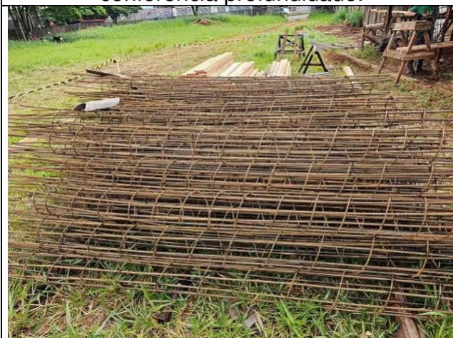
Figura 29: Armaduras das estacas.
