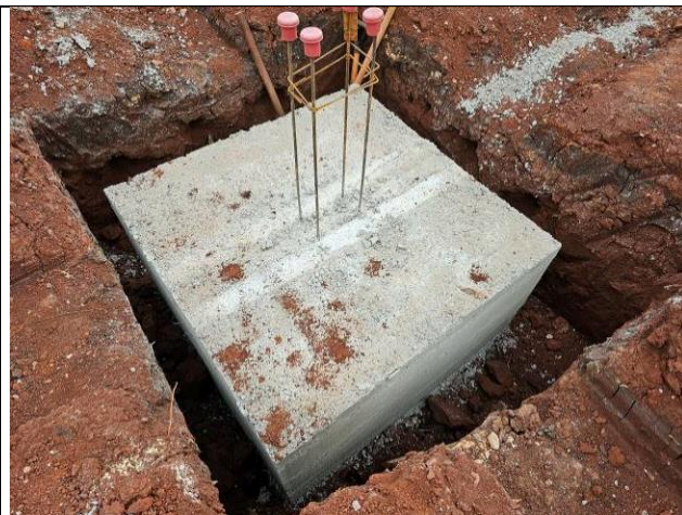
Figura 64: Blocos concretados.
