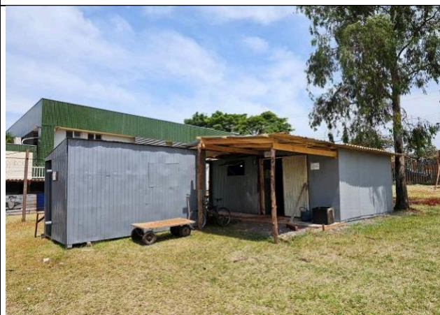
Figura 06: Canteiro de obra: almoxarifado, vestiário e sanitários.
