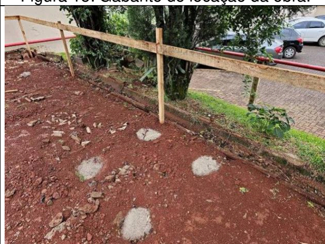
Figura 17: Gabarito de locação da obra.
