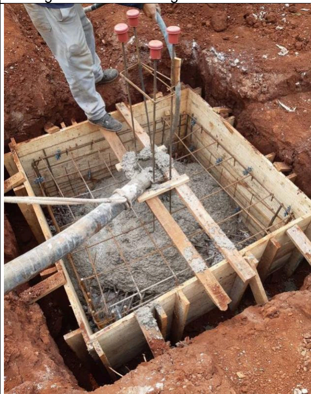
Figura 58: Concretagem dos blocos.
