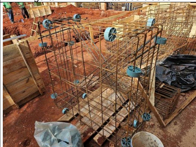
Figura 43: Armaduras dos blocos - espaçadores.
