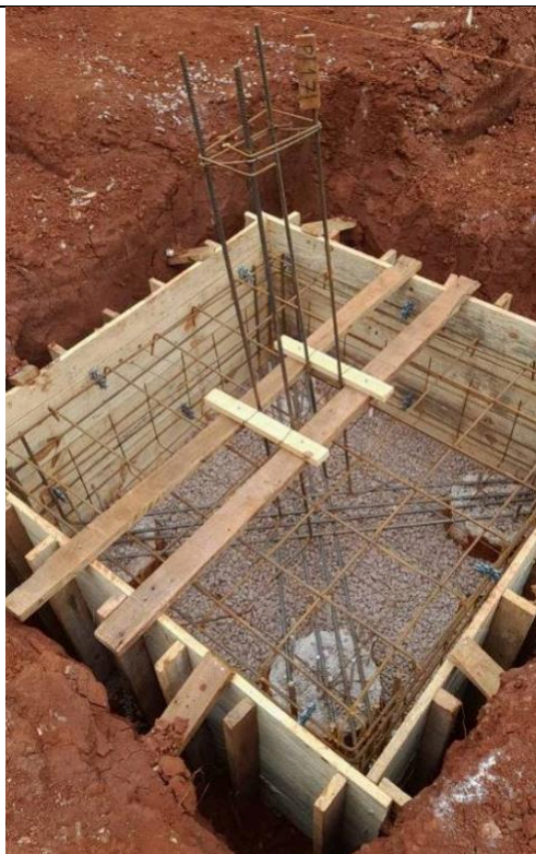
Figura 47: Formas e armaduras dos blocos.
