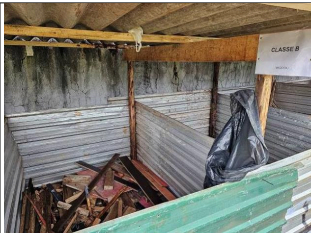
Figura 14: Depósito de Resíduos da Construção Civil.
