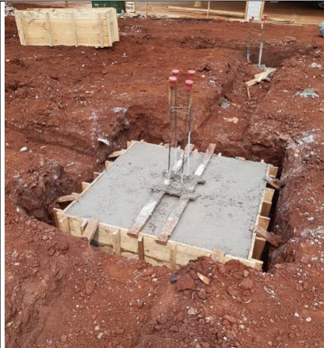
Figura 59: Concretagem dos blocos.
