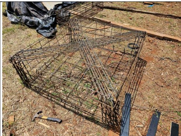
Figura 42: Armaduras dos blocos.
