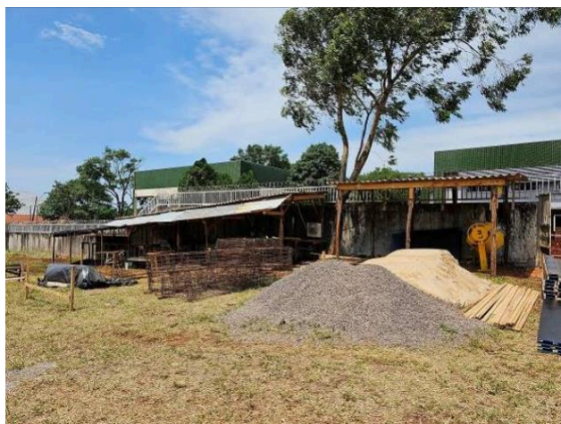
Figura 11: Canteiro de obra: cobertura para montagem de formas e armaduras.
