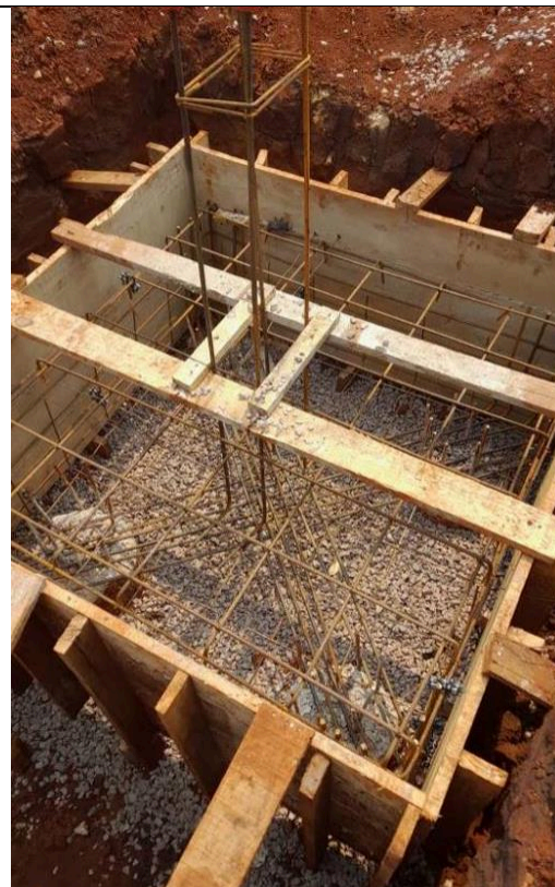
Figura 52: Formas e armaduras dos blocos.
