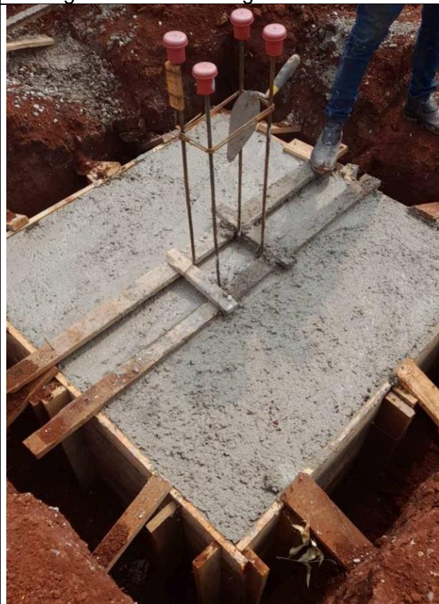
Figura 61: Concretagem dos blocos.
