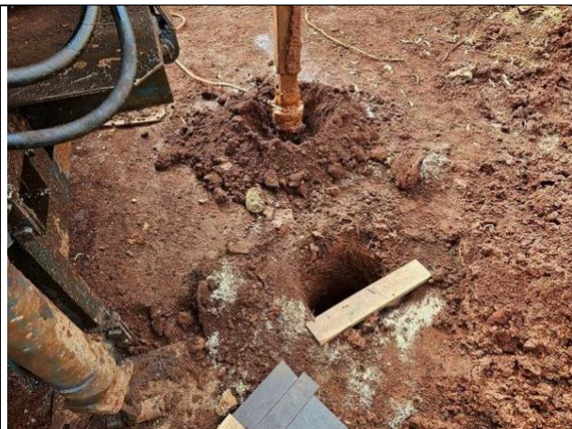
Figura 26: Perfuração das estacas.
