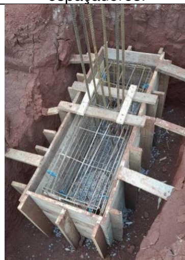
Figura 46: Formas e armaduras dos blocos.
