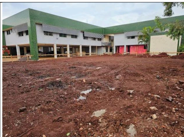
Figura 20: Demolição do piso de concreto.
