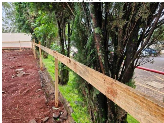
Figura 16: Gabarito de locação da obra.
