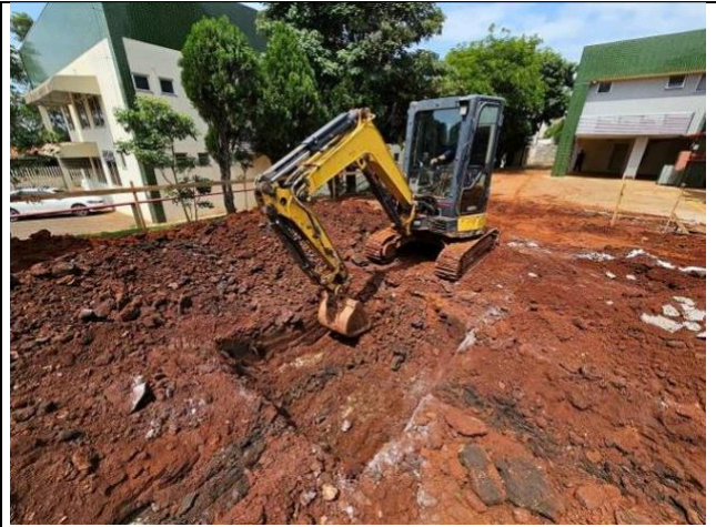
Figura 36: Escavação dos blocos.
