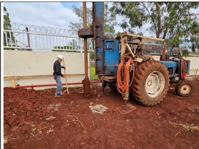
Figura 25: Perfuração das estacas.
