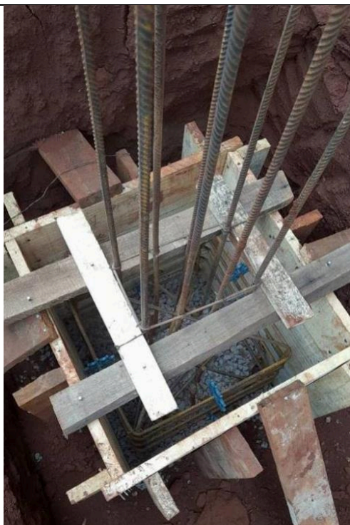
Figura 49: Formas e armaduras dos blocos.
