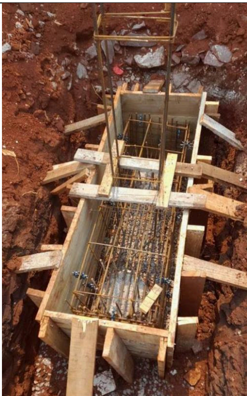
Figura 51: Formas e armaduras dos blocos.
