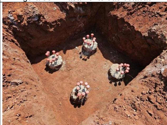
Figura 33: Arrasamento das estacas.
