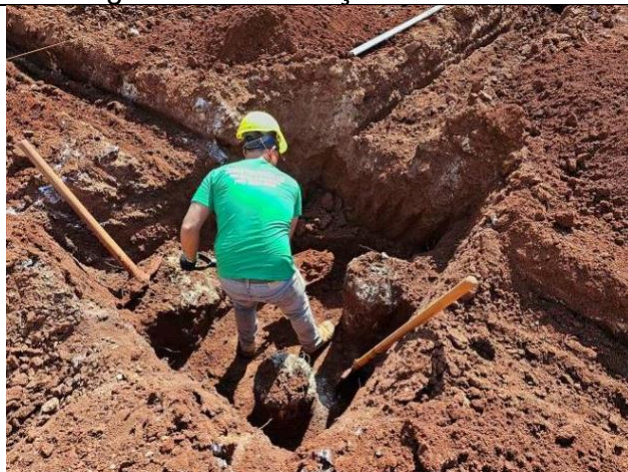
Figura 37: Escavação dos blocos.
