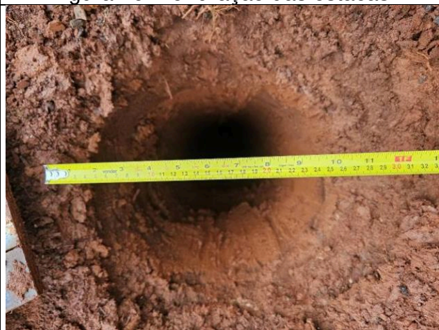
Figura 28: Perfuração das estacas – conferência diâmetro.
