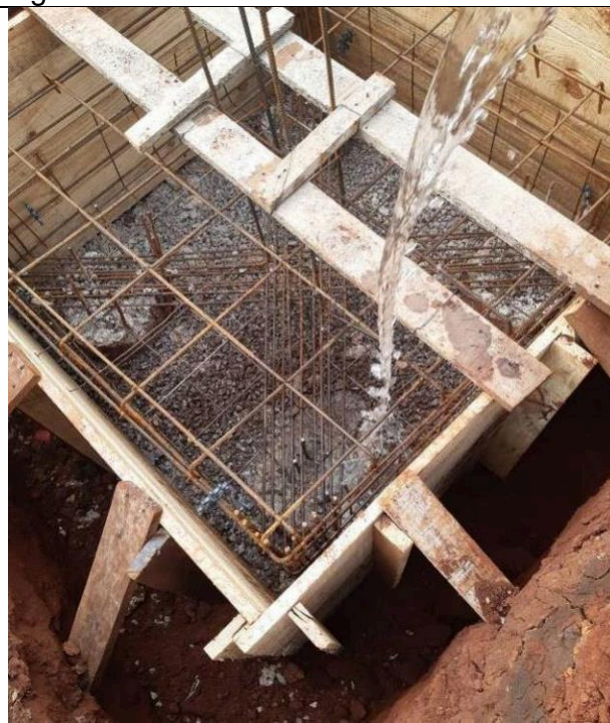
Figura 54: Limpeza blocos antes concreto.
