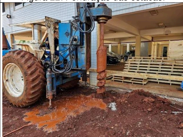
Figura 24: Perfuração das estacas.
