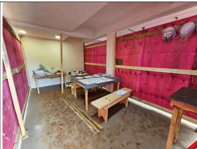
Figura 04: Canteiro de obra: escritório.
