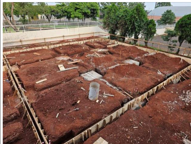
Figura 66: Blocos concretados.
