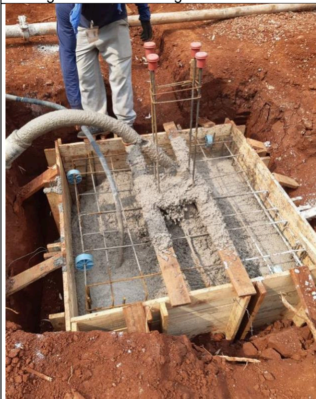
Figura 57: Concretagem dos blocos.
