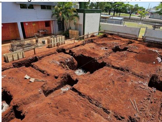
Figura 39: Escavação dos blocos.
