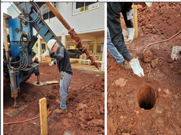
Figura 27: Perfuração das estacas – conferência profundidade.
