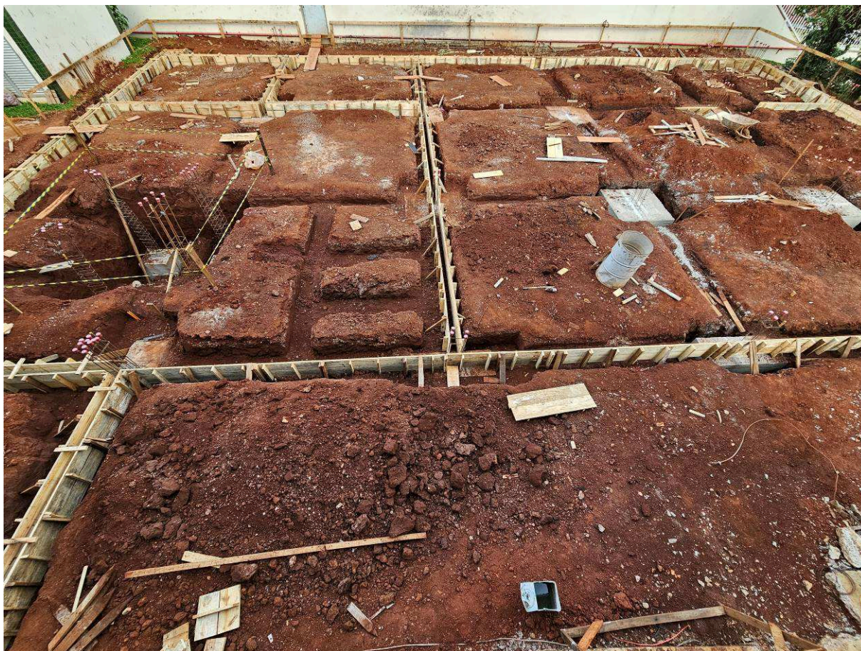
Figura 1 – Vista superior do canteiro de obras.
