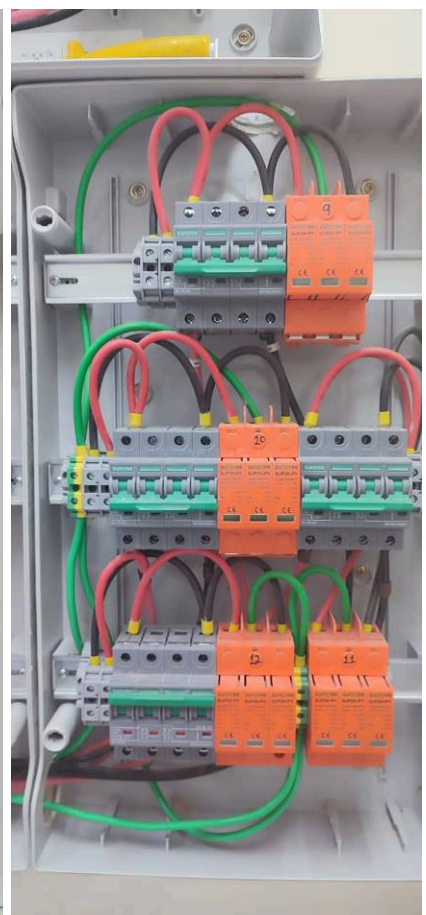
Figuras 04 – Proteções e inversores instalados – Paranaguá
