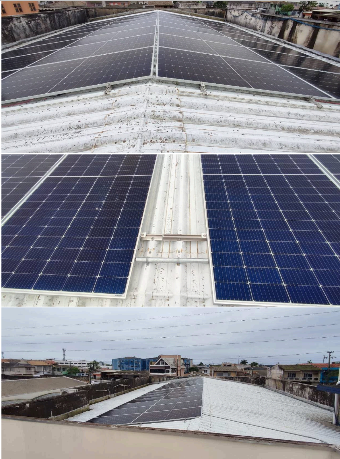
Figuras 03 – Cobertura com placas instaladas – Paranaguá
