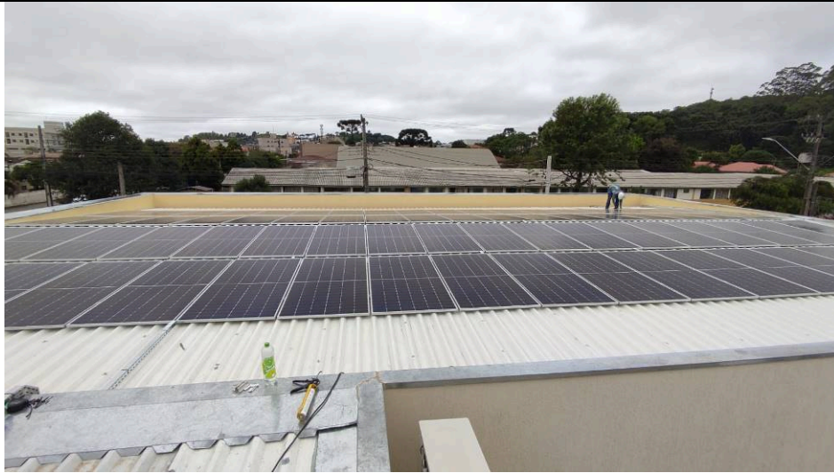
Figuras 01 – Cobertura com placas instaladas - Colombo
