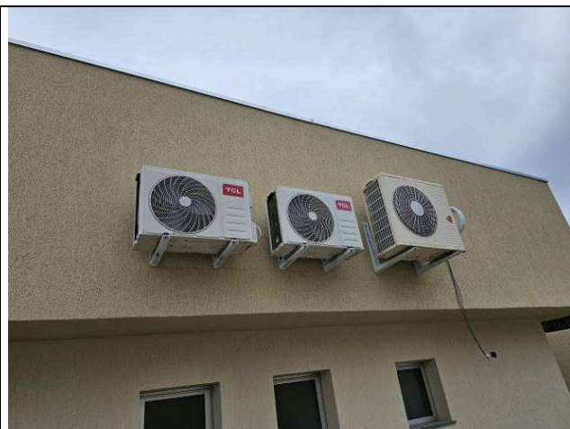
Figura 96: Condensadoras novas e reinstaladas - fundos.
