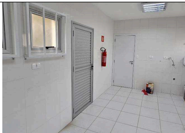
Figura 17: Porta de alumínio – acesso ao jardim interno.
