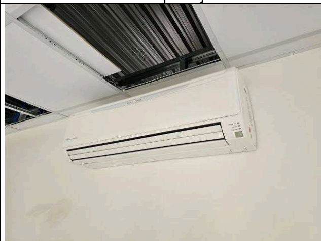
Figura 100: Evaporadora – reinstalada.
