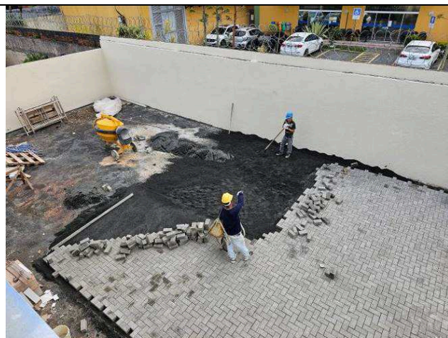
Figura 113: Paver - estacionamento.
