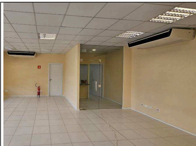
Figura 101: Evaporadoras – reinstaladas.
