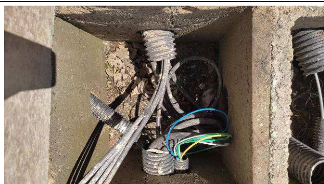
Figura 05E: infraestrutura externa
