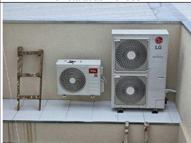
Figura 98: Condensadoras novas e reinstaladas – marquise jardim interno.
