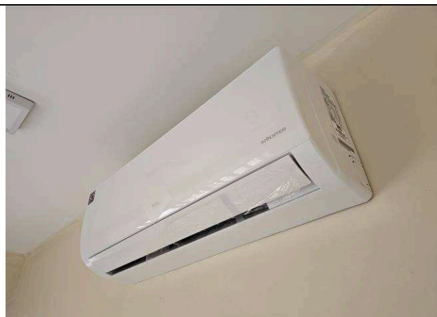
Figura 89: Evaporadora nova – 12.000 BTU's.
