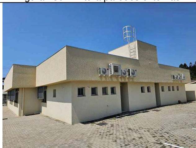
Figura 141: Pintura paredes externas.
