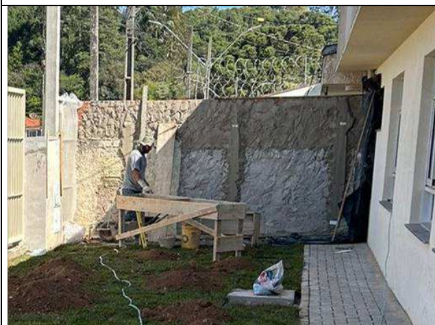
Figura 127: Muro de divisa frontal.
