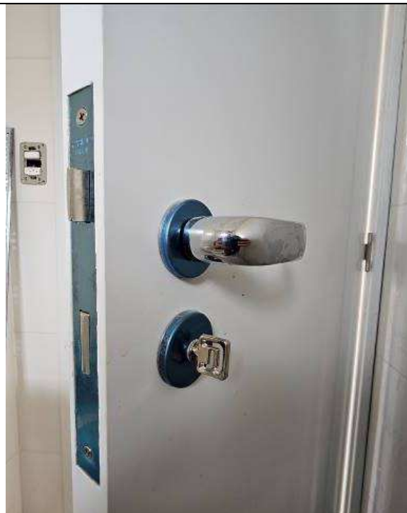
Figura 14: Porta de madeira – detalhe fechadura de porta de banheiro.
