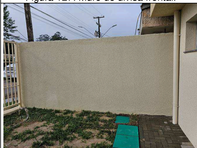
Figura 129: Muro de divisa frontal.
