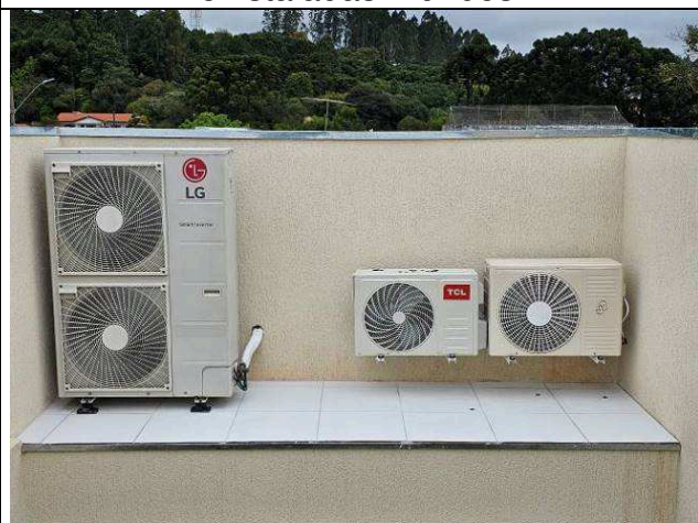
Figura 97: Condensadoras novas e reinstaladas – marquise jardim interno.
