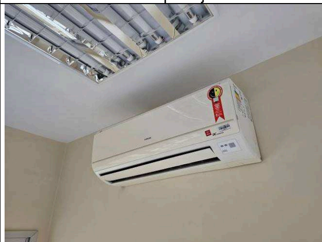
Figura 99: Evaporadora – reinstalada.
