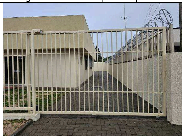
Figura 124: Portão de veículos.
