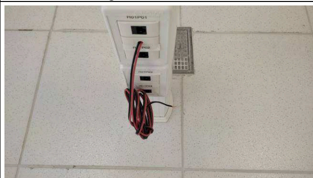
Figura 48E: pontos lógicos, sonorização, totem
