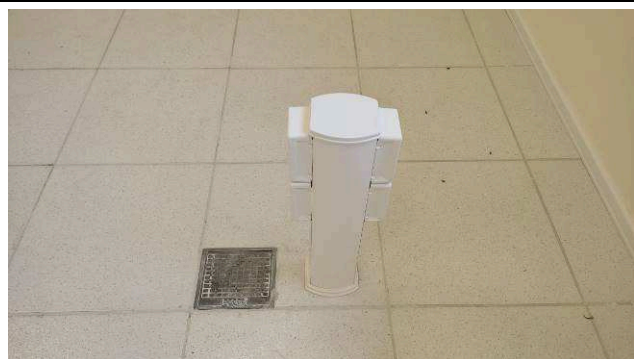
Figura 53E: totens e caixas Dutotec
