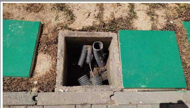
Figura 06E: infraestrutura externa
