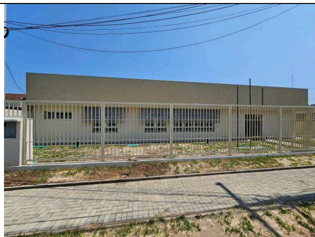
Figura 137: Pintura paredes externas.
