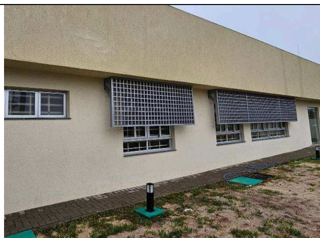
Figura 21: Brises de alumínio – fachada principal.
