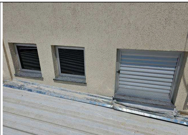
Figura 18: Porta de alumínio e janelas – acesso aos reservatórios.
