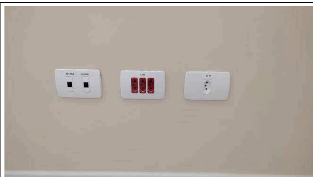
Figura 23E: tomadas elétricas, de rede lógica, interruptores e espelhos WEG
