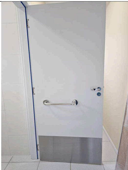
Figura 05: Porta de madeira – banheiro PNE Secretaria 1ª Vara.
