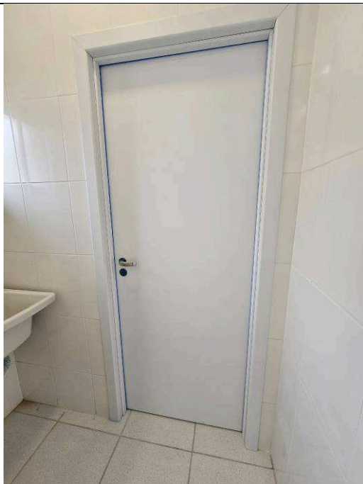
Figura 03: Porta de madeira – banheiro área terceirizados.
