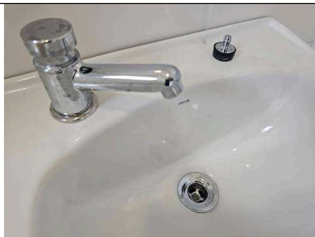
Figura 77: Torneira e válvula lavatório.
