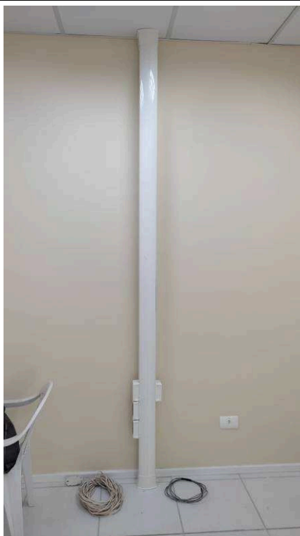
Figura 51E: colunas técnicas Dutotec
