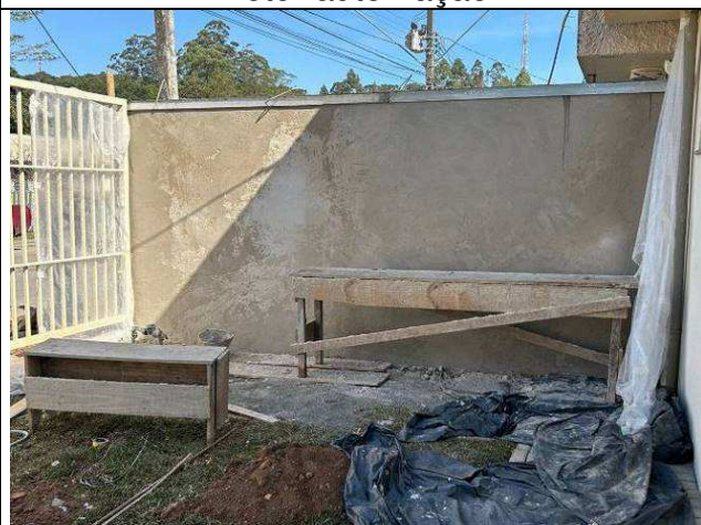
Figura 128: Muro de divisa frontal.
