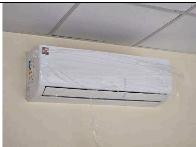
Figura 91: Evaporadora nova – 18.000 BTU's.
