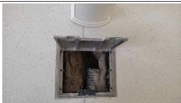
Figura 49E: caixa Dutotec tampa articulada
