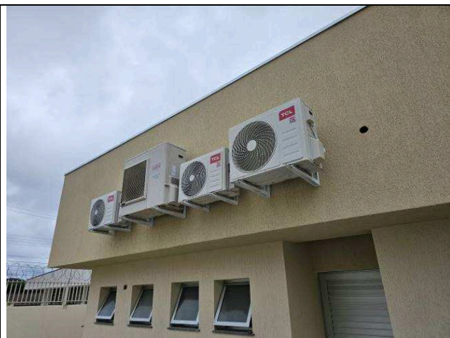
Figura 95: Condensadoras novas e reinstaladas - fundos.
