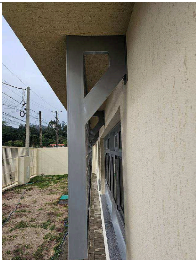
Figura 23: Brises de alumínio – fachada principal.
