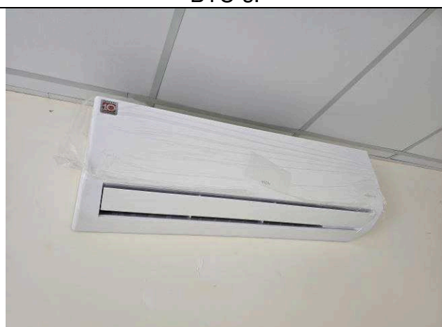
Figura 93: Evaporadora nova – 24.000 BTU's.
