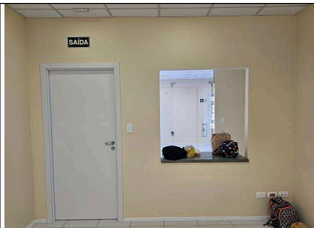
Figura 156: Pintura paredes internas – Secretaria 2ª Vara.
