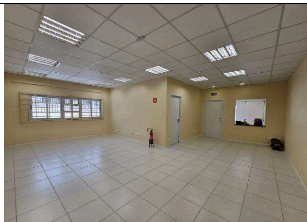
Figura 155: Pintura paredes internas – Secretaria 2ª Vara.
