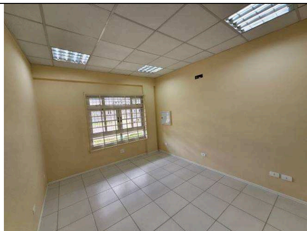
Figura 149: Pintura paredes internas – Sala da OAB.
