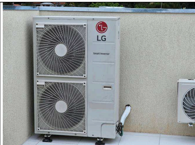
Figura 102: Condensadora – reinstalada.
