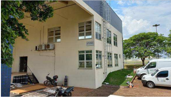
Figura I.3.1C: Vedadas todas as janelas da área administrativa da Setorial
