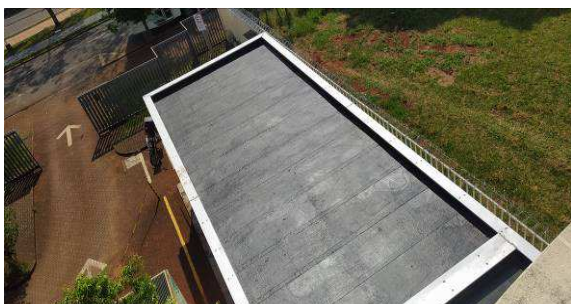
Figura I.8.1C: Impermeabilização da laje de cobertura do posto de transformação
