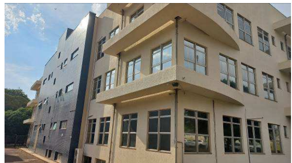
Figura I.3.6C: Vedadas todas as janelas laterais da 1ª Vara e da 5ª Vara
