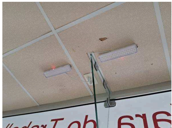
Figura I.5.2E: Blocos de emergência 60 leds
