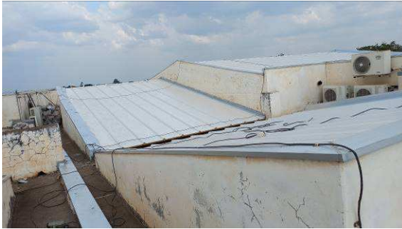
Figura I.2.7C: Rufos e contrarrufos instalados na região do Cejusc
