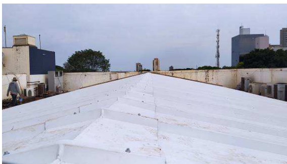
Figura I.2.5C: Telhas termoacústicas instaladas na região
