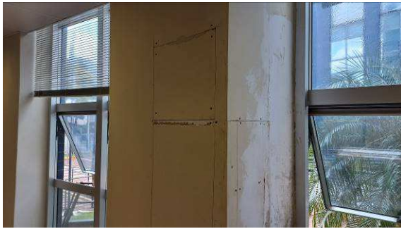
Figura I.8.13C: Execução de fechamento (embonecamento) de tubulação com uso de gesso acartonado – Local onde a tubulação pluvial foi substituída
