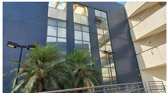
Figura I.3.12C: Peles de vidro da fachada frontal (esquerda) com flap EPDM totalmente instalada
