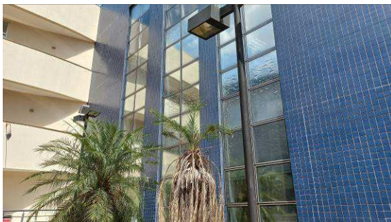
Figura I.3.11C: Peles de vidro da fachada frontal (direita) com flap em EPDM totalmente instalada
