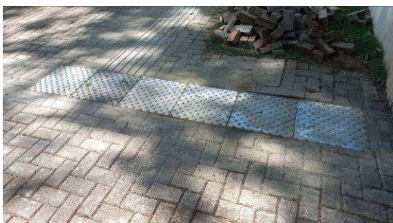
Figura I.7.5C: Piso tátil de alerta, instalado no passeio público
