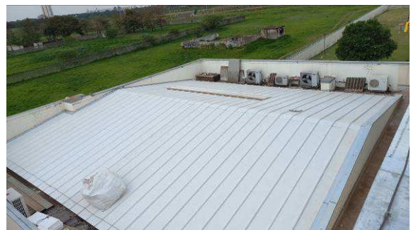
Figura I.2.6C: Telhas termoacústicas instaladas na região
