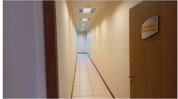
Figura I.4.30C: Pintura das paredes do corredor de acesso à área de segurança
