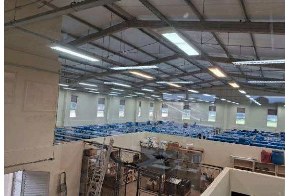
Figura I.6.4 E: substituição lâmpadas 120cm LED tubulares – barracão Setorial e Arquivo
