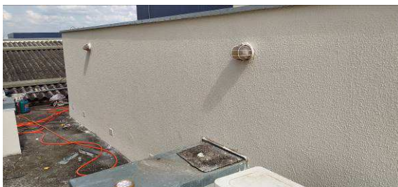
Figura I.4.1C: Aplicação de textura acrílica em platibanda, na região da cobertura da 4ª vara
