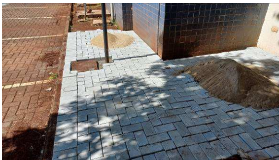
Figura I.8.5C: Assentamento do Paver defronte à OAB
