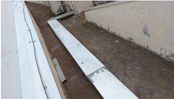
Figura I.2.11C: Chapim instalado na região da junta de dilatação
