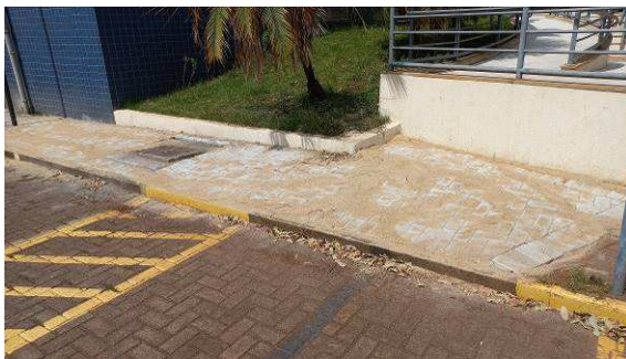
Figura I.8.7C: Rejuntamento do Paver junto ao acesso principal do Fórum
