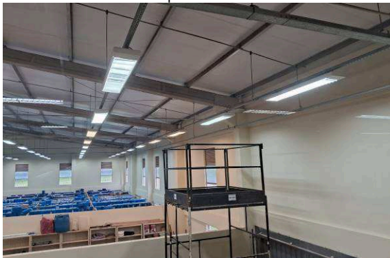
Figura I.6.5 E: substituição lâmpadas 120cm LED tubulares – barracão Setorial e Arquivo
