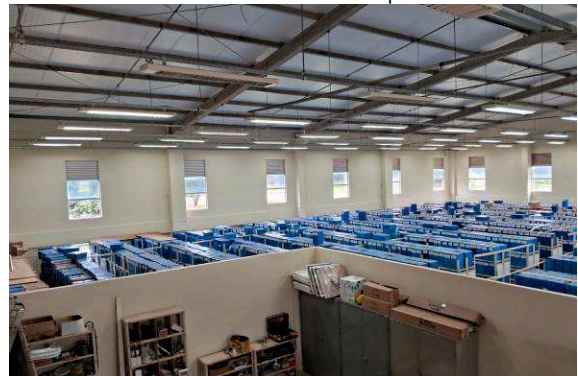
Figura I.6.6 E: substituição lâmpadas 120cm LED tubulares – barracão Setorial e Arquivo
