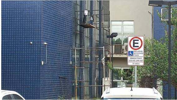
Figura I.1.3C: Andaime montado na fachada frontal
