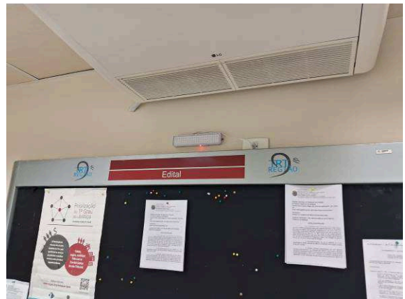
Figura I.5.4E: Blocos de emergência 60 leds
