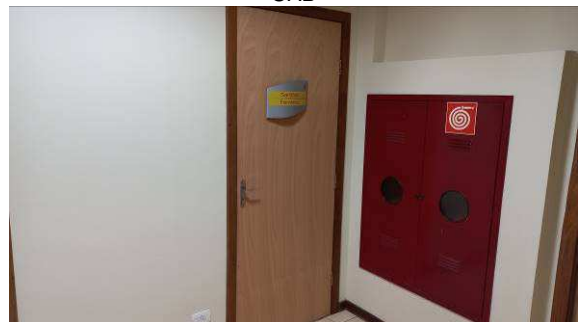
Figura I.8.10C: Folha de porta instalada no sanitário feminino do Arquivo
