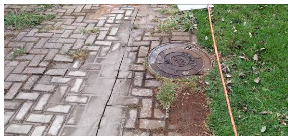
Figura I.7.2C: Serviço de corte do paver, para assentamento do piso tátil
