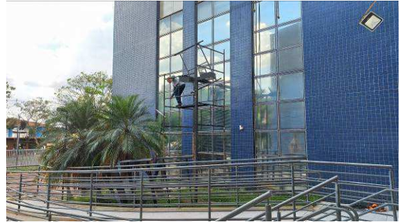
Figura I.1.4C: Andaime sendo desmontado
