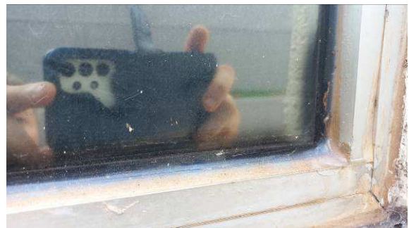
Figura I.3.8C: Detalhe de vedação de baguete
