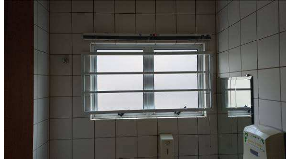
Figura I.5.6C: Gradil metálico instalado na janela do sanitário feminino da 1ª Vara
