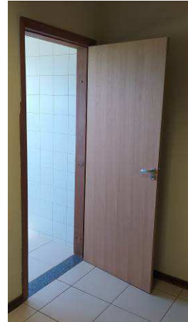
Figura I.8.12C: Folha de porta instalada no sanitário feminino da 2ª Vara
