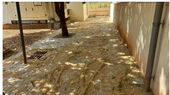
Figura I.8.6C: Rejuntamento do Paver com areia, defronte à direção do Fórum
