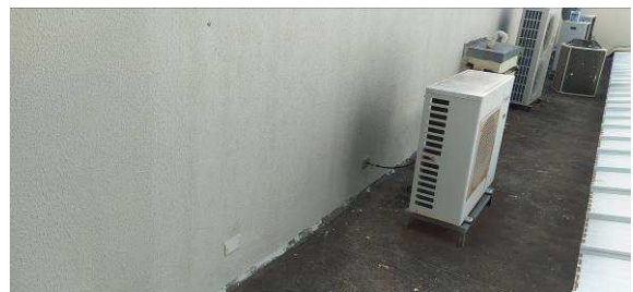
Figura I.4.2C: Aplicação de textura acrílica em platibanda, na região frontal do bloco esquerdo
