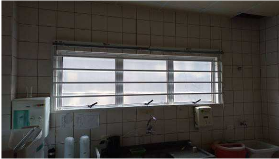
Figura I.5.5C: Gradil metálico instalado na janela da copa da 1ª Vara
