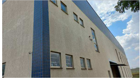
Figura I.3.2C: Vedadas todas as janelas da área administrativa da Setorial
