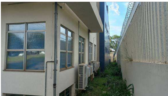
Figura I.3.7C: Vedadas todas as janelas da 2ª Vara
