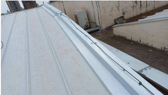
Figura I.2.9C: Rufos e contrarrufos instalados na região da sala osso
