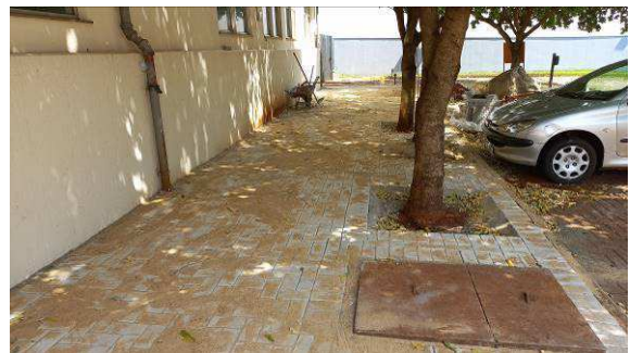
Figura I.8.8C: Rejuntamento do Paver com areia, defronte à OAB
