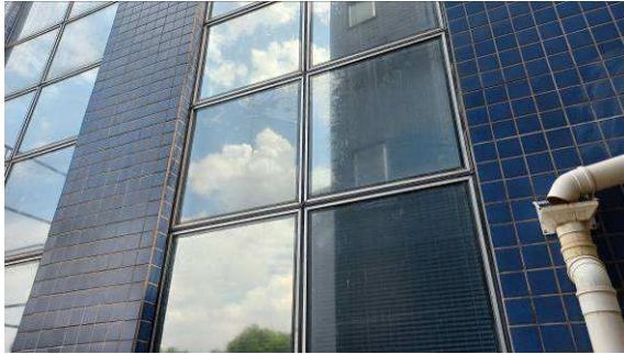
Figura I.3.9C: Remoção das gaxetas deterioradas e instalação de gaxetas FAA-250, nas peles de vidro
