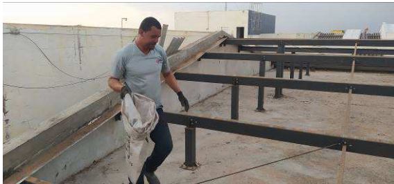
Figura I.2.1C: Remoção das telhas de fibrocimento na região do Arquivo
