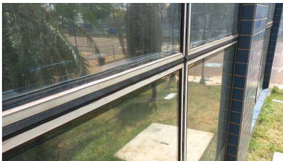
Figura I.3.13C: Detalhe da gaxeta devidamente fixada nas bordas da esquadria
