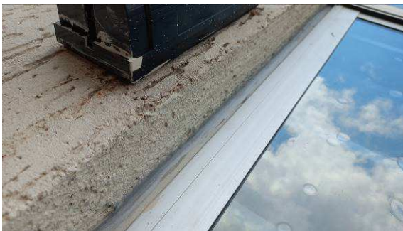
Figura I.3.3C: Detalhe de vedação de caixilho
