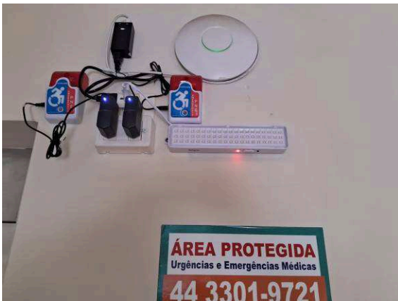
Figura I.5.3E: Blocos de emergência 60 leds
