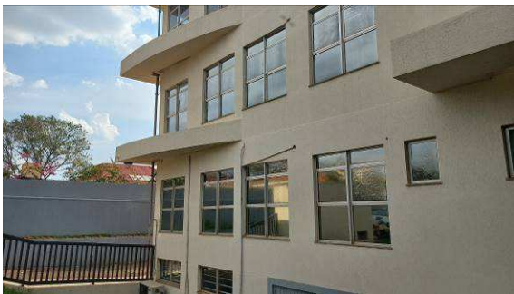
Figura I.3.5C: Vedadas parte das janelas posteriores da 1ª Vara e da 5ª Vara
