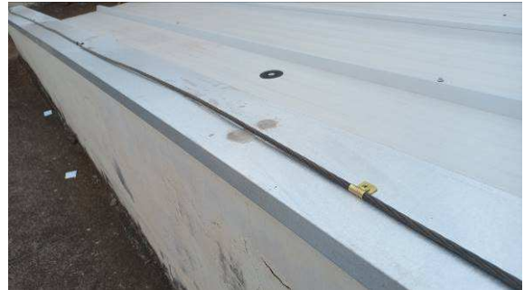
Figura I.2.12C: Chapim instalado na região do bloco central
