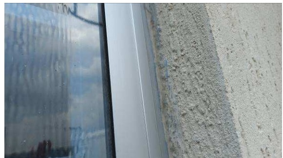
Figura I.3.4C: Detalhe de vedação de caixilho
