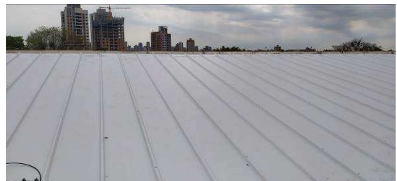
Figura I.2.4C: Telhas termoacústicas instaladas na região da sala osso
