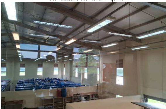
Figura I.6.7 E: substituição lâmpadas 120cm LED tubulares – barracão Setorial e Arquivo
