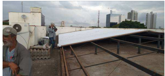
Figura I.2.2C: Remoção das telhas de fibrocimento e início da instalação das telhas termoacústicas na região da sala osso
