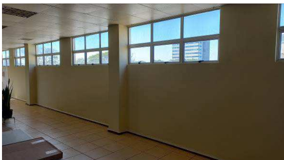
Figura I.4.19C: Pintura das paredes do refeitório
