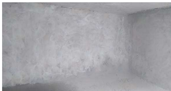
Figura I.8.2C: Remoção da manta e camada de proteção mecânica de um dos dois reservatórios superiores
