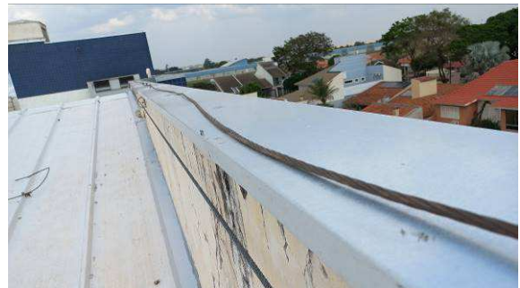
Figura I.2.14C: Chapim instalado na região da sala osso
