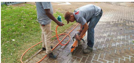
Figura I.7.1C: Serviço de corte do paver, para assentamento do piso tátil
