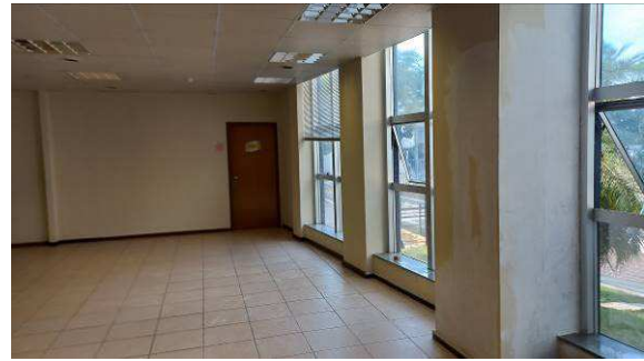
Figura I.8.14C: Embonecamento já executado, após aplicação de massa corrida e lixamento
