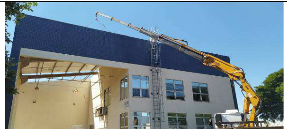
Figura I.2.4C: Uso de guindaste para remoção das telhas de fibrocimento e içamento das telhas termoacústicas
