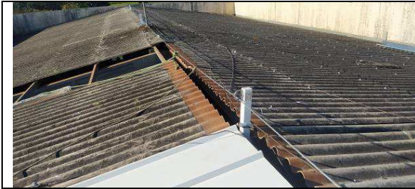
Figura I.2.1C: Início da retirada de telhas de fibrocimento na cobertura da Setorial
