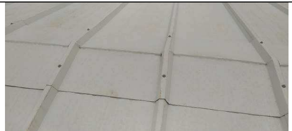
Figura I.2.8C: Goivas instaladas na cumeeira do barracão
