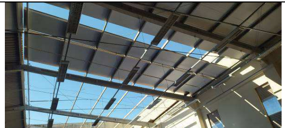
Figura I.2.6C: Vista por baixo, das telhas termoacústicas sendo instaladas no barracão
