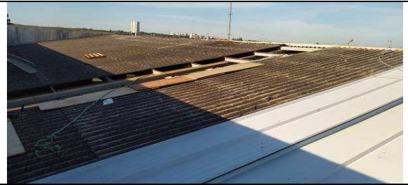
Figura I.2.2C: Retirada de telhas de fibrocimento na cobertura da Setorial
