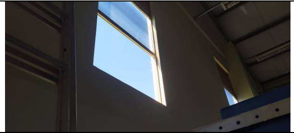
Figura I.3.4C: Instalação de esquadrias de vidro em substituição a venezianas de alumínio, na Setorial
