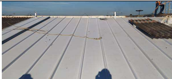
Figura I.2.3C: Início da instalação das telhas termoacústicas no barracão
