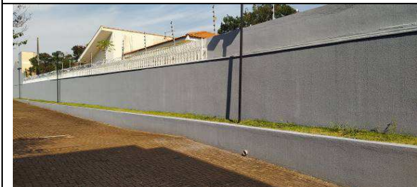
Figura I.4.3C: Aplicação de textura nos muros, muretas e elevações – lateral direita
