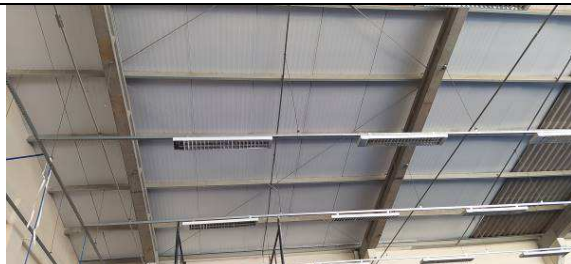
Figura I.2.7C: Vista por baixo, das telhas termoacústicas sendo instaladas no barracão
