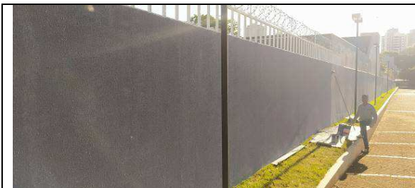
Figura I.4.1C: Aplicação de textura acrílica premium, na cor cinza médio, nos muros, elevações e muretas da divisa direita do imóvel
