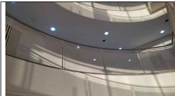
Figura I.6.1E: Substituição lâmpadas fluorescentes compactas por LED bulbo E27
