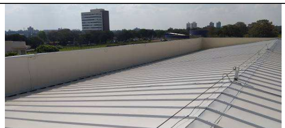
Figura I.2.8C: Goivas instaladas na cumeeira do barracão
