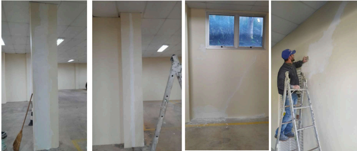
Figuras 10: Emassamento e lixamento das paredes internas do Estacionamento, Hall e ambientes do subsolo.
