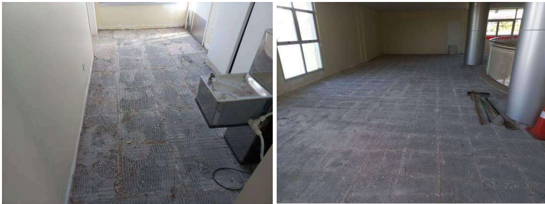
Figuras 08: Remoção de piso existente no 2º pavimento.
