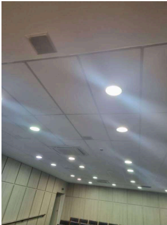
Figuras 06: Remoção e instalação de forro removível acústico de fibra mineral no Auditório
