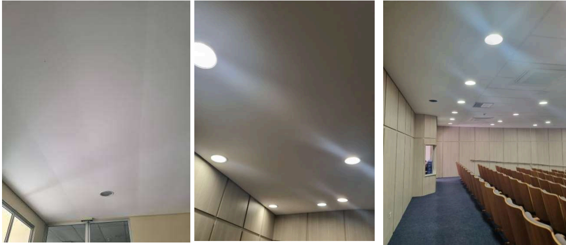
Figuras 07: Remoção e instalação de forro de gesso acartonado monolítico no Auditório e no 2º pavimento.
