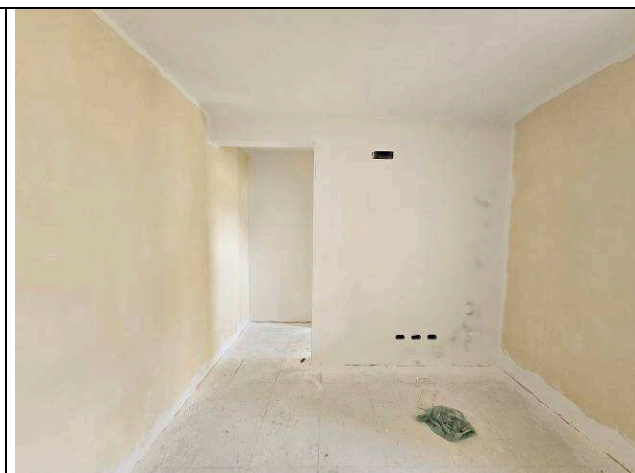
Figura 04: Paredes de gesso acartonado.
