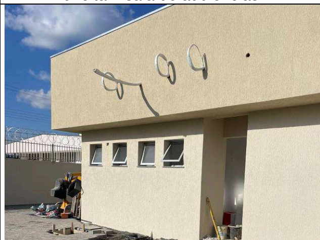
Figura 20: Janelas de alumínio – fundos – área de terceirizados.
