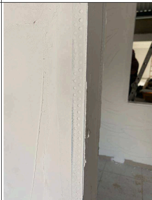
Figura 06: Paredes de gesso acartonado – perfis de reforço de canto.
