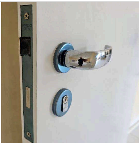
Figura 11: Portas de madeira - fechadura.
