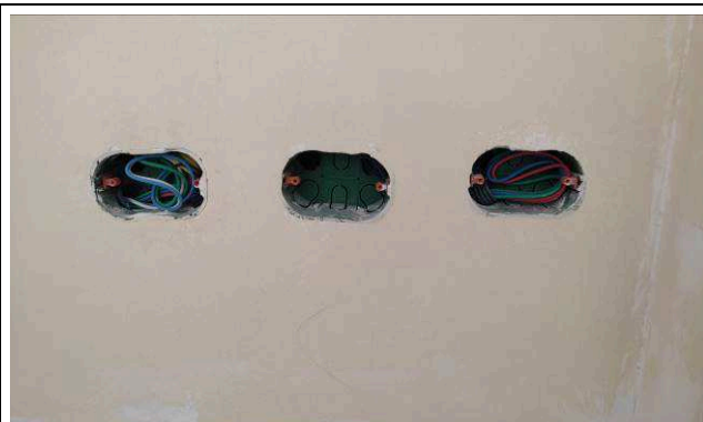
Figura 01E: Caixas 2x4", 4x4", eletrodutos corrugados 1", cabeamento elétrico.
