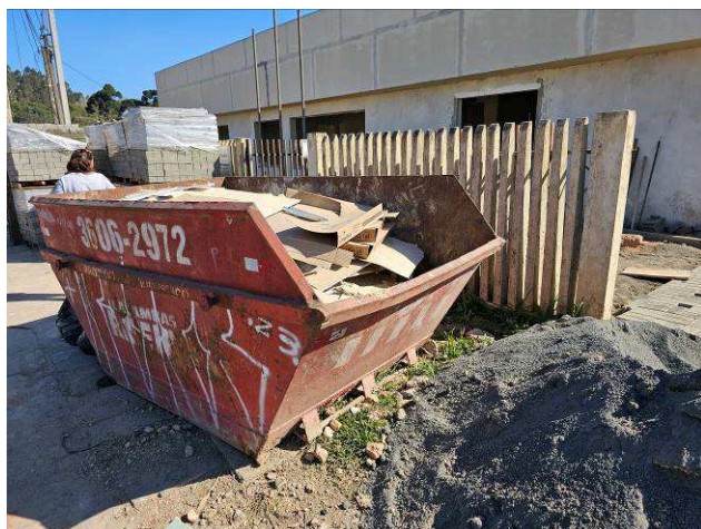
Figura 01: Caçamba - entulhos de gesso.
