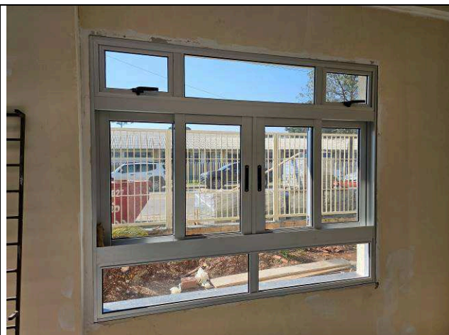
Figura 17: Janelas de alumínio – frontal – hall público.
