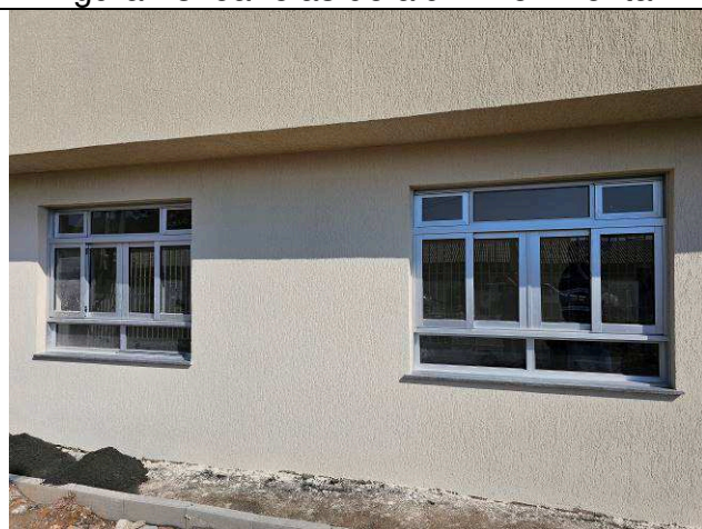
Figura 15: Janelas de alumínio - frontal.
