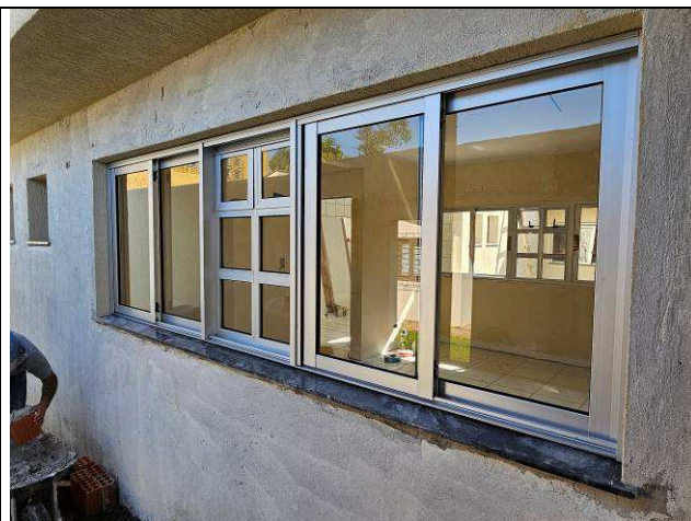
Figura 24: Janelas de alumínio – lateral esquerda - secretaria.
