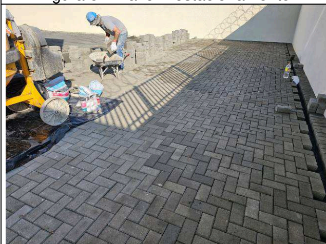
Figura 53: Paver - estacionamento.
