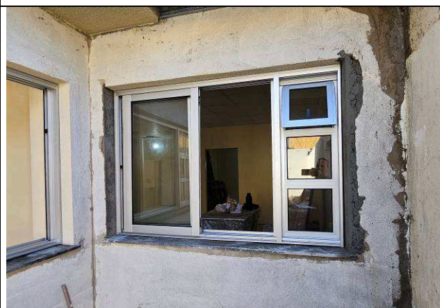
Figura 22: Janelas de alumínio – lateral esquerda - secretaria.
