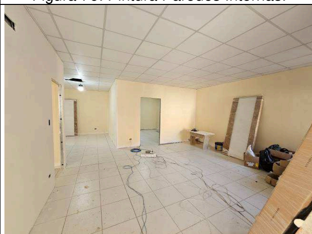
Figura 78: Pintura Paredes Internas.
