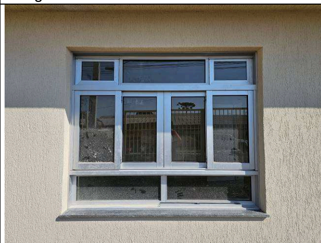
Figura 16: Janelas de alumínio - frontal.
