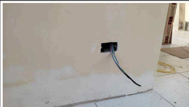
Figura 05E: Caixas 2x4", 4x4", eletrodutos corrugados 1", cabeamento elétrico.
