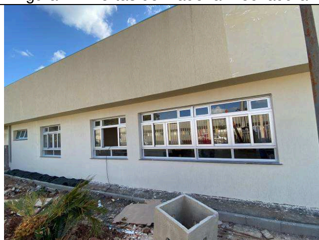
Figura 13: Janelas de alumínio - frontal.
