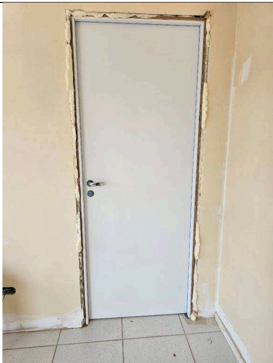
Figura 07: Portas de madeira.
