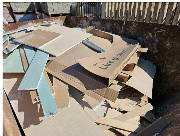
Figura 02: Caçamba - entulhos de gesso.
