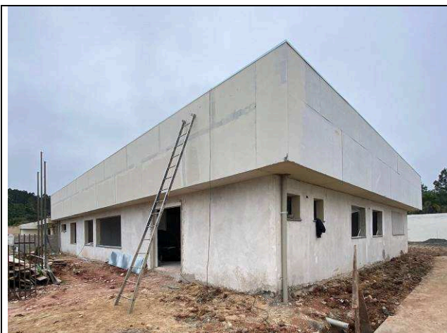
Figura 29: Fechamento Platibanda.
