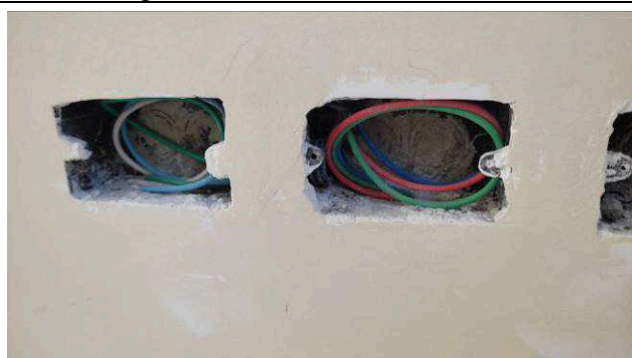
Figura 04E: Caixas 2x4", 4x4", eletrodutos corrugados 1", cabeamento elétrico.
