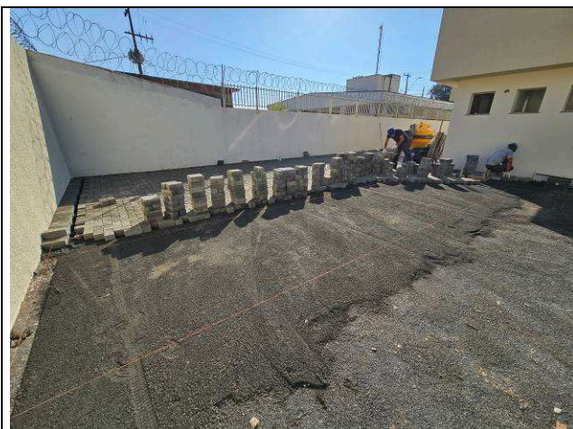
Figura 49: Base Paver - estacionamento.
