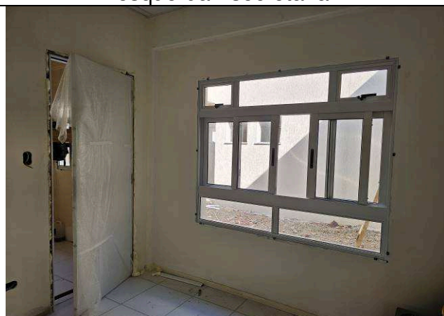
Figura 25: Janelas de alumínio – jardim central – sala de audiências.
