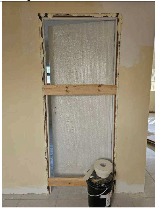
Figura 10: Portas de madeira.
