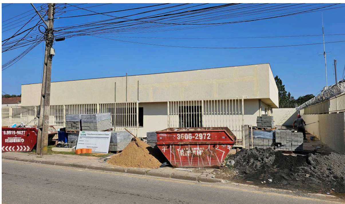
Figura 1 – Fachada externa – edifício frontal.
