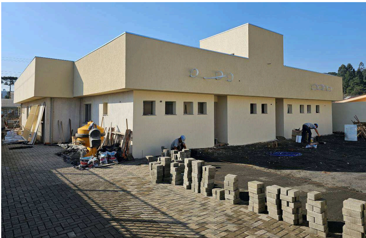
Figura 2 – Fachada externa – edifício ampliação.
