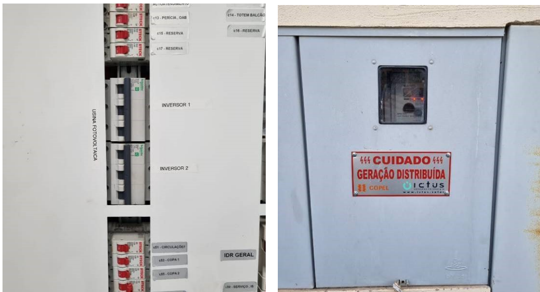
Figuras 03 – Conexão à rede elétrica do imóvel – Dois Vizinhos
