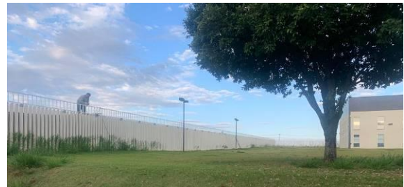
Figura I.5.6C: Gradil metálico sobre muro palito – lateral esquerda
