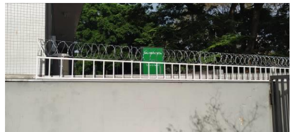
Figura I.5.8C: Gradil metálico e concertina dupla – muro lateral direito
