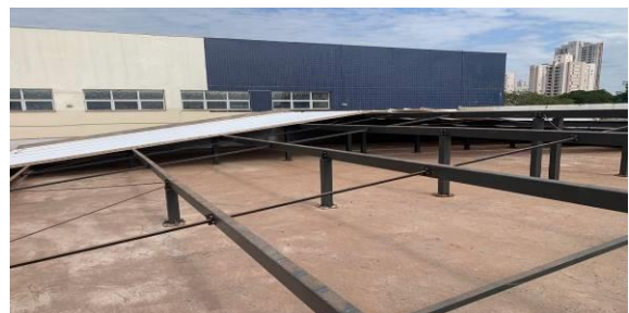
Figura I.2.2E: retirada material cobertura
