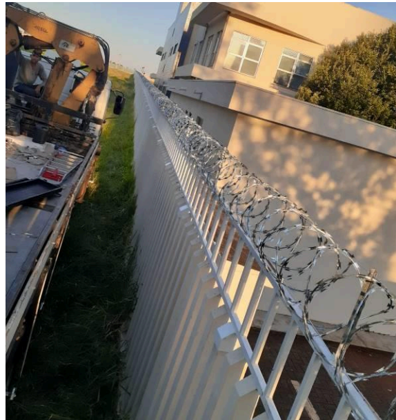
Figura I.5.11C: Gradil e concertina no palito lateral esquerdo
