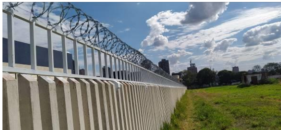
Figura I.5.10C: Gradil e concertina sobre muro palito
