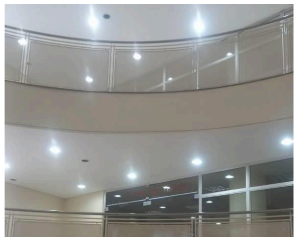
Figura I.6.12E: Substituição soquetes, limpeza luminária e novas lâmpadas LED
