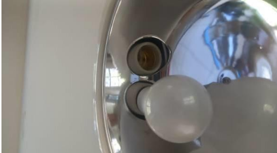
Figura I.6.1E: Substituição soquetes, limpeza luminária e novas lâmpadas LED
