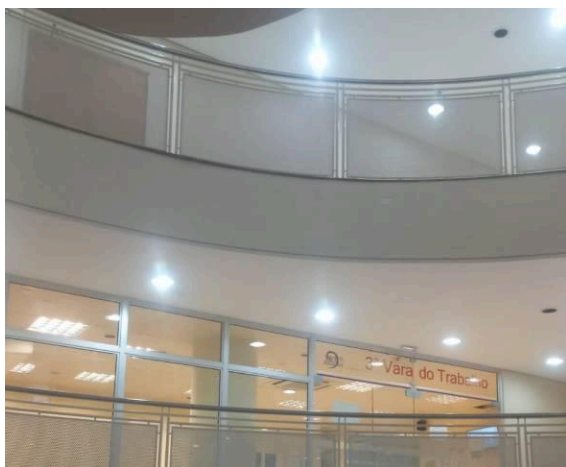
Figura I.6.11E: Substituição soquetes, limpeza luminária e novas lâmpadas LED
