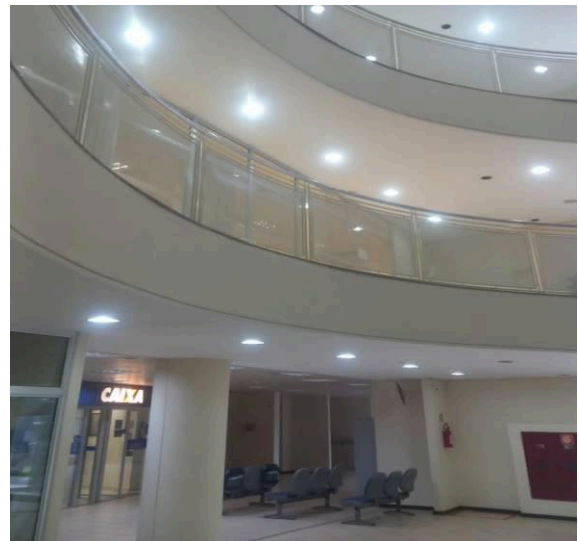
Figura I.6.10E: Substituição soquetes, limpeza luminária e novas lâmpadas LED
