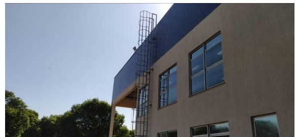
Figura I.8.6C: Instalação da escada marinheiro no prédio da setorial
