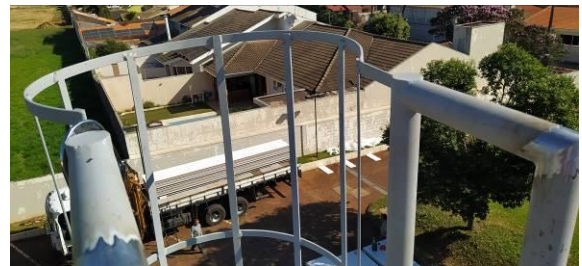
Figura I.8.8C: Detalhe do final da escada marinheiro, junto à cobertura
