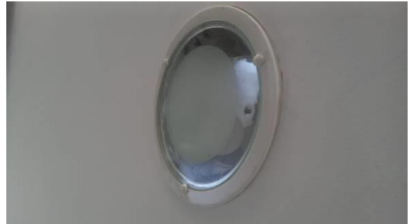
Figura I.6.4E: Substituição soquetes, limpeza luminária e novas lâmpadas LED
