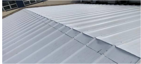
Figura I.2.8C: Telhas e goivas já instaladas sobre a 4ª Vara
