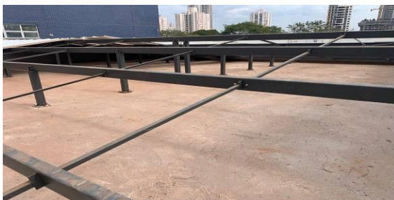
Figura I.2.1E: retirada material cobertura
