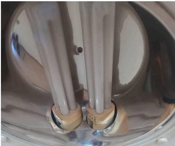
Figura I.6.5E: Substituição soquetes, limpeza luminária e novas lâmpadas LED
