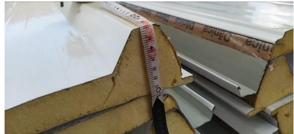
Figura I.2.2C: Aferição da altura total da telha
