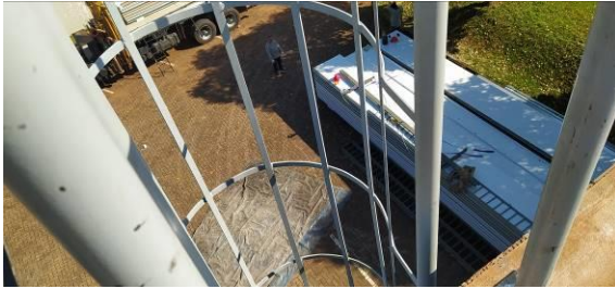
Figura I.8.9C: Detalhe dos tubos metálicos de sustentação da escada e da proteção em arco
