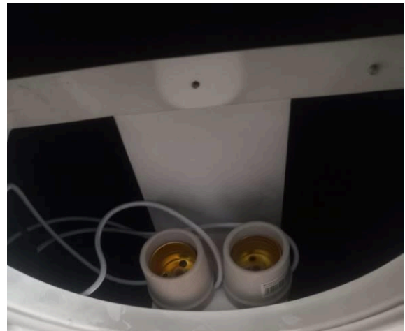
Figura I.6.6E: Substituição soquetes, limpeza luminária e novas lâmpadas LED
