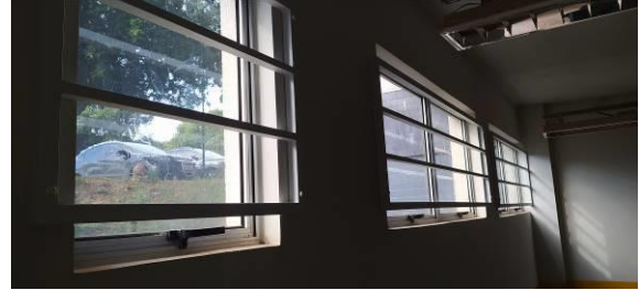
Figura I.5.2C: Grades de proteção das janelas do subsolo – lado esquerdo
