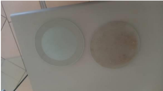
Figura I.6.3E: Substituição soquetes, limpeza luminária e novas lâmpadas LED
