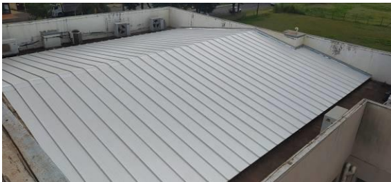
Figura I.2.9C: Vista panorâmica das telhas instaladas sobre a 4ª Vara
