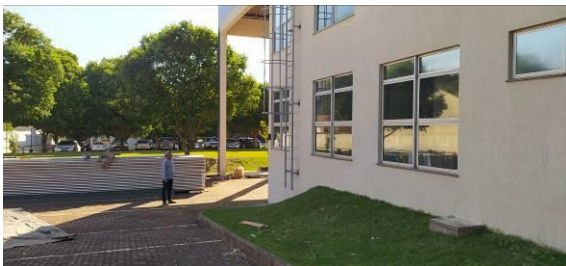
Figura I.8.7C: Instalação da escada marinheiro no prédio da setorial
