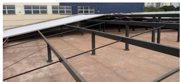
Figura I.2.6C: Remoção das telhas de fibrocimento e instalação das telhas termoacústicas
