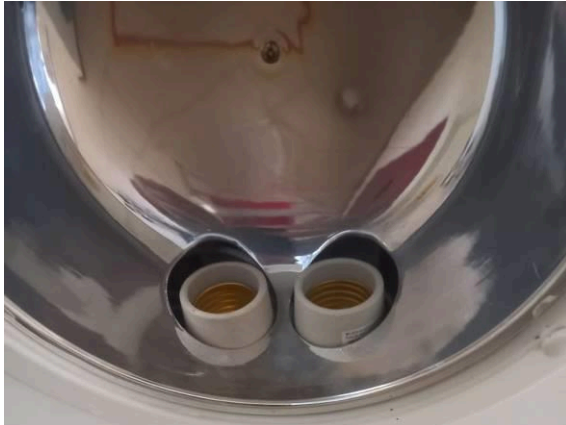
Figura I.6.7E: Substituição soquetes, limpeza luminária e novas lâmpadas LED
