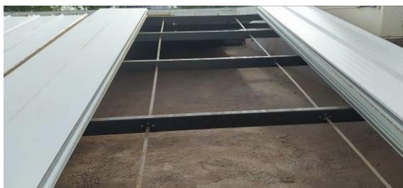
Figura I.2.5C: Remoção das telhas de fibrocimento e instalação das telhas termoacústicas
