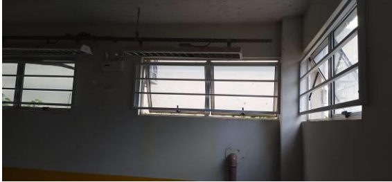
Figura I.5.1C: Grades de proteção das janelas do subsolo – lado esquerdo
