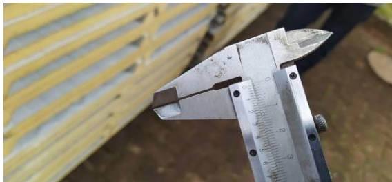
Figura I.2.3C: Aferição da espessura da telhas
