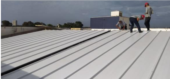
Figura I.2.7C: Operários realizando a fixação das telhas termoacústicas na área sobre a secretaria da 4ª Vara
