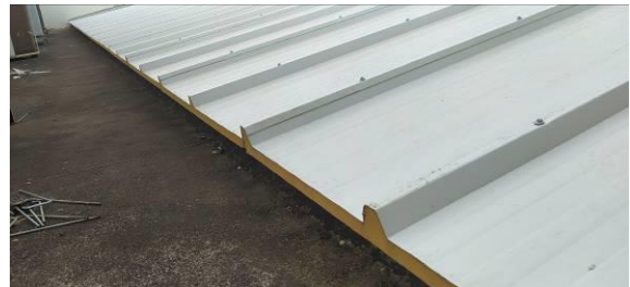
Figura I.2.10C: Detalhe da ponta inferior das telhas
