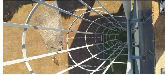
Figura I.8.10C: Escada marinheiro vista de cima
