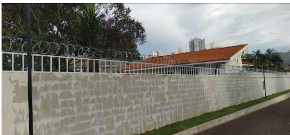
Figura I.5.7C: Gradil metálico e concertina dupla – muro lateral direito
