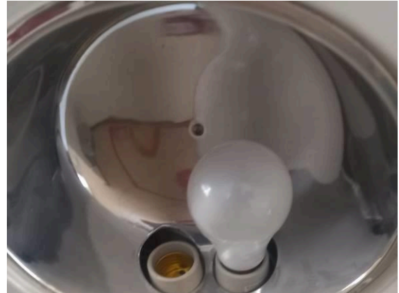
Figura I.6.8E: Substituição soquetes, limpeza luminária e novas lâmpadas LED
