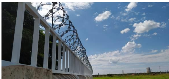
Figura I.5.12C: Gradil e concertina no palito dos fundos
