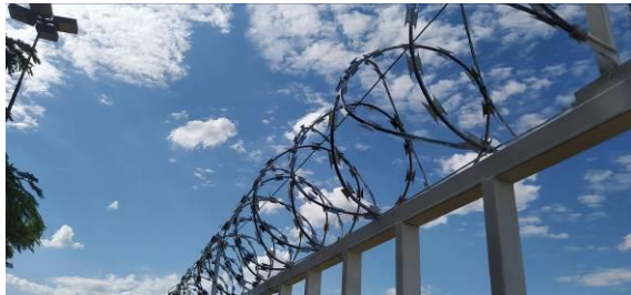
Figura I.5.9C: Detalhe da concertina dupla clipada fixada sobre os gradis metálicos
