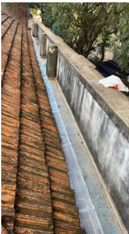
Figura 09 – instalação de tela nas calhas
