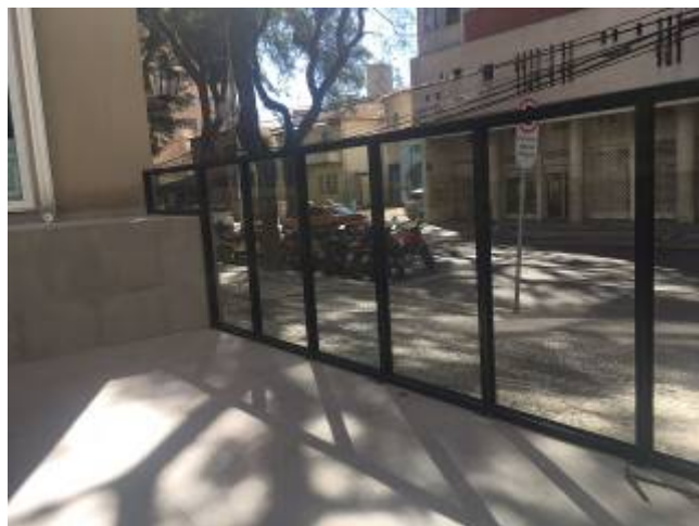
Figura 18 – Muro de vidro – Rua Visconde do Rio Branco
