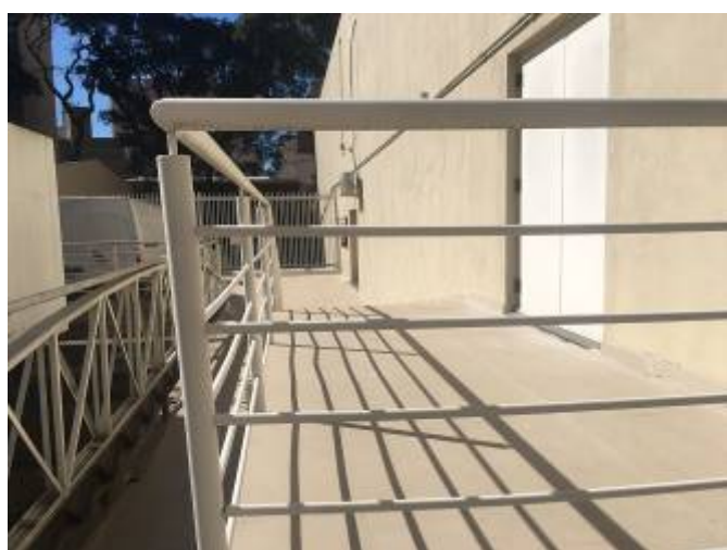
Figura 02 – remoção e reinstalação de guarda-corpo metálico
