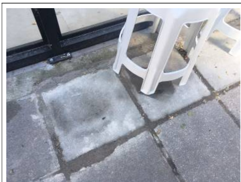
Figura 01- substituição placas de concreto
