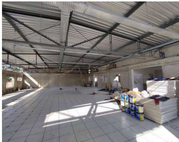
Figura 35: Eletrocalhas e perfilados - frente.
