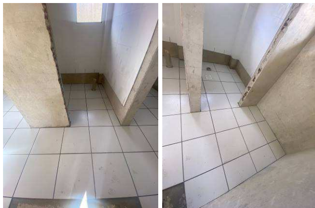
Figura 09: Piso Cerâmico – ampliação.
