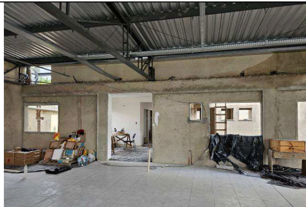
Figura 45: Revestimento argamassado – paredes internas área frontal.
