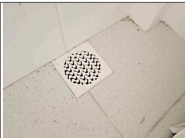
Figura 28: Caixa sifonada com ralo.
