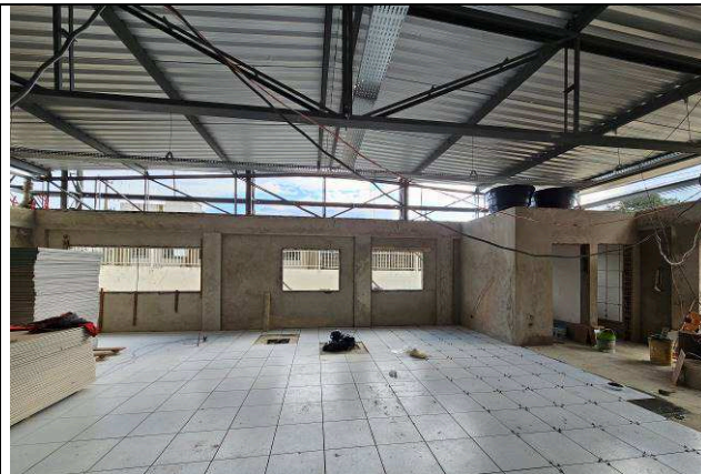
Figura 46: Revestimento argamassado – paredes internas área frontal.
