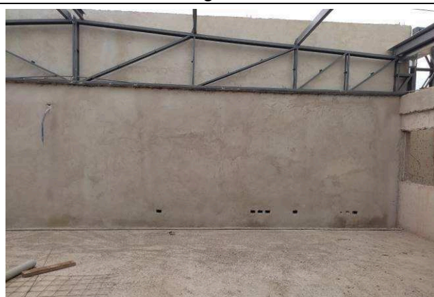
Figura 09E: Caixas 2x4" e eletrodutos corrugados 1"
