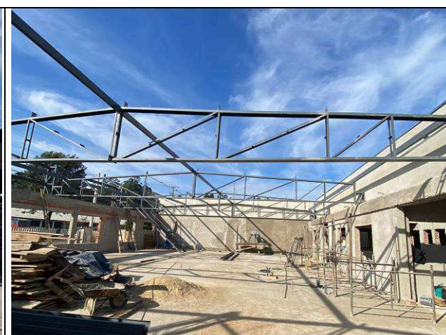
Figura 41: Estrutura de cobertura.
