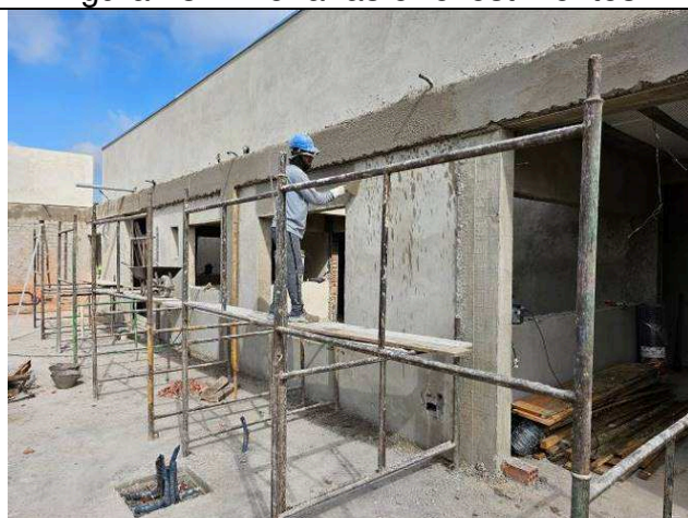
Figura 25: Alvenarias e revestimentos.
