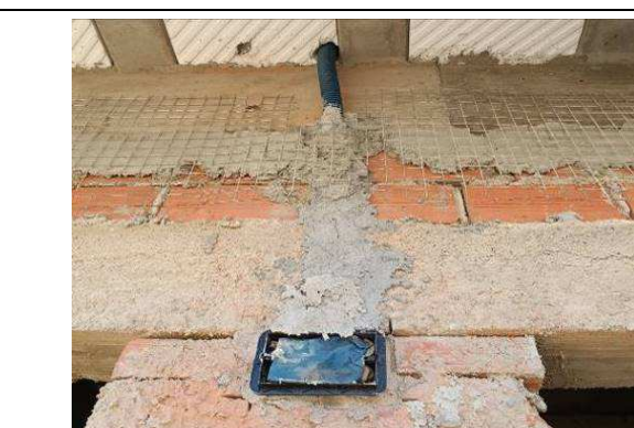
Figura 11E: Caixas 2x4" e eletrodutos corrugados 1"
