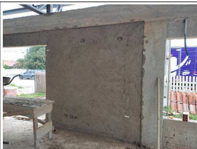
Figura 08E: Caixas 2x4" e eletrodutos corrugados 1"
