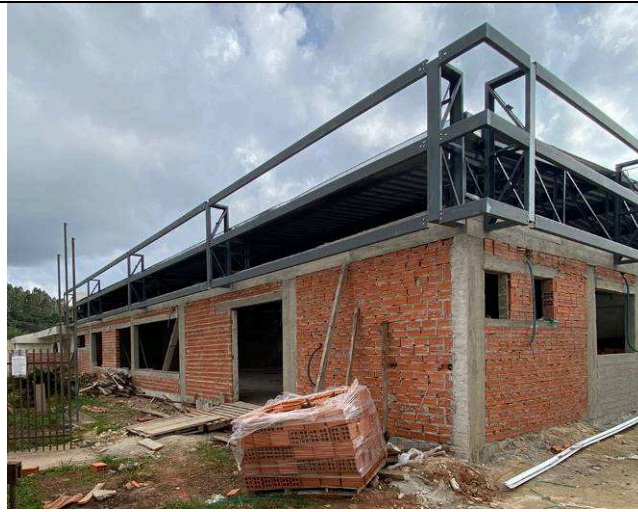
Figura 46: Estrutura metálica - fechamento.
