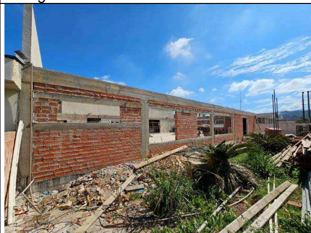
Figura 31: Alvenarias e revestimentos.
