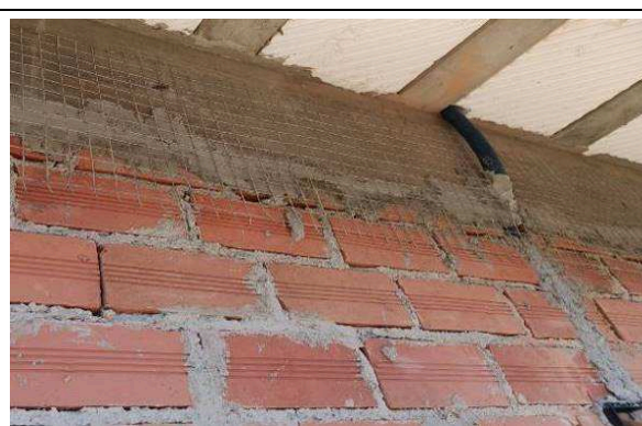
Figura 12E: Caixas 2x4" e eletrodutos corrugados 1"
