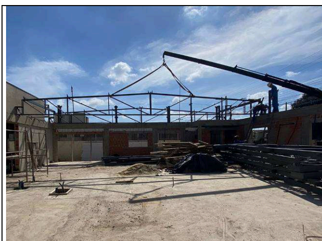
Figura 40: Estrutura de cobertura.
