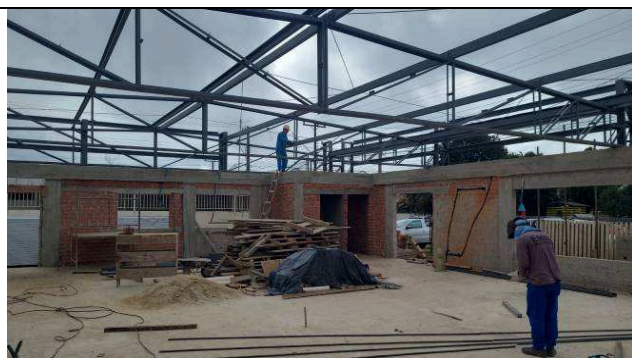
Figura 42: Estrutura de cobertura.
