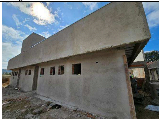
Figura 23: Alvenarias e revestimentos.
