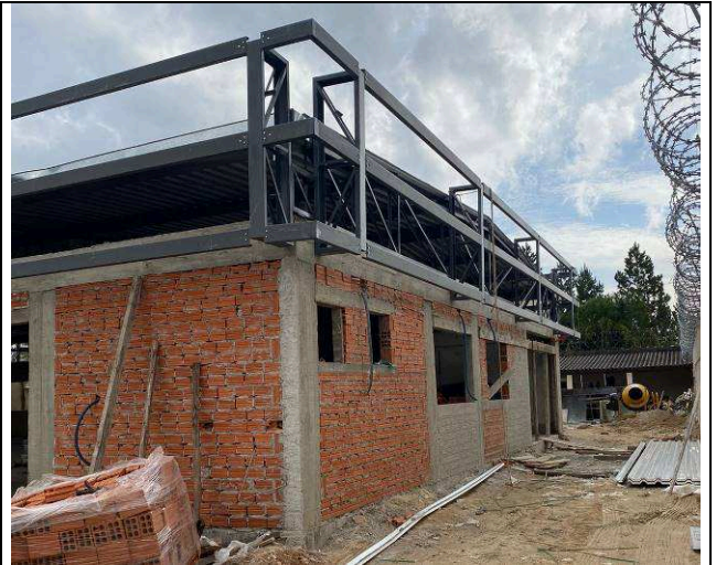
Figura 47: Estrutura metálica - fechamento.
