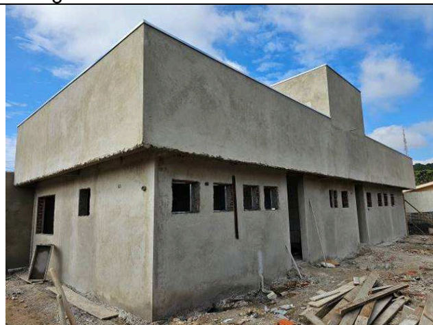
Figura 22: Alvenarias e revestimentos.
