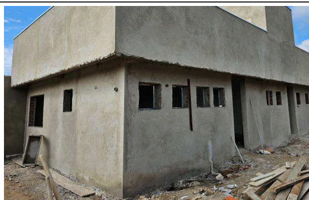
Figura 14E: Caixas 2x4" e eletrodutos corrugados 1"
