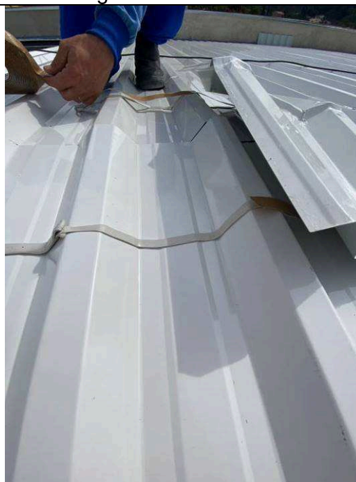
Figura 47: Cobertura–instalação cumeeira.
