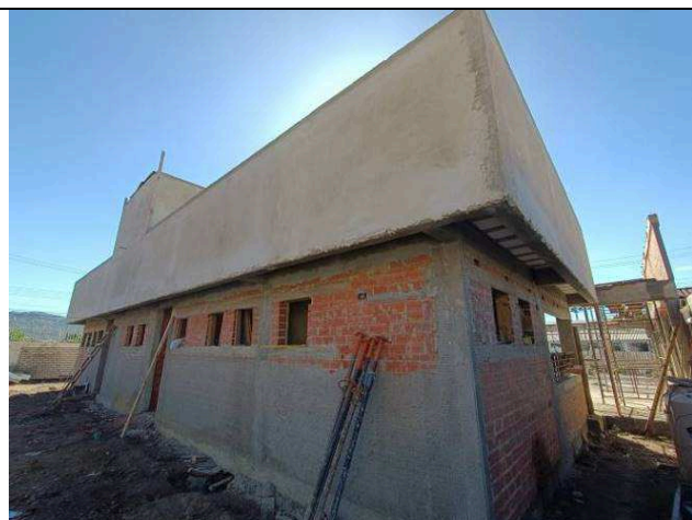
Figura 21: Alvenarias e revestimentos.
