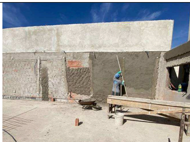
Figura 26: Alvenarias e revestimentos.
