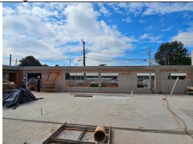
Figura 28: Alvenarias e revestimentos.
