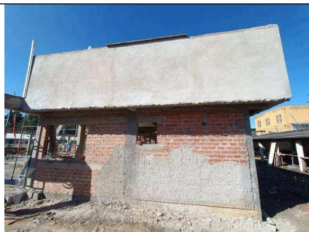
Figura 20: Alvenarias e revestimentos.
