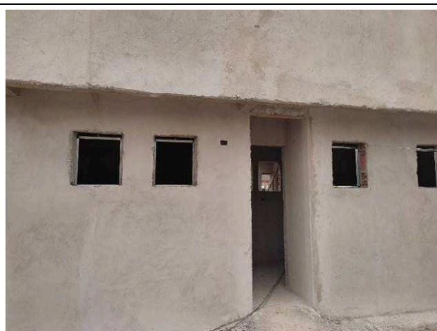
Figura 07E: Caixas 2x4" e eletrodutos corrugados 1"
