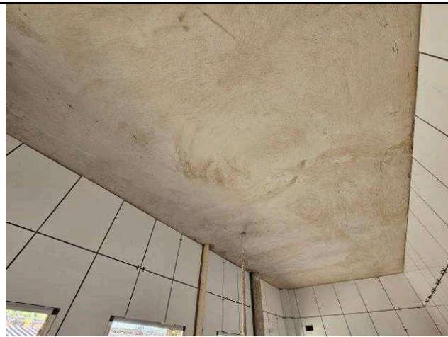
Figura 32: Revestimento de lajes.
