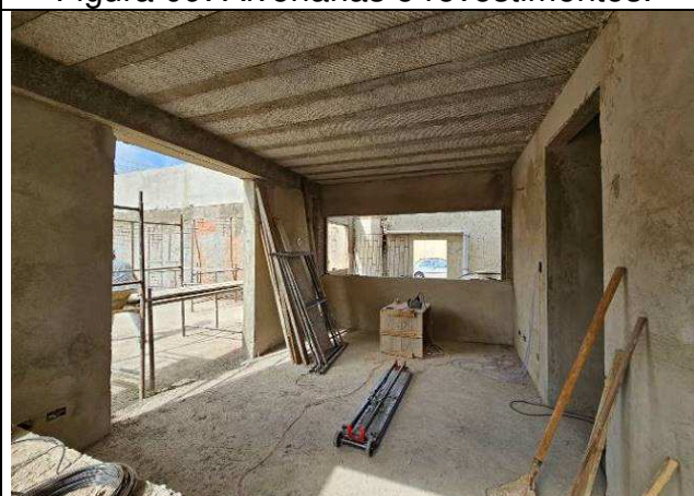
Figura 11: Alvenarias e revestimentos.
