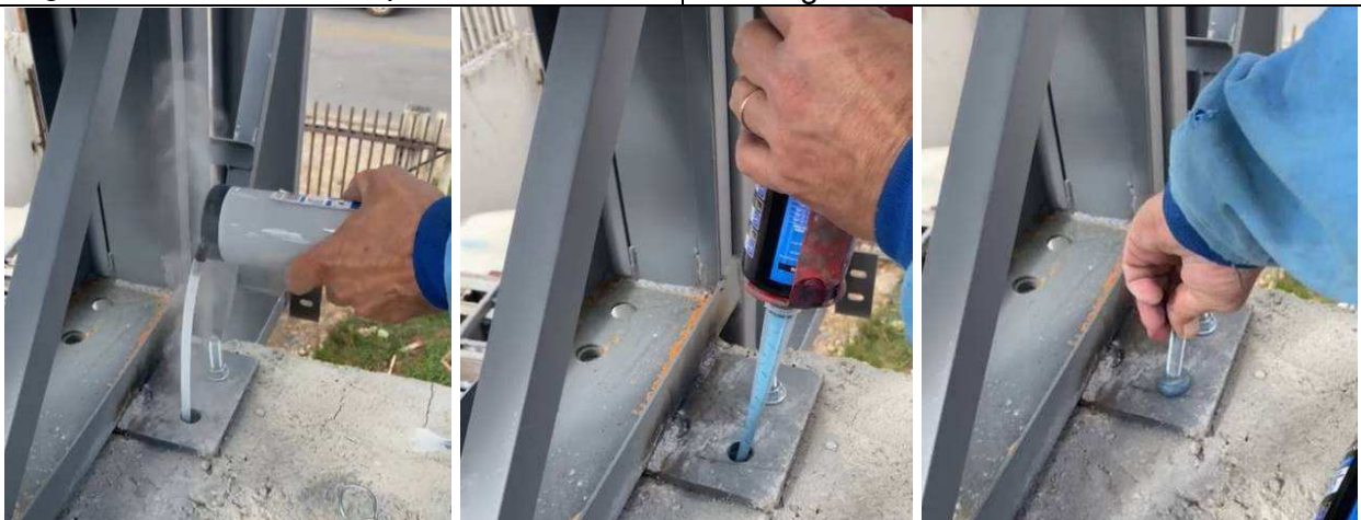
Figura 50: Sequência de instalação dos chumbadores – limpeza do furo, aplicação do chumbador químico, e instalação da barra roscada.
