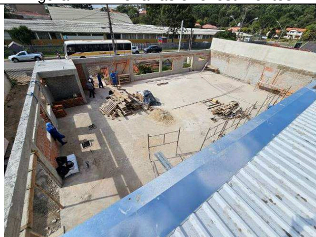
Figura 24: Alvenarias e revestimentos.
