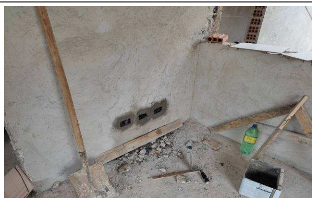
Figura 13E: Caixas 2x4" e eletrodutos corrugados 1"
