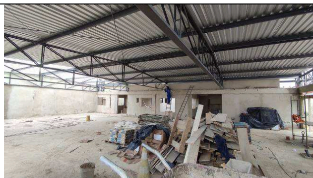
Figura 43: Estrutura de cobertura.
