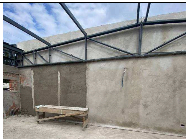
Figura 27: Alvenarias e revestimentos.
