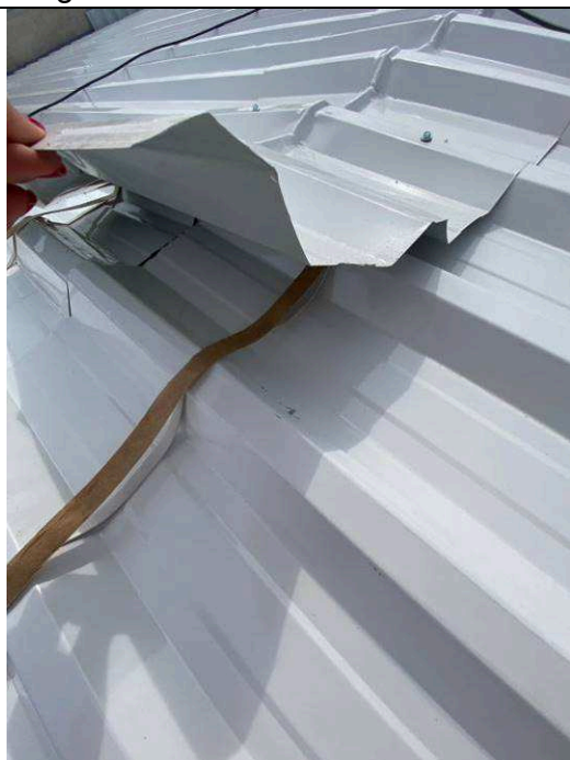
Figura 46: Cobertura–instalação cumeeira.
