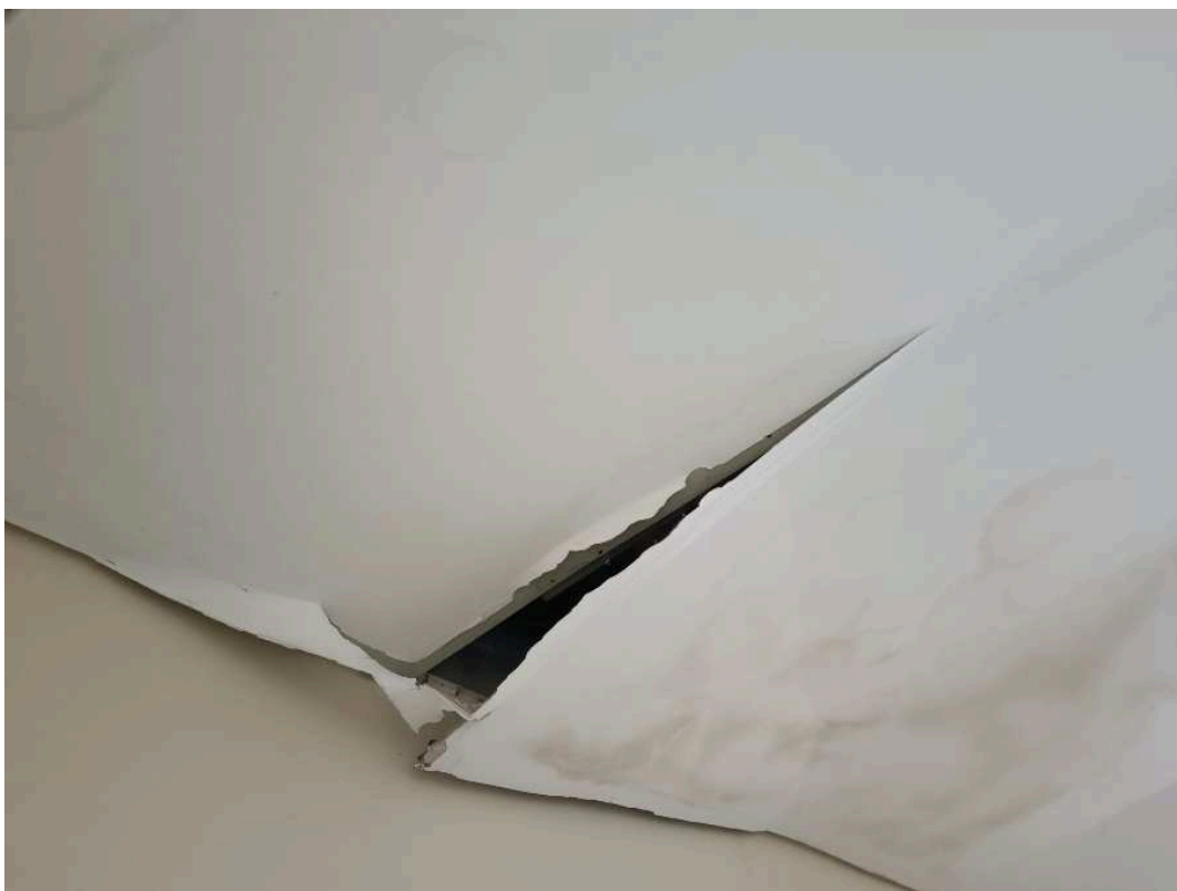
Figura 8 - Forro de gesso acartonado monolítico do foyer do auditório
