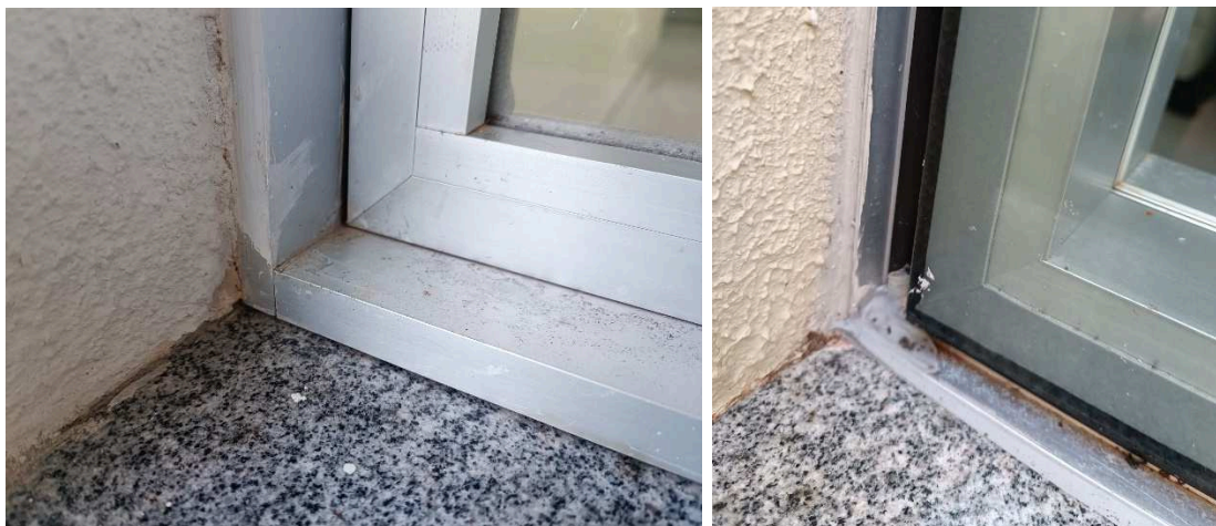
Figura 20 – Aplicação do selante em todo perímetro das esquadrias, na interface perfil de alumínio x parede/granito.
