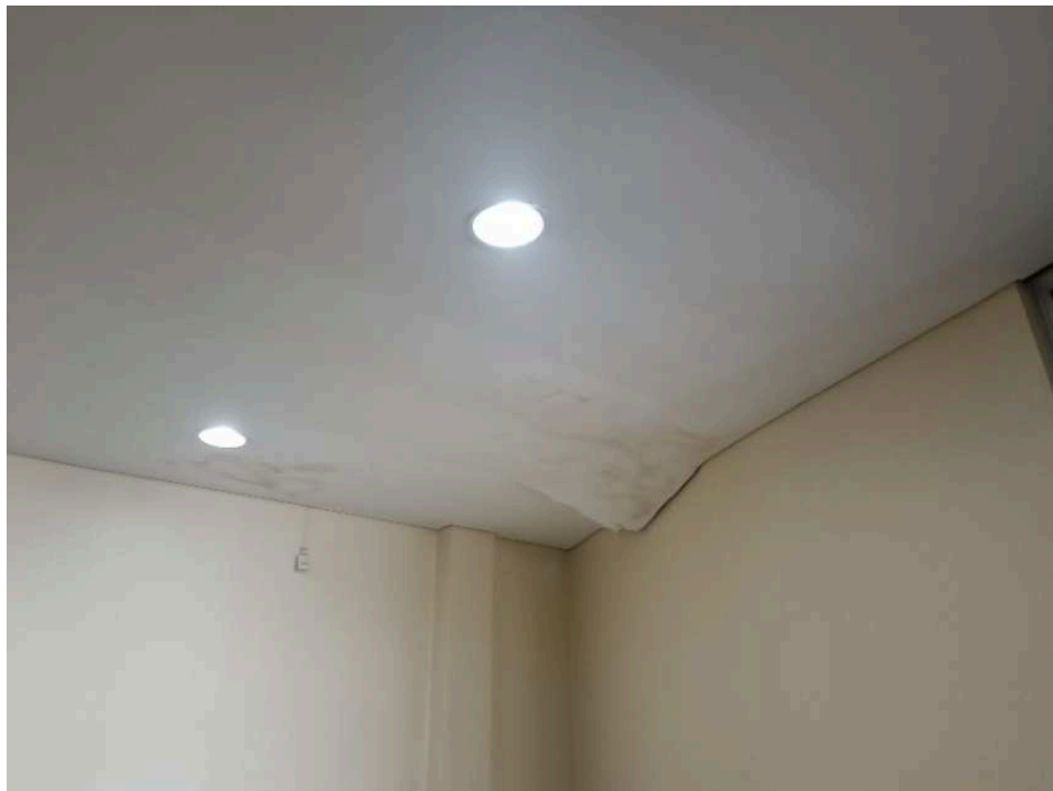
Figura 7 – Forro de gesso acartonado monolítico do foyer do auditório.
