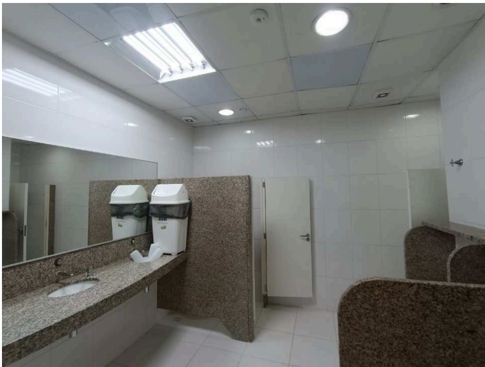
Figura 14 - Forro de gesso acartonado em placas – banheiro masculino auditório
