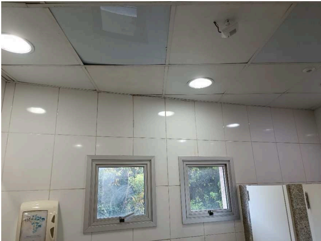
Figura 12 - Forro de gesso acartonado em placas – banheiro feminino auditório.
