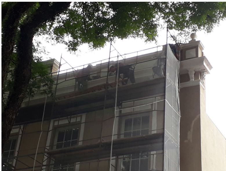
Figura 01 – Andaime com proteção de tela plástica
