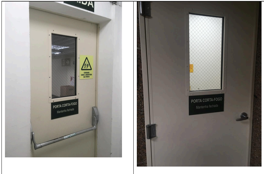
Figuras 14 – Modelo de Porta Corta Fogo (com visor de vidro) a ser instalado
