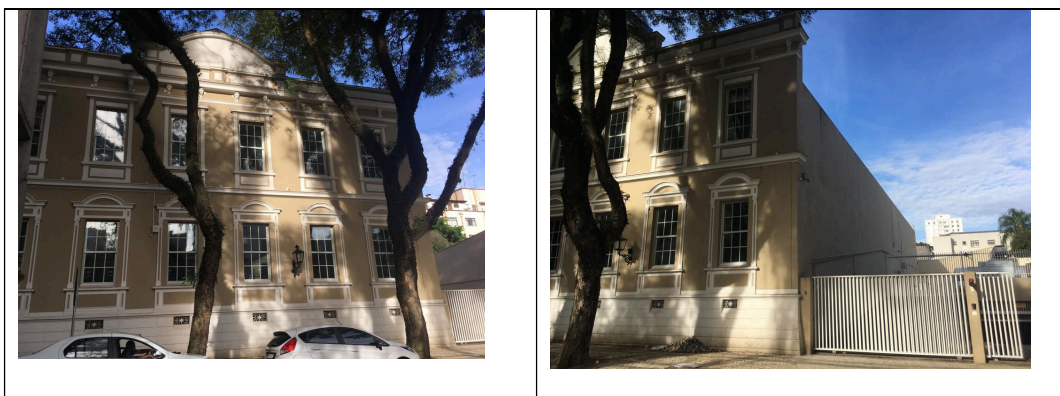
Figuras 03 – Fachada Rua Visconde do Rio Branco
