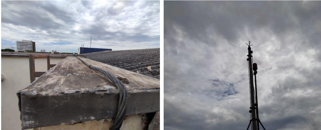
Figuras 1E a 6E – Instalações atuais de SPDA
