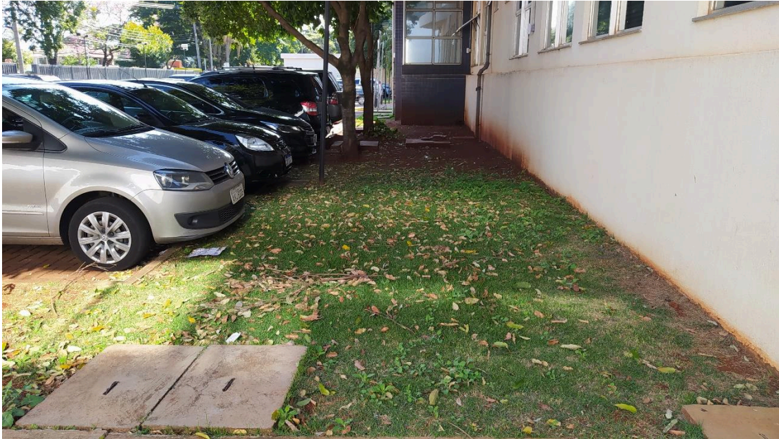
Região defronte à OAB – Remoção do gramado e instalação de Paver
