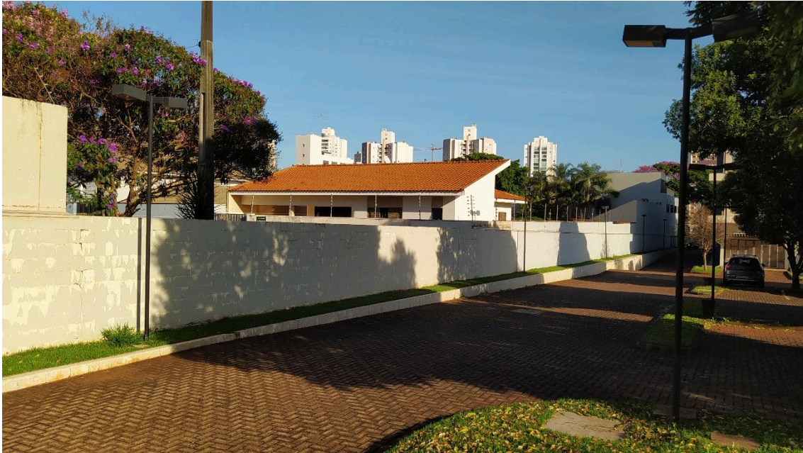
Aplicação de textura acrílica na mureta, no muro lateral e nas elevações existentes
