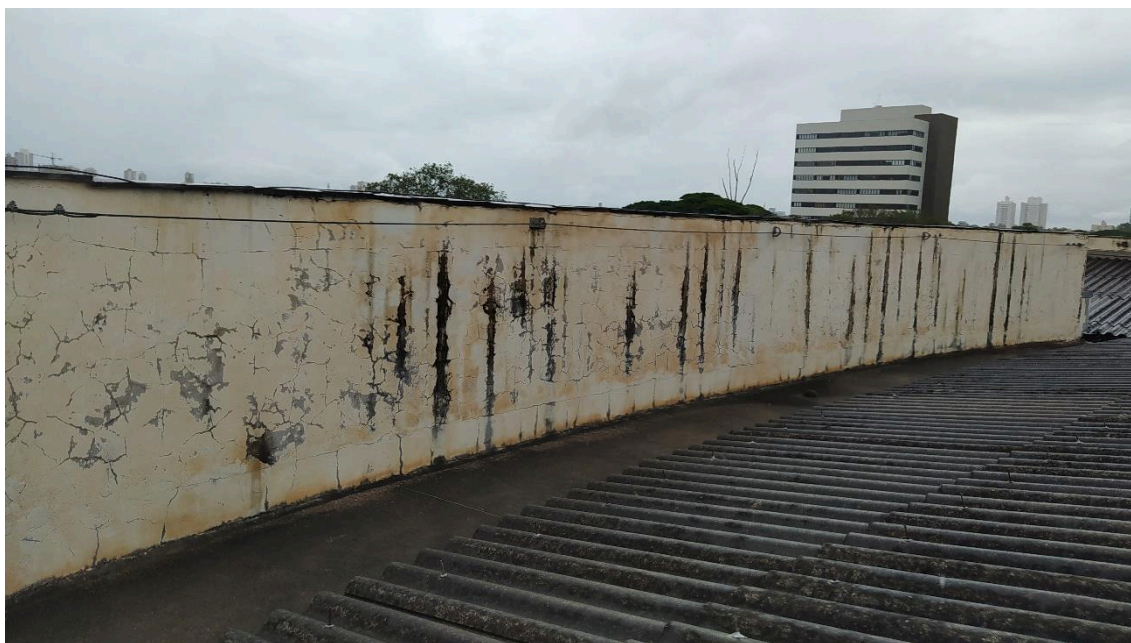
Aplicação de textura acrílica nas faces internas das platibandas, muretas e elevações existentes na cobertura do prédio do Fórum
