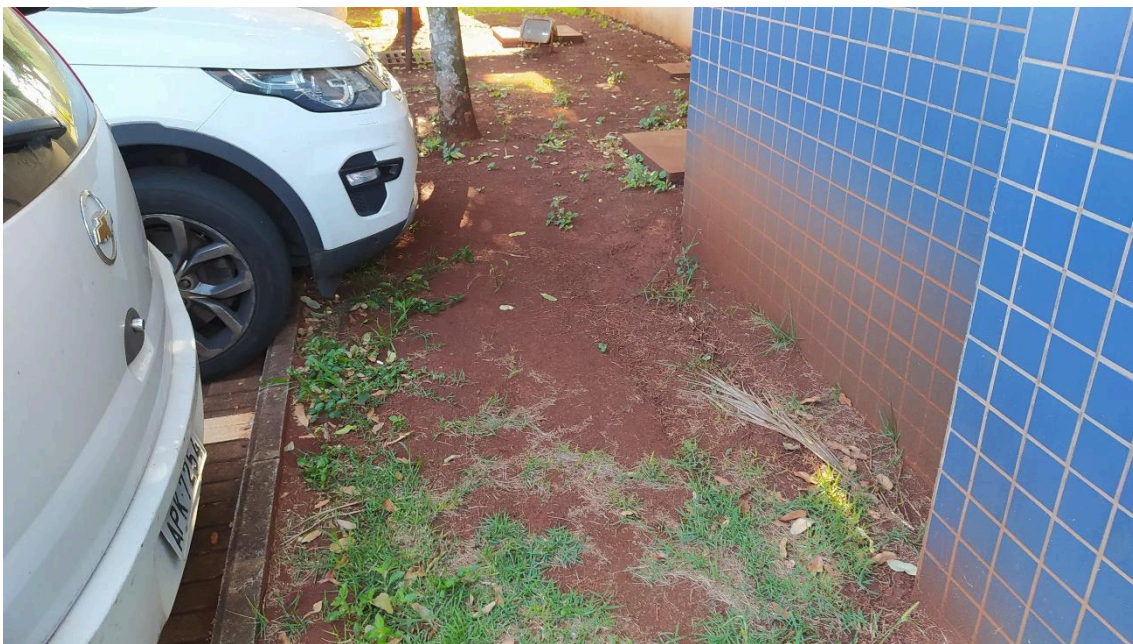
Região defronte à Direção do Fórum – Remoção do gramado e instalação de Paver
