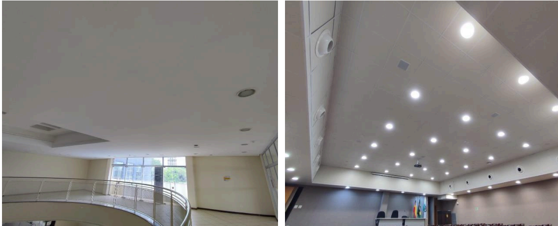
Figuras 25E a 28E – Luminárias bipino – trocar bocal e27
