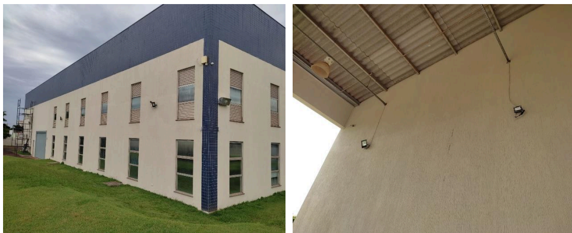
Figuras 11E a 14E – Refletores existentes a serem substituídos
