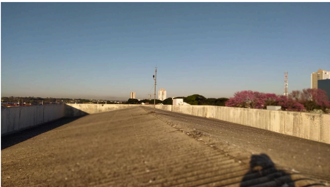
Telhas, calhas, rufos, chapins e contrarrufos a serem removidos, na cobertura da Setorial
