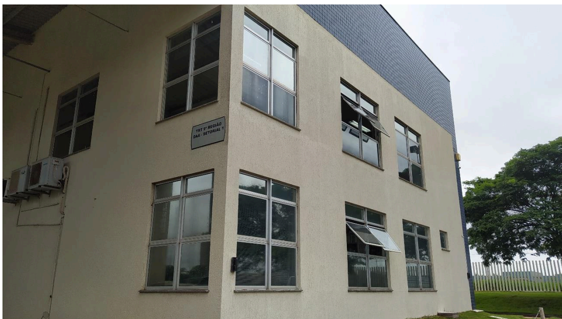
Local de instalação da escada marinho
