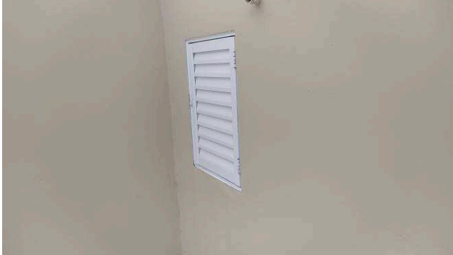
Figura 62C: Instalação de portinhola de acesso ao reservatório elevado
