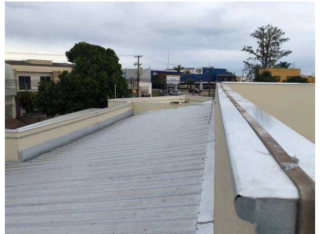
Figura 09C: Detalhe de rufos, contrarrufos e chapins
