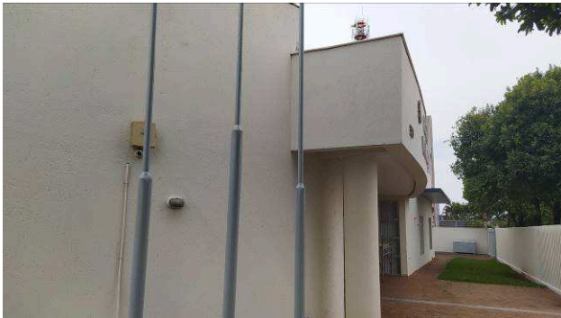
Figura 37C: Pintura dos mastros das bandeiras
