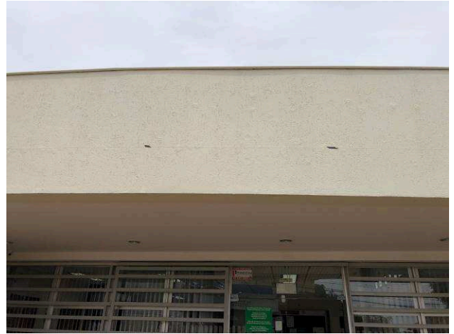
Figura 58C: Remoção do letreiro antigo
