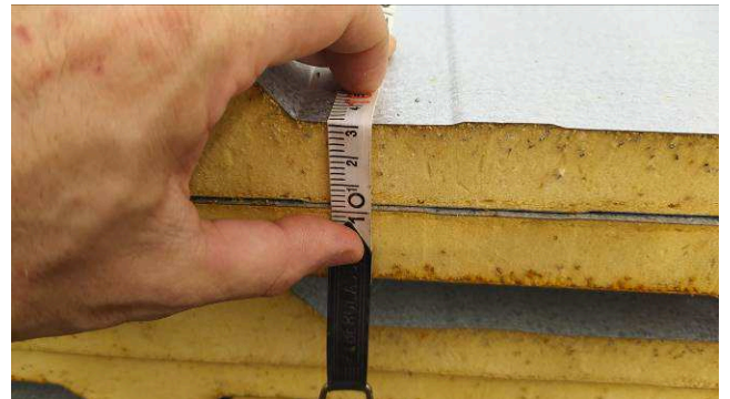
Figura 20C: Aferição da camada de preenchimento com PIR
