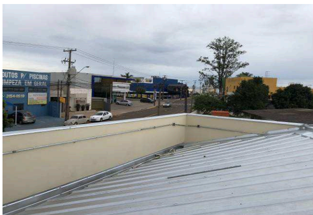
Figura 17E: Infraestrutura iluminação externa
