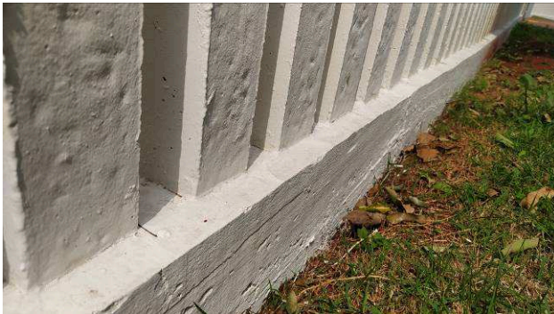
Figura 33C: Pintura das baldrame de sustentação dos muros palito
