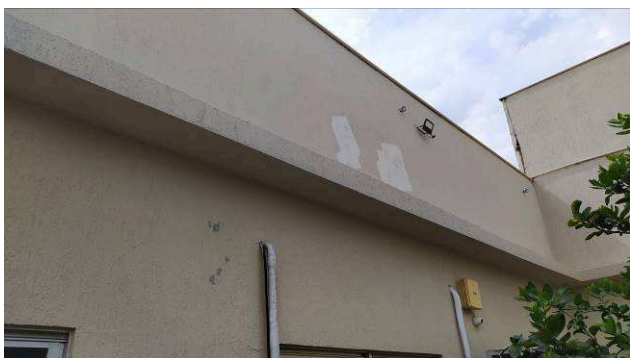
Figura 29C: Eliminação das tubulações existentes nas platibandas e fechamento dos orifícios
