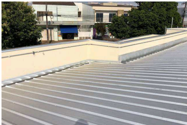
Figura 15E: Infraestrutura iluminação externa
