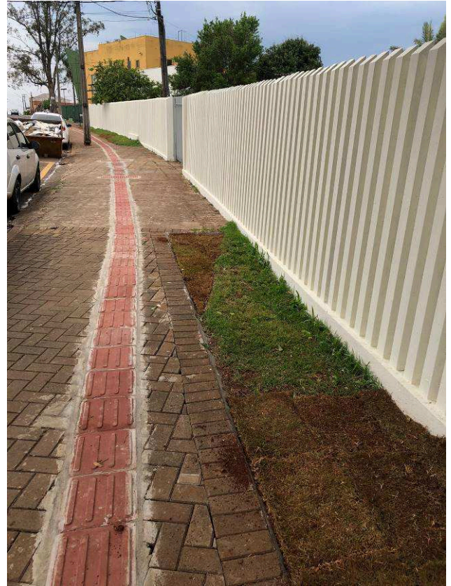
Figura 56C: Plantio de grama esmeralda, entre o paver e o muro palito
