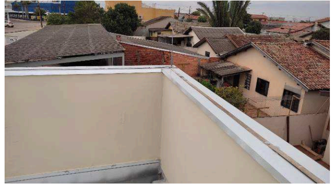
Figura 02E: SPDA reinstalado
