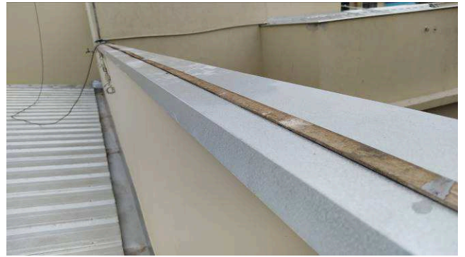
Figura 15C: Detalhe de chapim instalado sobre platibanda da secretaria
