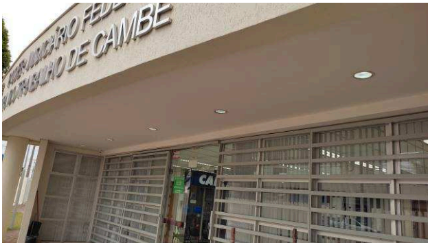
Figura 11E: Luminárias e lâmpada LED
