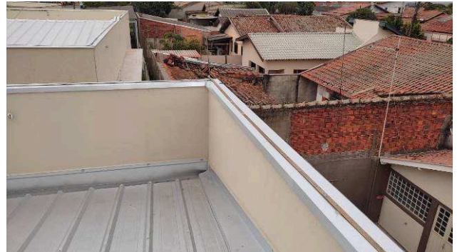
Figura 44C: Pintura das faces internas das platibandas, após aplicação de massa acrílica e lixamento - Secretaria
