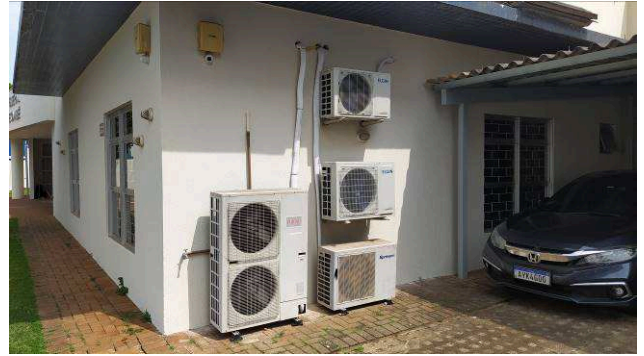
Figura 22C: Reposicionamento de condensadoras do gabinete do juiz titular, da sala de conciliação, do balcão de atendimento e da sala de audiência 1, todas com linha frigorífica nova
