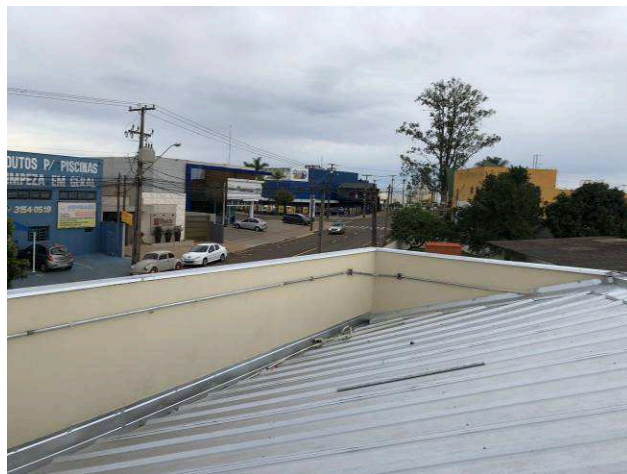
Figura 28C: Eliminação das tubulações existentes nas platibandas e fechamento dos orifícios
