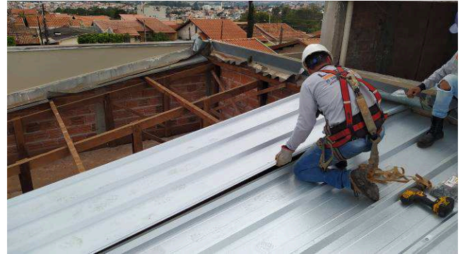
Figura 17C: Trabalhador realizando a sobreposição longitudinal de telhas, na cobertura do arquivo
