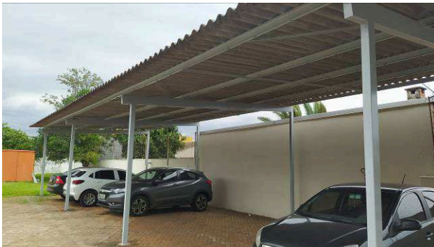
Figura 39C: Pintura da estrutura metálica de cobertura do estacionamento dos servidores
