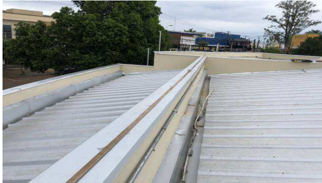
Figura 01E: SPDA reinstalado
