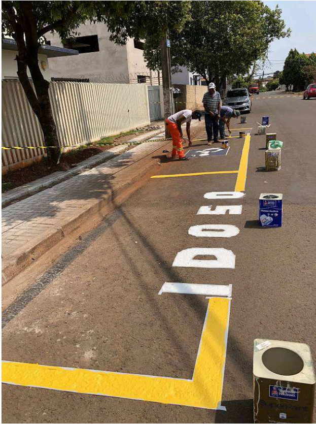
Figura 45C: Pintura das faixas de demarcação de vagas PNE e idoso
