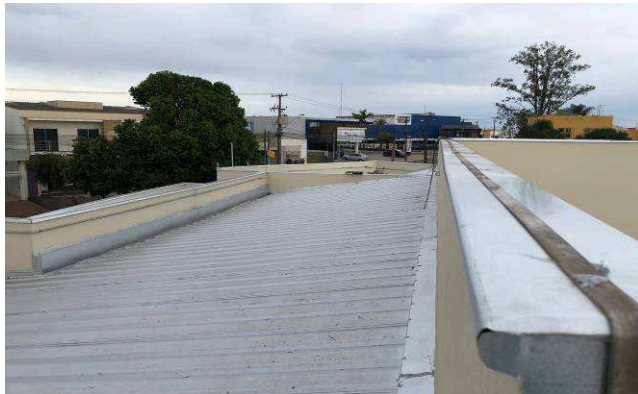
Figura 05E: SPDA reinstalado
