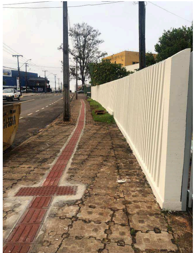
Figura 54C: Finalização do piso tátil externo, no passeio público
