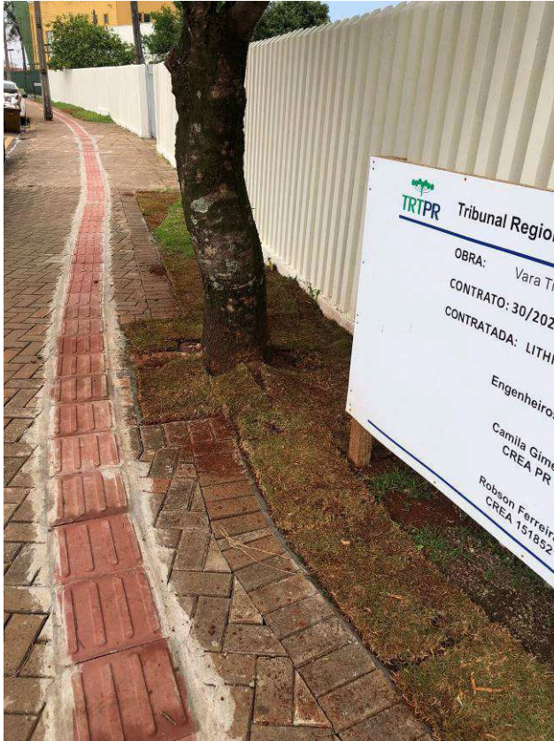
Figura 55C: Plantio de grama esmeralda, entre o paver e o muro palito
