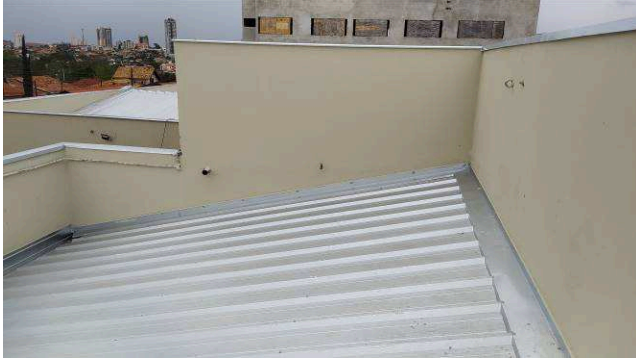
Figura 12C: Rufos instalados na região da OAB
