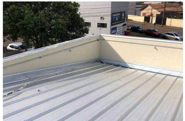
Figura 16E: Infraestrutura iluminação externa
