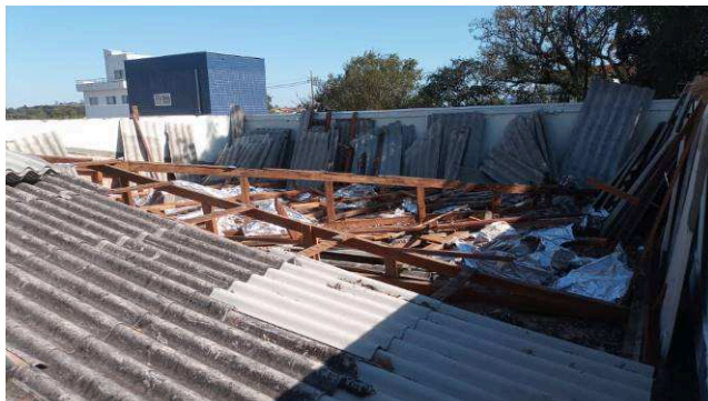
Figura 02C: Demolição e remoção das telhas de fibrocimento da cobertura
