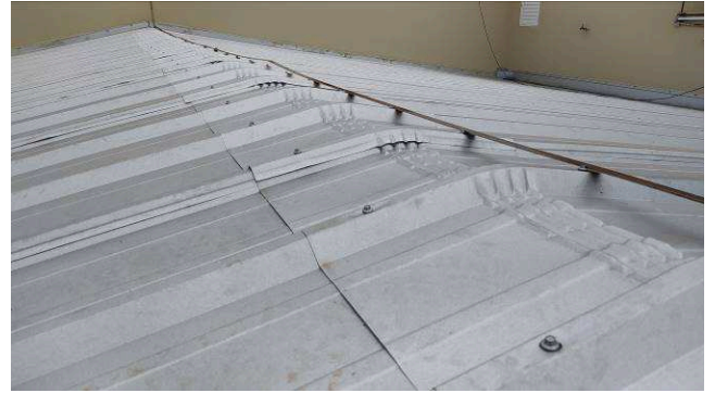
Figura 07C: Cobertura metálica termoacústica – Detalhe das goivas
