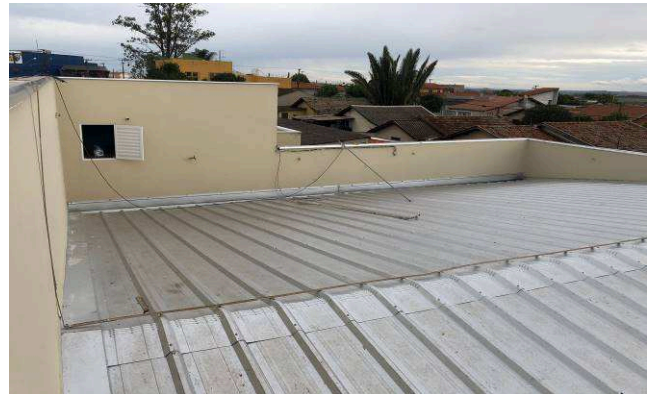
Figura 06E: SPDA reinstalado
