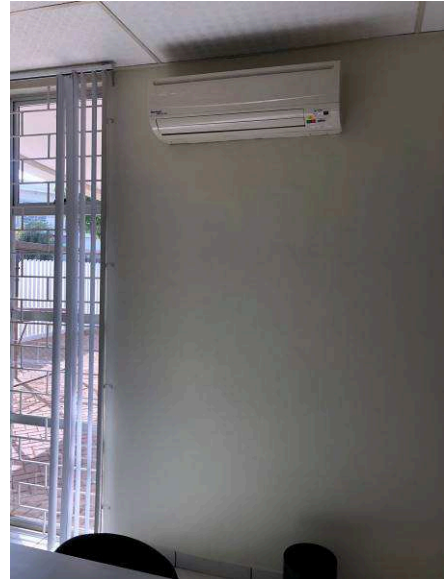
Figura 61C: Pintura nova, em todas as paredes da sala de conciliação
