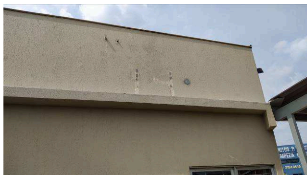
Figura 30C: Eliminação das tubulações existentes nas platibandas e fechamento dos orifícios
