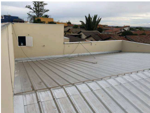
Figura 27C: Eliminação das tubulações existentes nas platibandas e fechamento dos orifícios
