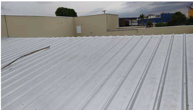
Figura 10C: Detalhe da linearidade do assentamento das telhas e goivas
