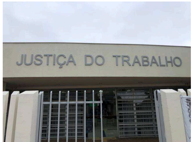
Figura 59C: Instalação de letreiro novo, conforme novo padrão
