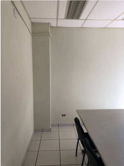
Figura 60C: Emassamento e lixamento dos trechos com pintura estufada, na sala de conciliação
