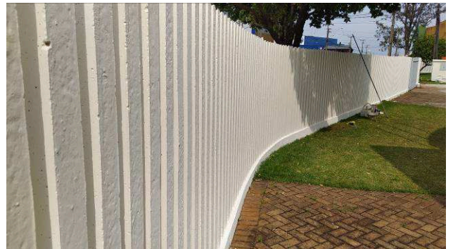
Figura 32C: Pintura dos muros palito
