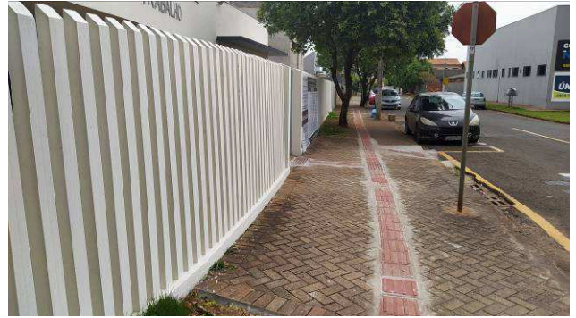
Figura 52C: Finalização do piso tátil externo, no passeio público
