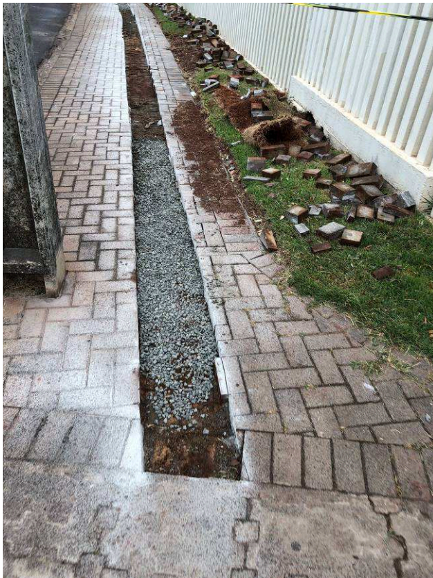
Figura 53C: Demolições realizadas antes da instalação do piso tátil externo
