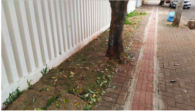
Figura 51C: Finalização do piso tátil externo, no passeio público
