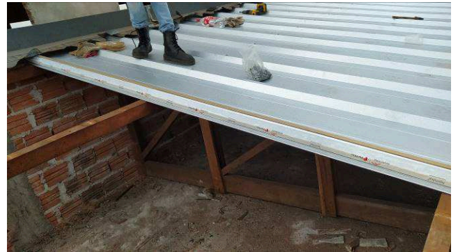
Figura 18C: Aplicação da fita butílica em local, antes da sobreposição de telhas
