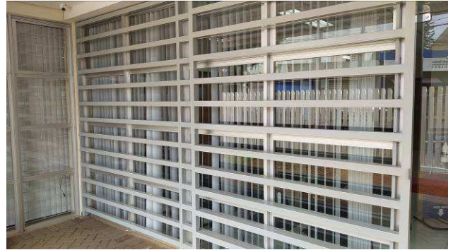
Figura 36C: Pintura dos gradis das esquadrias frontais, na entrada principal
