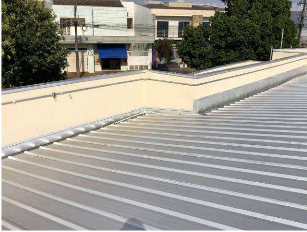
Figura 41C: Pintura das faces internas das platibandas, após aplicação de massa acrílica e lixamento – Hall público
