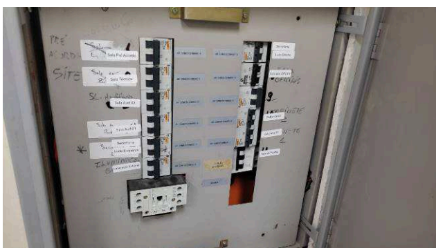
Figura 07E: Alimentação condicionadores de ar
