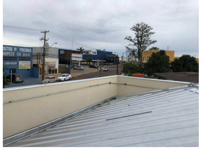
Figura 42C: Pintura das faces internas das platibandas, após aplicação de massa acrílica e lixamento – Sala dos oficiais
