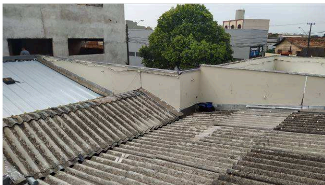
Figura 04C: Remoção da cerca elétrica no perímetro das platibandas
