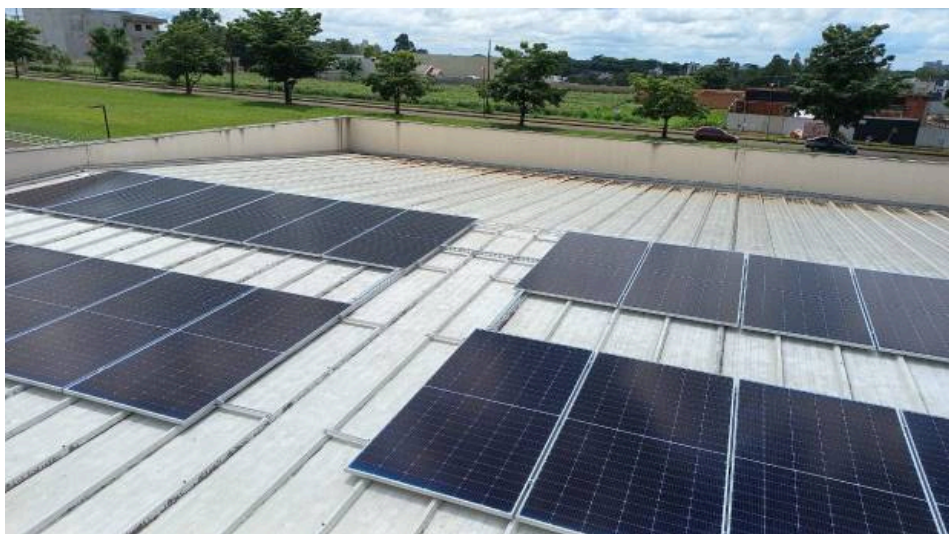
Figuras 03 – Cobertura com placas instaladas
