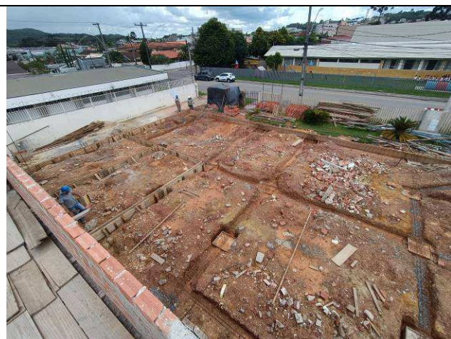
Figura 23: Vigas de baldrame - montagem.
