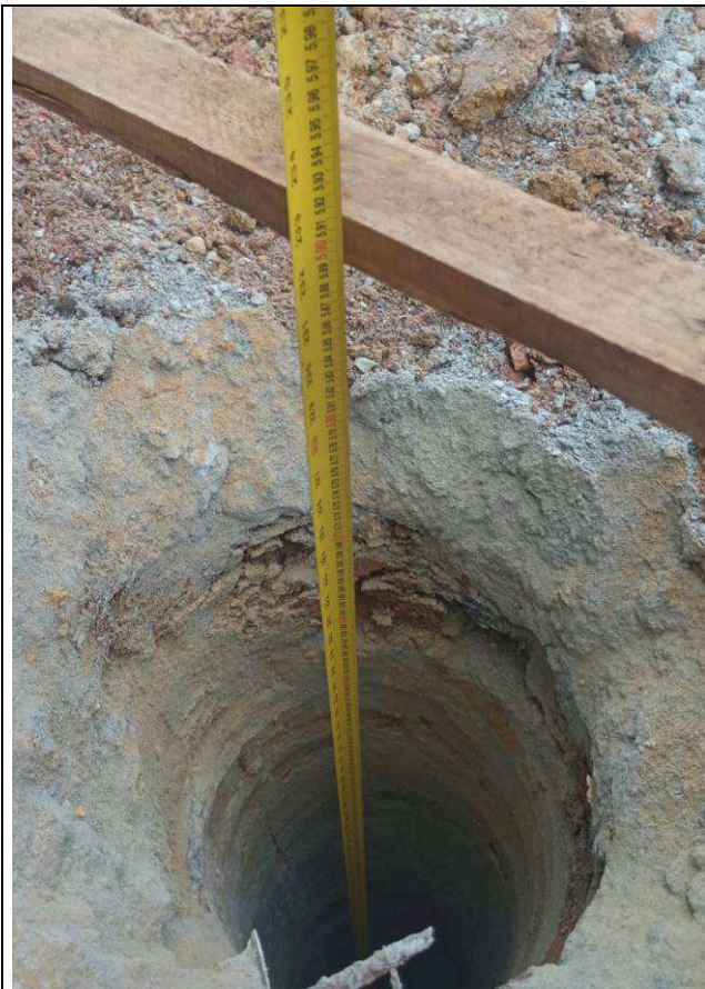
Figura 15: Perfuração das estacas.
