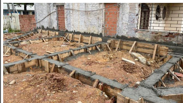
Figura 33: Vigas de baldrame concretadas.
