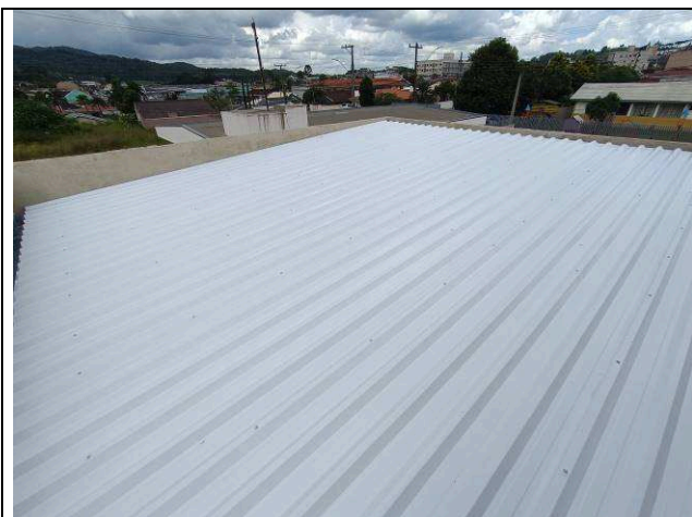
Figura 05: Telhas de cobertura.
