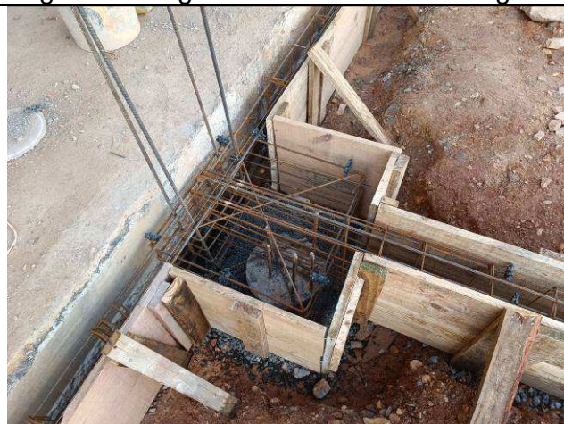
Figura 25: Vigas de baldrame.
