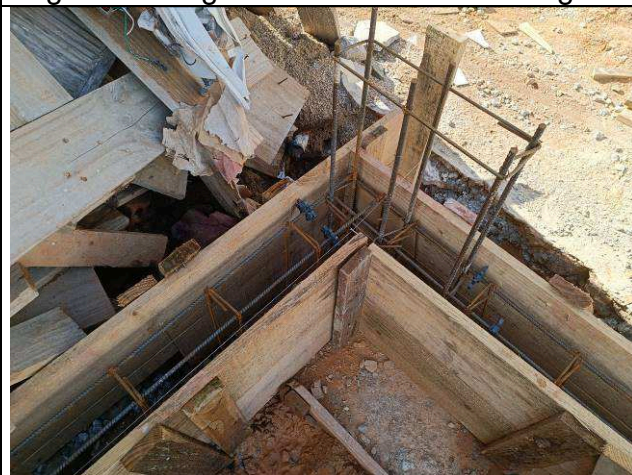
Figura 26: Vigas de baldrame.
