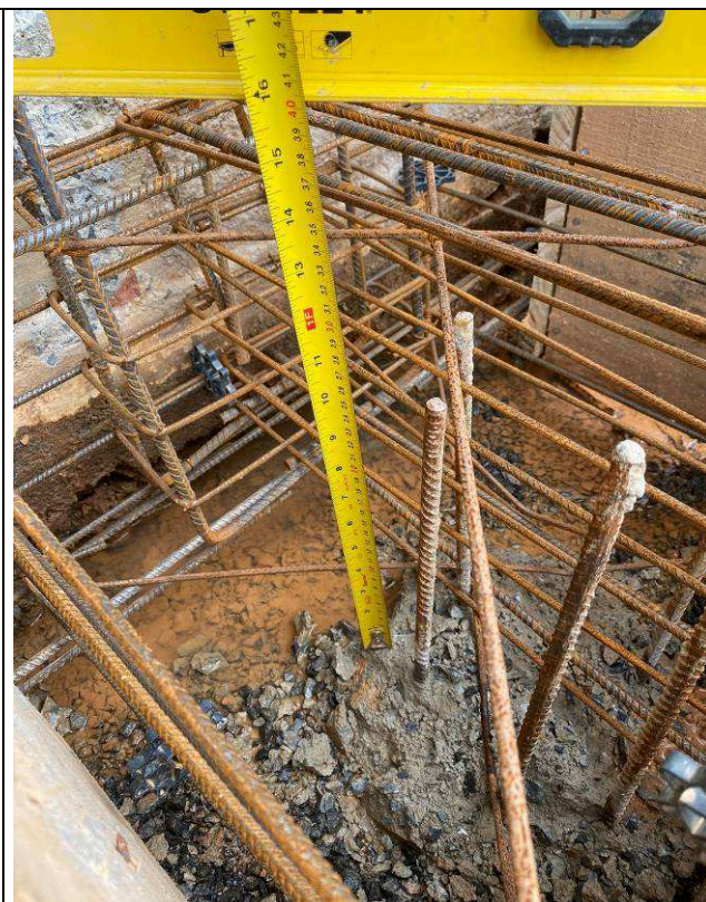
Figura 20: Blocos de fundação.
