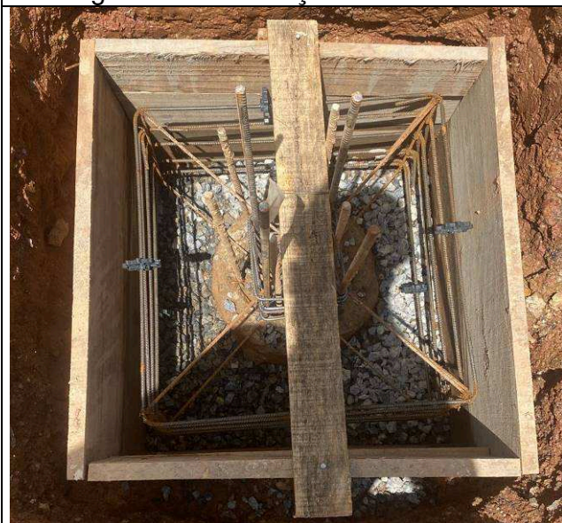
Figura 17: Blocos de fundação.
