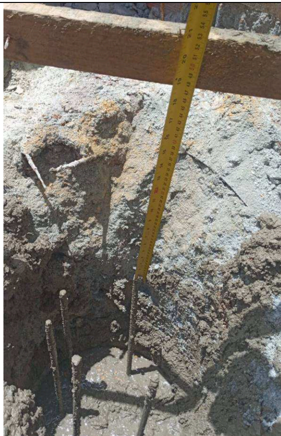
Figura 16: Concretagem das estacas.
