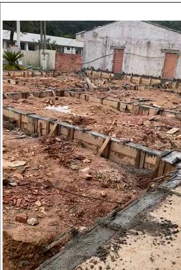
Figura 34: Vigas de baldrame.
