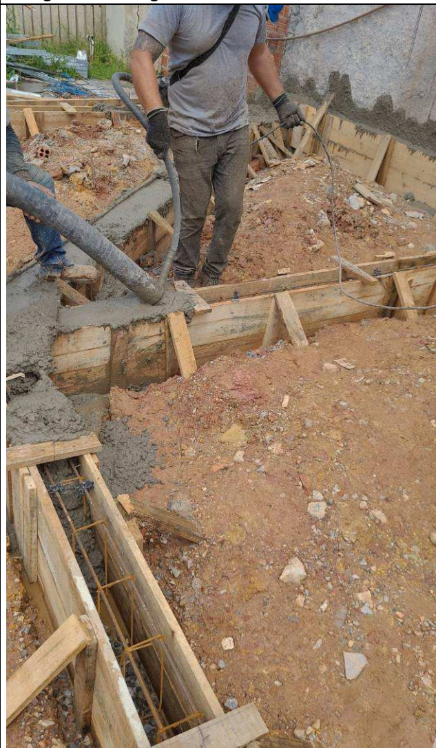
Figura 31: Vigas de baldrame concretagem.
