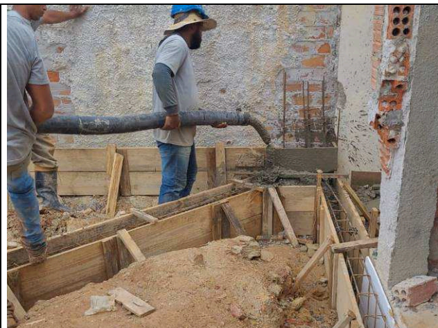
Figura 30: Vigas de baldrame concretagem.
