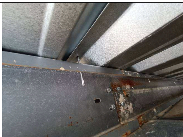
Figura 06: Telhas de cobertura.
