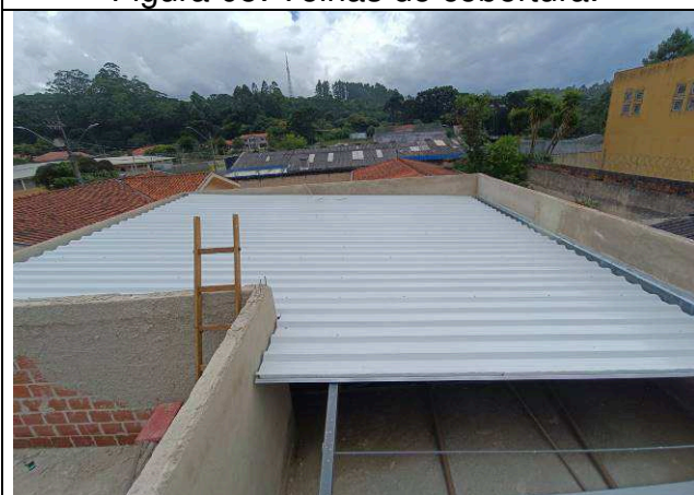
Figura 07: Telhas de cobertura.
