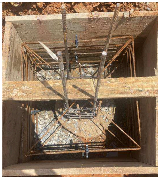
Figura 18: Blocos de fundação.
