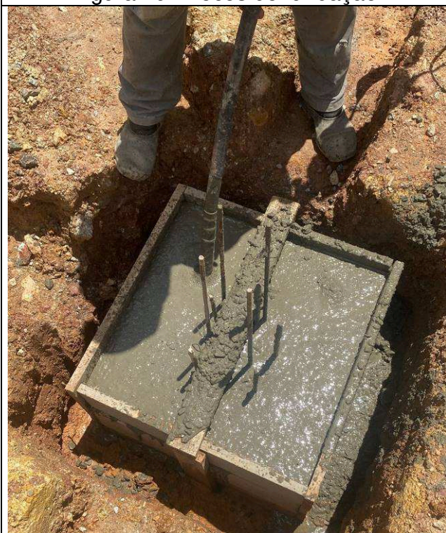
Figura 21: Blocos de fundação.
