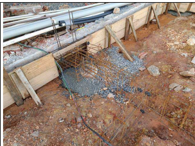
Figura 24: Vigas de baldrame - montagem.
