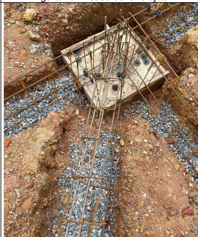
Figura 22: Vigas de baldrame.
