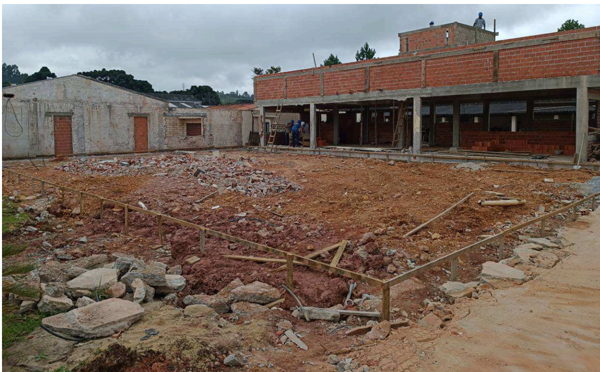
Figura 1 – Vista atual da obra.
