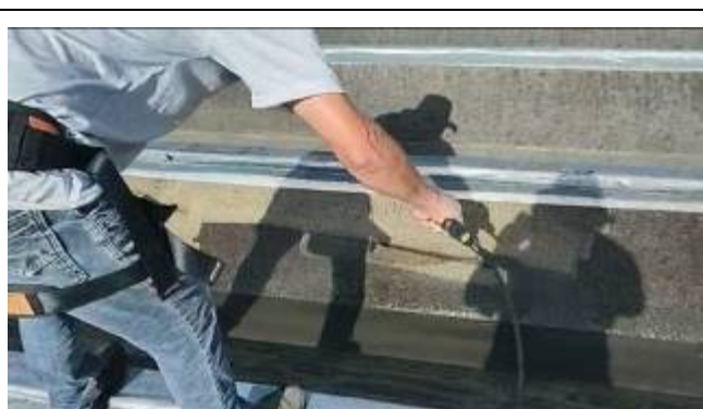
Figura 02 – lavagem da cobertura
