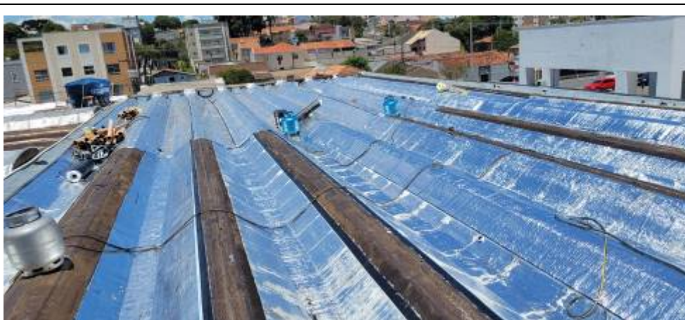
Figura 04 – Mantas sendo executadas
