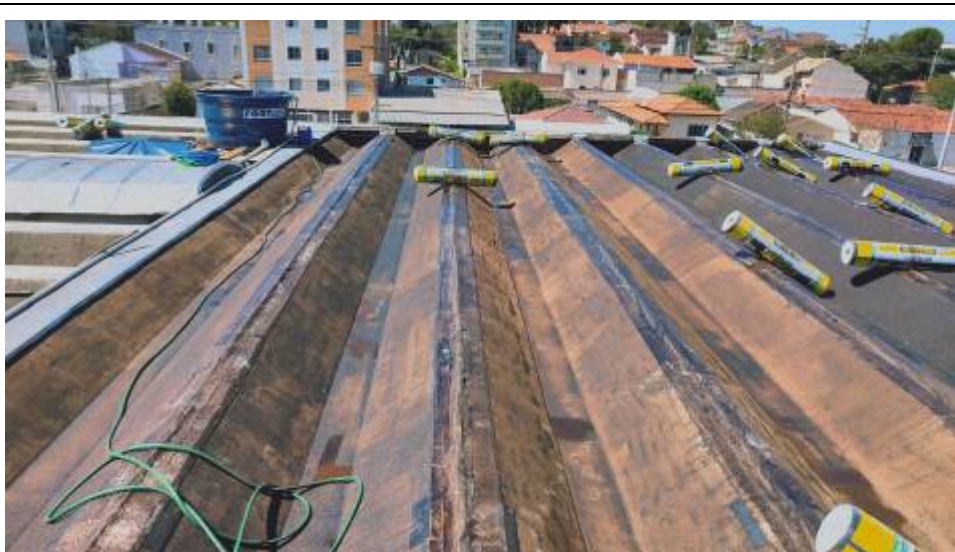
Figura 03 – Preparação para execução das mantas
