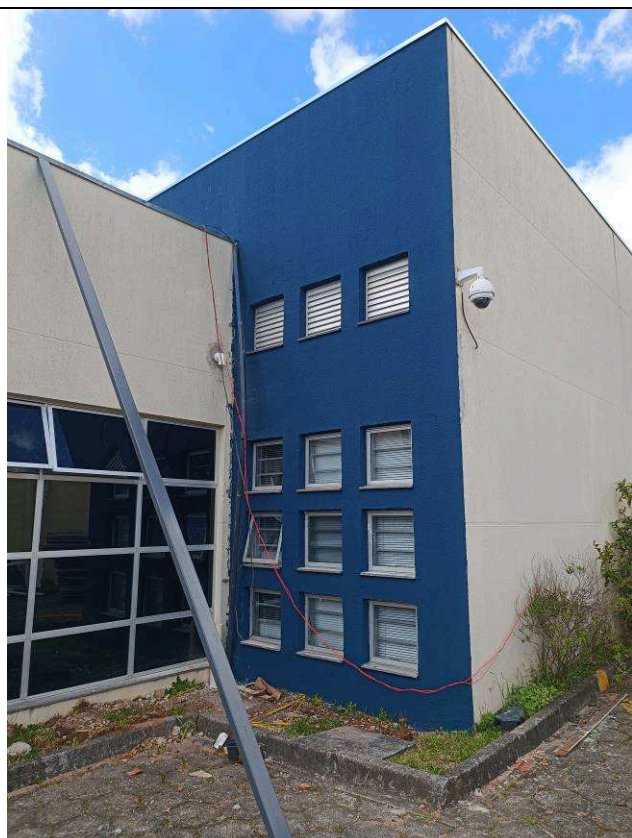
Figura 50: Aplicação de textura nas fachadas.
