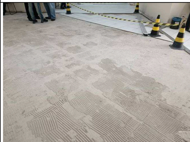
Figura 08: Remoção de pisos cerâmicos.
