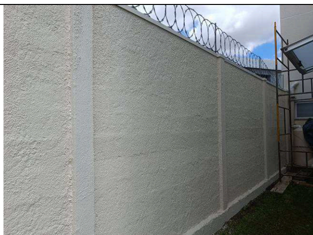
Figura 38: Pintura dos muros.
