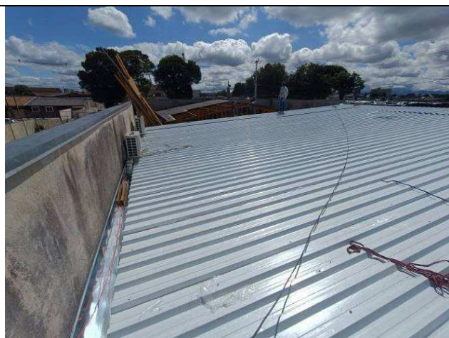
Figura 23: Estrutura e telhas de cobertura.
