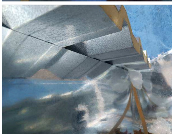
Figura 30: Traspasse da telha na calha.
