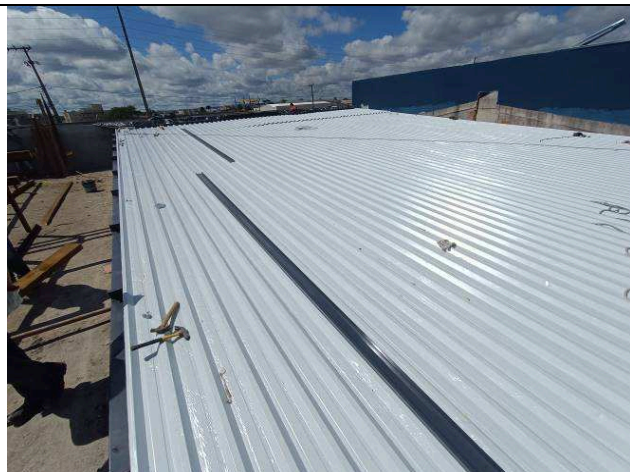
Figura 25: Estrutura e telhas de cobertura.
