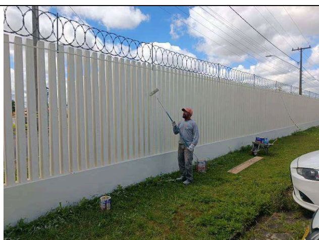
Figura 40: Pintura dos muros.
