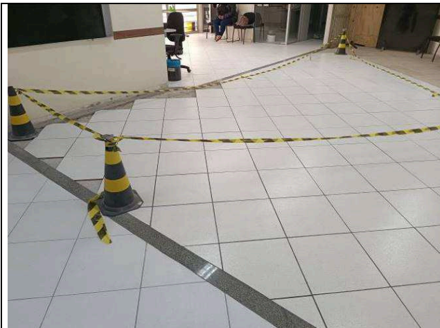
Figura 11: Piso cerâmico e soleiras de granito – hall público.
