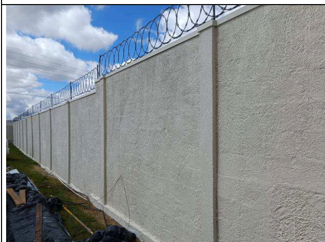
Figura 37: Pintura dos muros.
