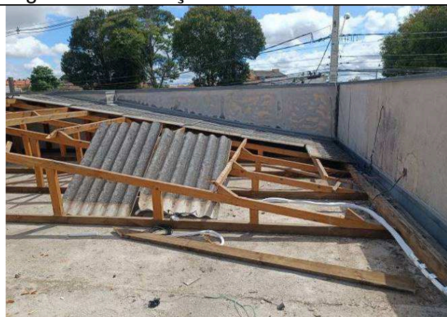
Figura 03: Remoção da cobertura existente.
