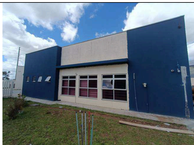
Figura 48: Aplicação de textura nas fachadas.
