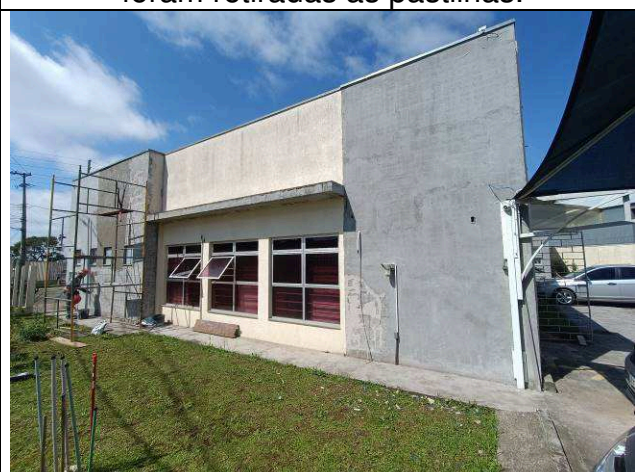
Figura 45: Regularização dos locais onde foram retiradas as pastilhas.
