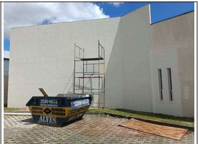
Figura 02: Andaimetes Metálicas.
