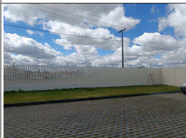
Figura 39: Pintura dos muros.
