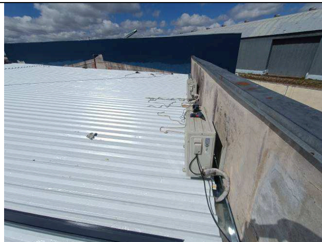
Figura 26: Estrutura e telhas de cobertura.
