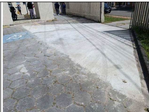
Figura 18: Contrapiso na entrada do estacionamento público.
