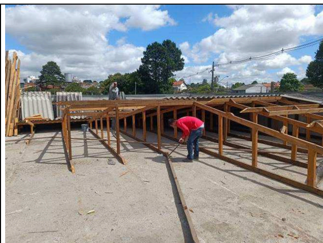
Figura 02: Remoção da cobertura existente.
