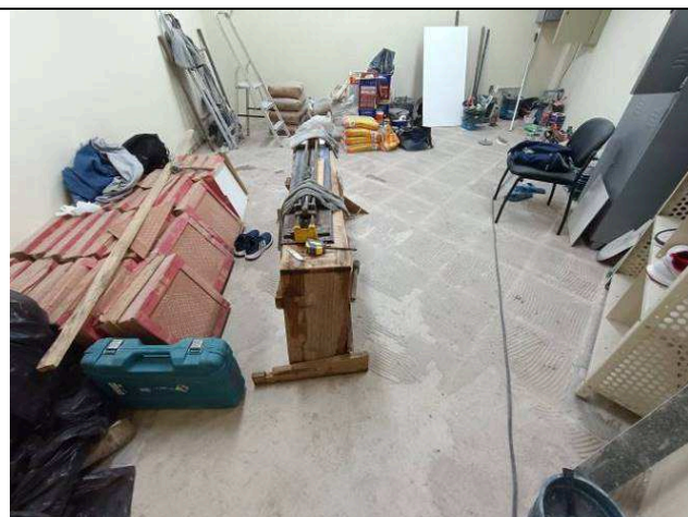
Figura 07: Remoção de pisos cerâmicos.
