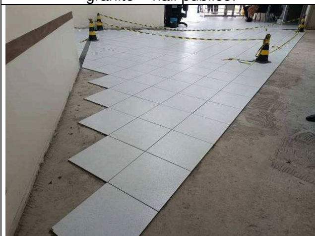
Figura 13: Piso cerâmico – hall público.
