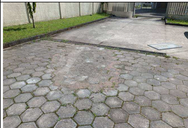
Figura 16: Regularização do piso intertravado - estacionamento.
