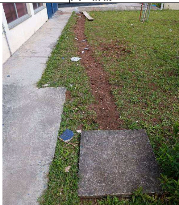
Figura 34: Caixas de passagem e prumadas.
