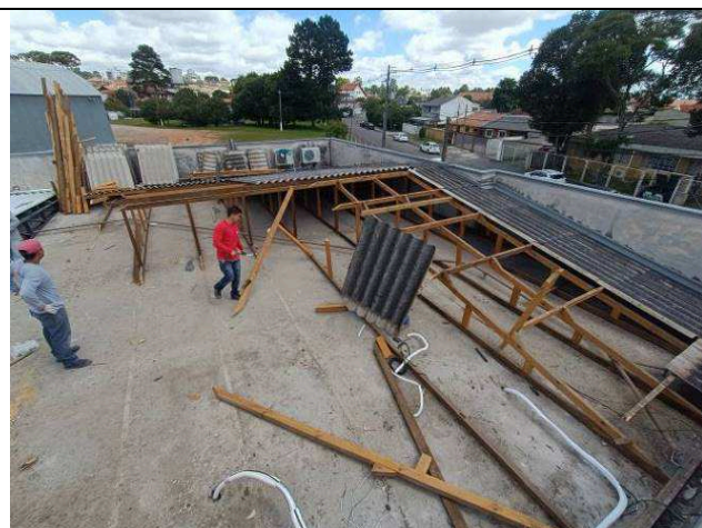
Figura 01: Remoção da cobertura existente.
