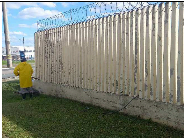
Figura 36: Lavagem dos muros palitos.
