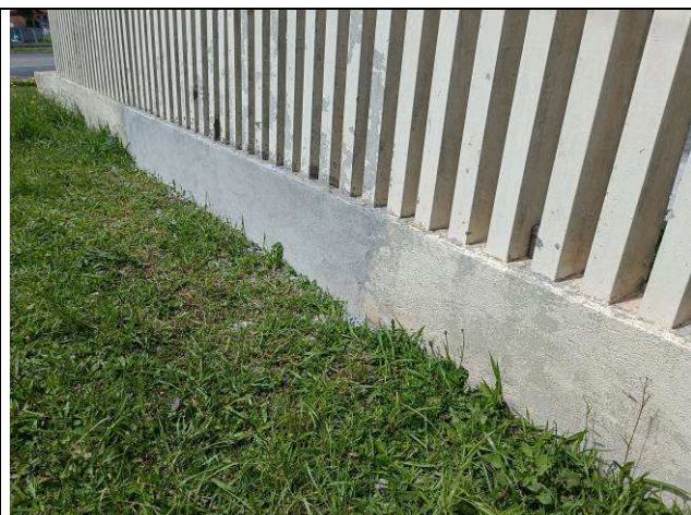
Figura 42: Tratamento fissura do muro.
