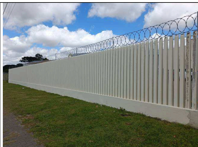
Figura 41: Pintura dos muros.
