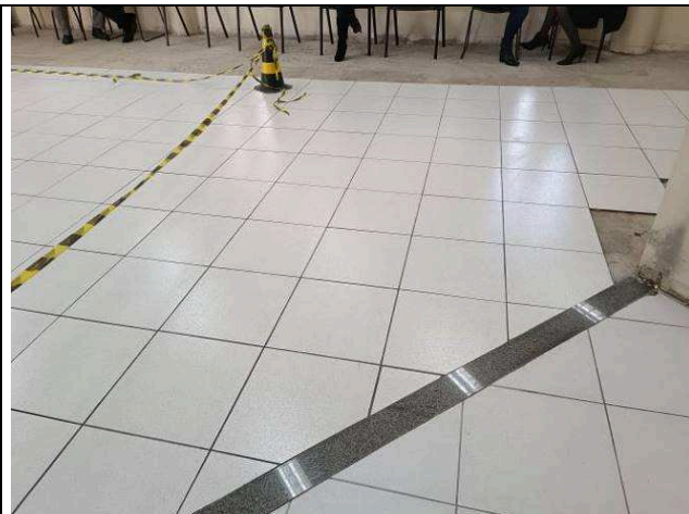
Figura 12: Piso cerâmico e soleiras de granito – hall público.
