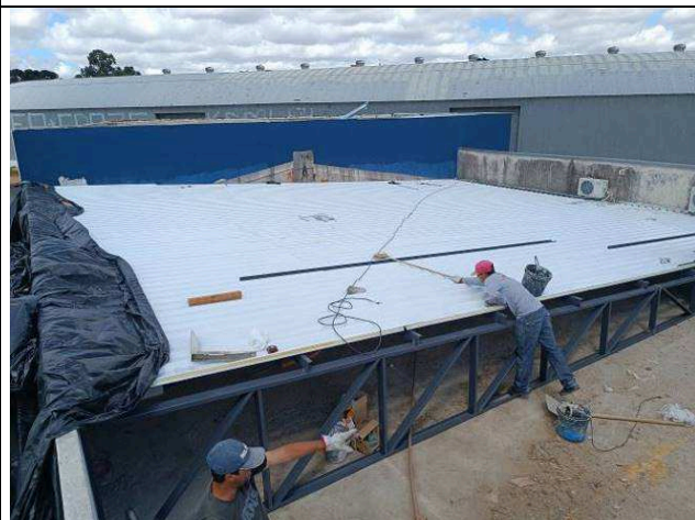
Figura 21: Estrutura e telhas de cobertura.
