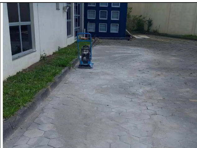
Figura 17: Regularização do piso intertravado - estacionamento.
