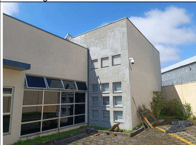
Figura 43: Regularização dos locais onde foram retiradas as pastilhas.
