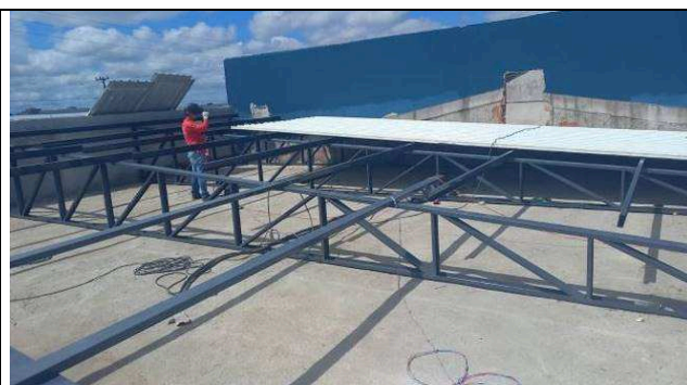
Figura 19: Montagem da estrutura de cobertura.
