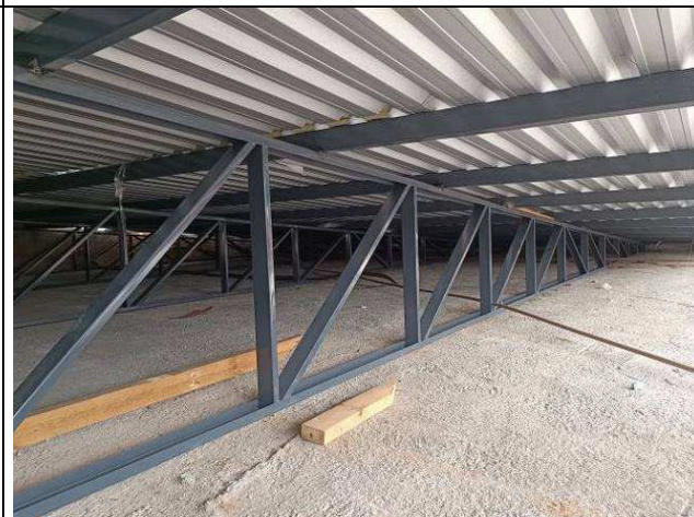
Figura 22: Estrutura e telhas de cobertura.
