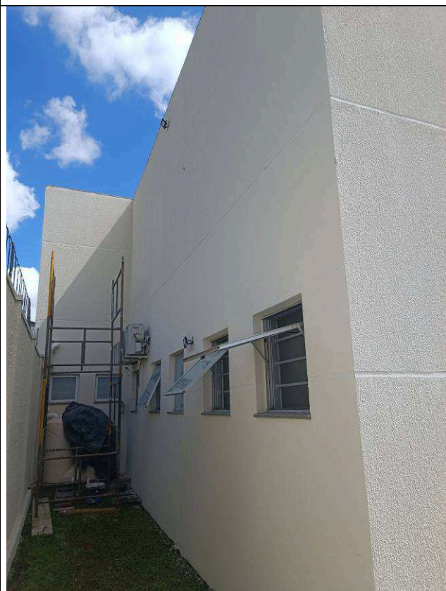
Figura 49: Aplicação de textura nas fachadas.
