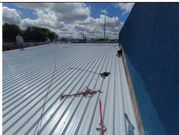
Figura 24: Estrutura e telhas de cobertura.
