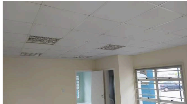
Figura 02C: Instalação de placas de forro no gabinete do juiz titular – 2ª vara
