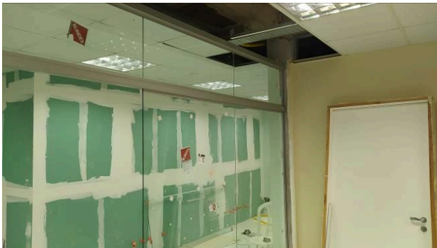
Figura 48C: Execução de vidro fixo sobre caixilhos de alumínio, na entrada do Cejusc
