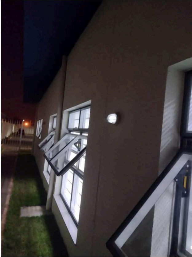
Figura 13C: Janelas da secretaria da 1ª Vara, com vedação executada
