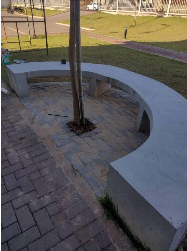
Figura 27C: Calçamento das áreas abaixo dos bancos de concreto
