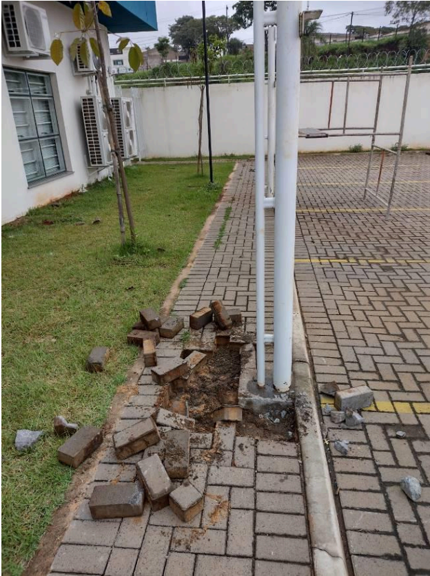
Figura 35C: Remoção da cobertura de veículos na estacionamento do bloco direito
