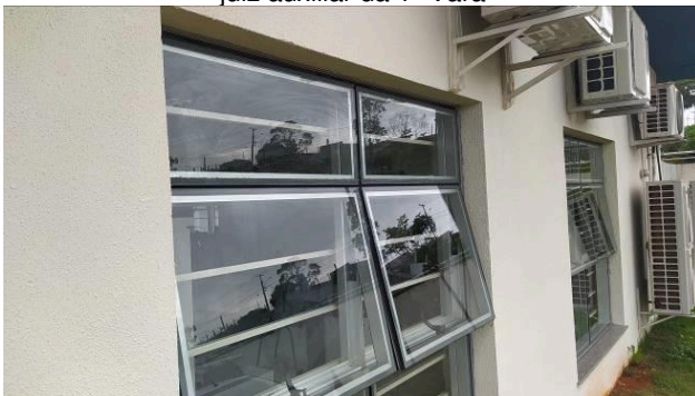
Figura 11C: Vedação de janelas - Gabinete do juiz titular da 1ª Vara
