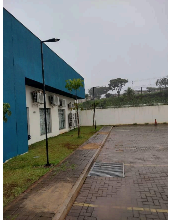
Figura 14C: Janelas da secretaria da 1ª Vara, com vedação executada
