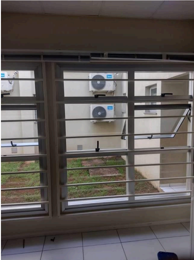
Figura 09C: Pintura das grades das janelas – Gabinete do juiz auxiliar da 1ª Vara
