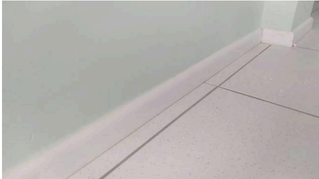
Figura 07C: Pintura de rodapés – Gabinete do juiz auxiliar da 2ª vara
