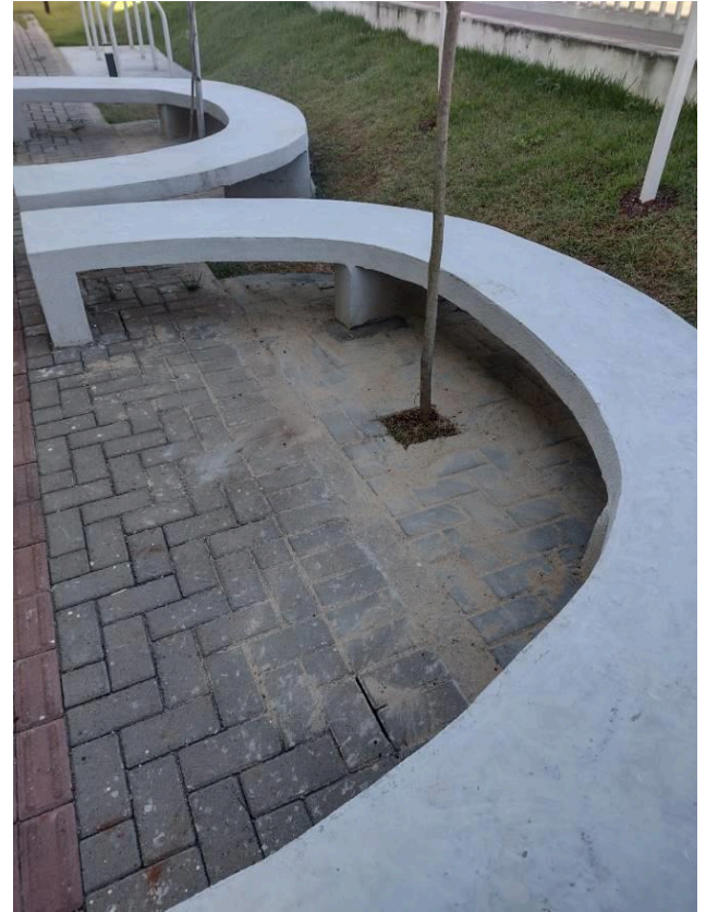
Figura 26C: Calçamento das áreas abaixo dos bancos de concreto
