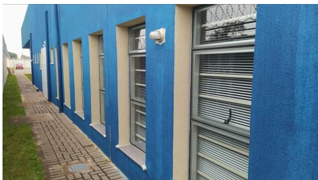
Figura 23C: Fachada posterior do imóvel, com uma demão de pintura
