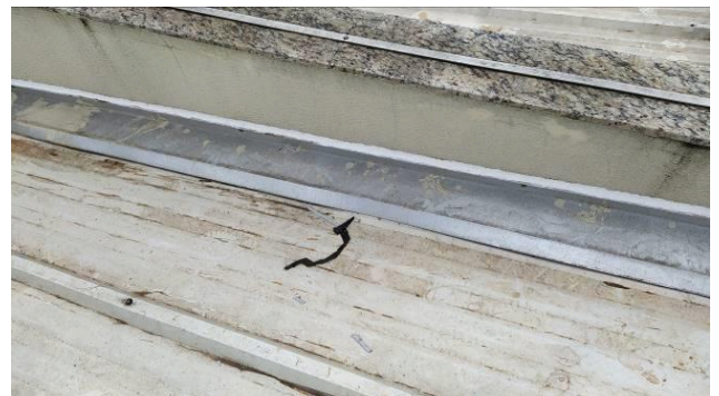
Figura 51C: Vedação de rufo, no bloco direito
