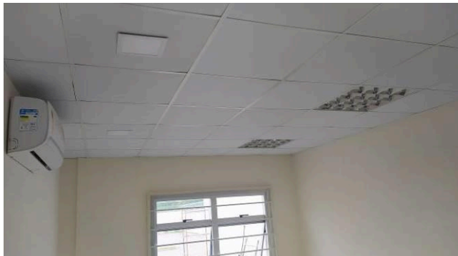
Figura 01C: Instalação de placas de forro na sala dos assistentes – 2ª vara
