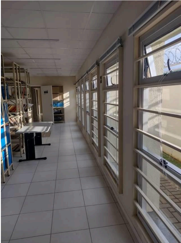
Figura 15C: Pintura das grades das janelas – Arquivo
