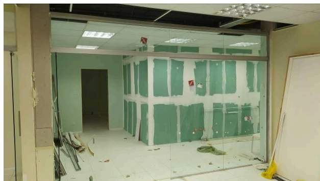
Figura 45C: Remoção de parede frontal, na execução das salas do Cejusc
