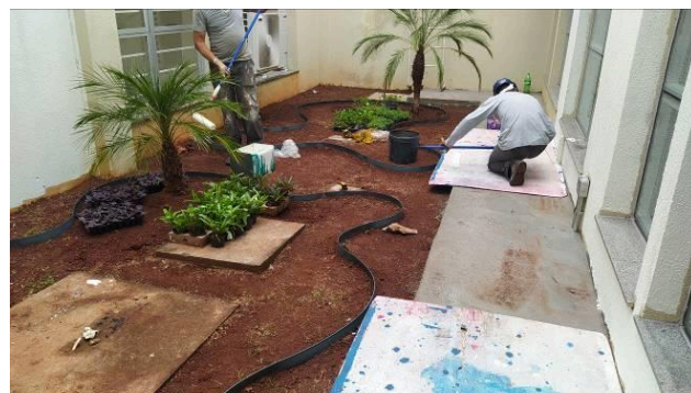
Figura 34C: Execução da calçada em cimentado, no fosso de luz do bloco esquerdo
