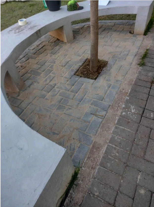
Figura 25C: Calçamento das áreas abaixo dos bancos de concreto
