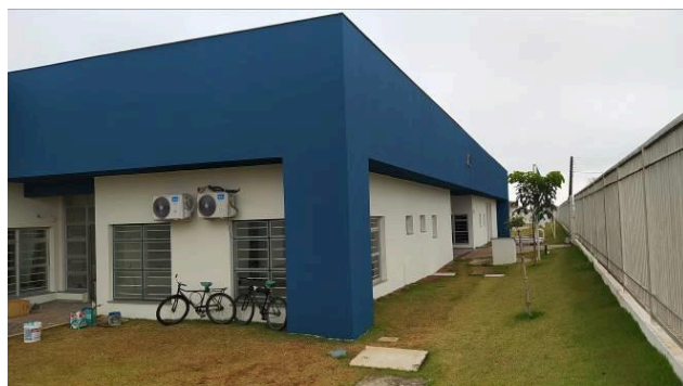
Figura 20C: Fachada frontal do bloco central, com duas demãos de pintura finalizadas
