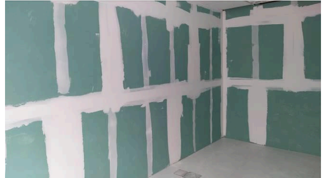
Figura 47C: Execução de parede de gesso acartonado (drywall), na divisão das salas do Cejusc
