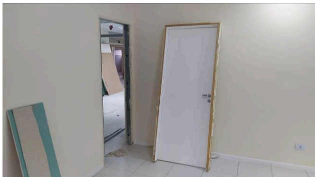
Figura 40C: Remoção da porta, na sala de testemunhas
