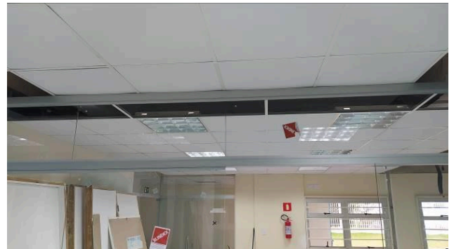
Figura 49C: Execução de vidro fixo sobre caixilhos de alumínio, na entrada do Cejusc
