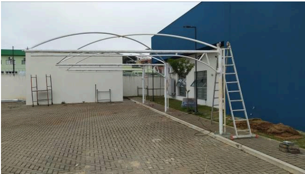
Figura 37C: Coberturas veiculares já instaladas no estacionamento do bloco esquerdo
