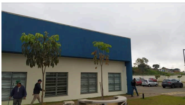
Figura 21C: Fachada lateral do bloco esquerdo com duas demãos de pintura finalizadas
