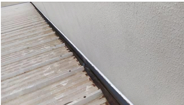
Figura 50C: Vedação de contra-calha, no bloco direito
