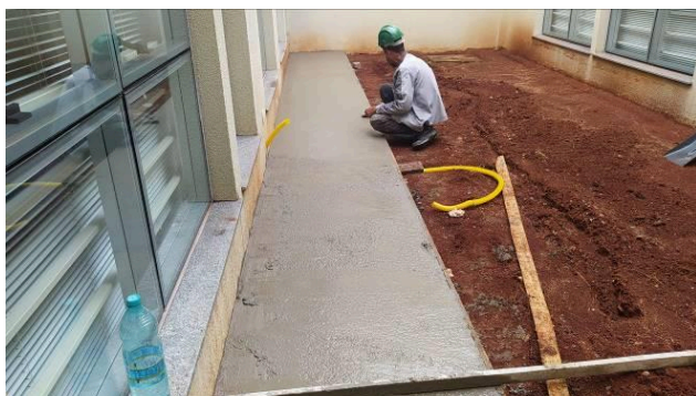
Figura 33C: Execução da calçada em cimentado, no fosso de luz do bloco direito
