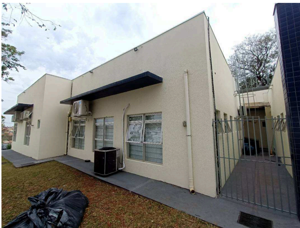
Figura 3 – Vista lateral e Fundos – Pintura Externa.
