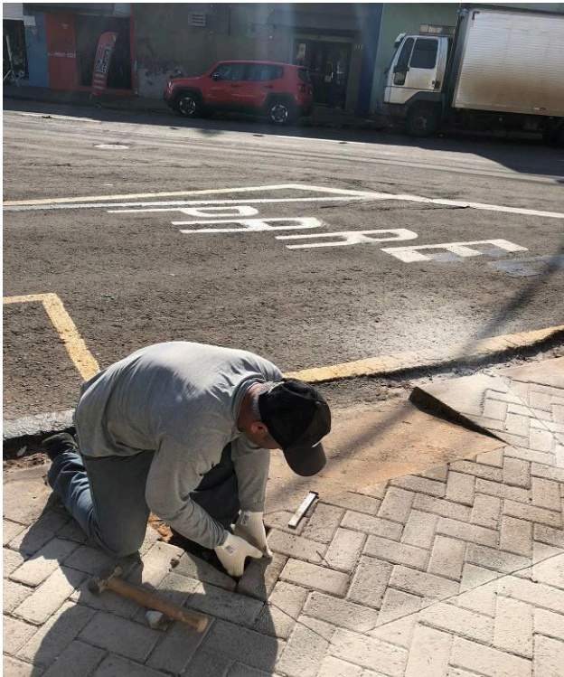
Figura 41C: Preparos para execução da rampa PNE
