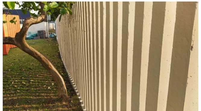
Figura 12C: Pintura parcial do muro palito
