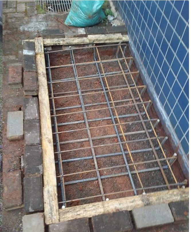
Figura 29C: Fôrma e armadura do bloco radier
