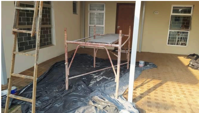
Figura 03C: Utilização de andaimes metálicos
