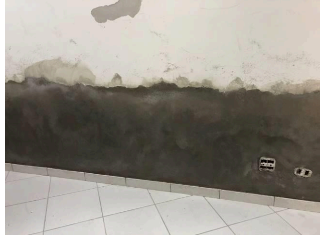
Figura 45C: Aplicação do revestimento impermeabilizante e rebôco
