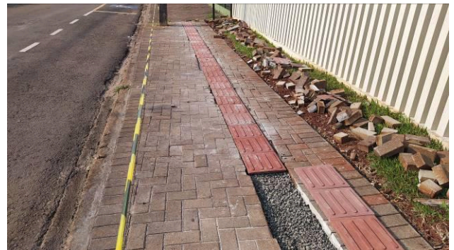
Figura 38C: Início da instalação do piso podotátil em placa cimentícia, no passeio público
