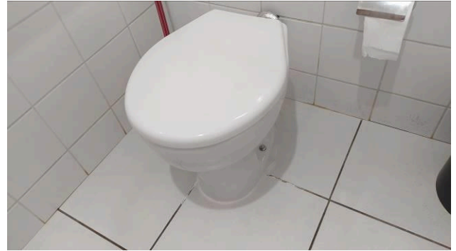
Figura 35C: Assento para vaso sanitário instalados nos vasos dos banheiro públicos
