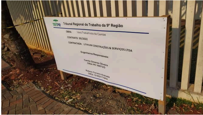
Figura 01C: Placa de obra em chapa de aço galvanizado 2,00m x 1,00m
