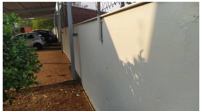
Figura 06C: Pintura do muro dos fundos
