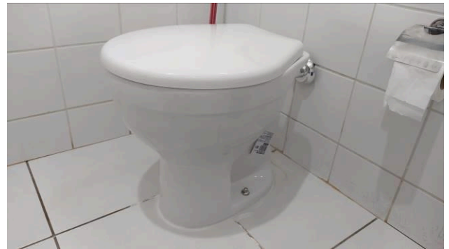
Figura 33C: Vaso sanitário PCD, instalado no BWC público feminino
