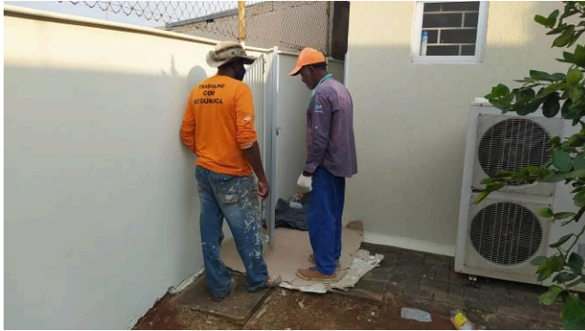
Figura 13C: Pintores iniciando a pintura de um dos portões
