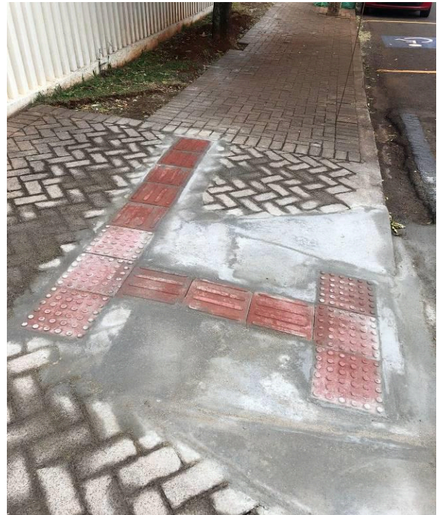
Figura 42C: Rampa de acesso PNE já concluída
