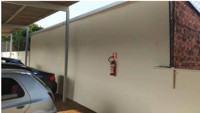
Figura 09C: Pintura das elevações localizadas no fundo do imóvel
