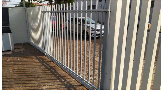
Figura 14C: Muro palito e portão de veículos, após pintura
