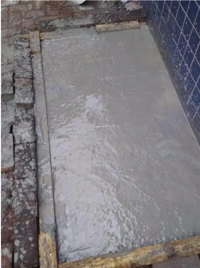
Figura 30C: Concretagem do bloco radier
