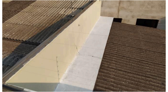
Figura 26C: Impermeabilização da marquise frontal
