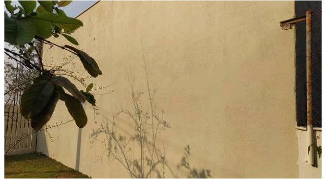
Figura 08C: Pintura das elevações localizadas no fundo do imóvel
