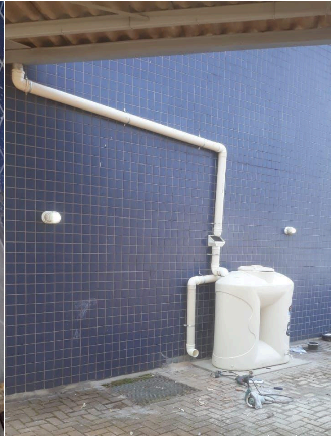
Figura 31C: Cisterna de reuso já instalada sobre o bloco
