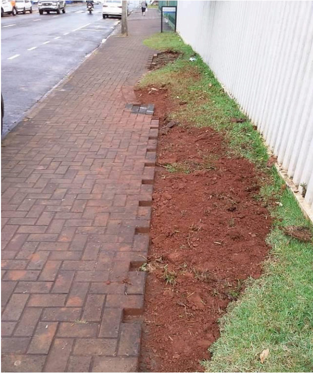
Figura 39C: Demolição de paver para linearização do passeio público
