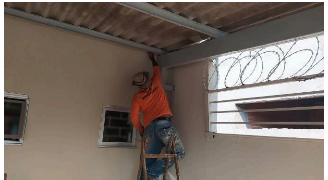
Figura 18C: Pintor realizando recorte de pintura em parede, no estacionamento privativo
