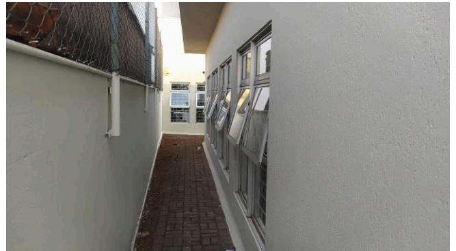
Figura 10C: Pintura do muro dos fundos e da parede dos fundos
