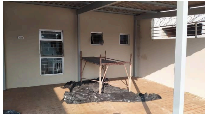
Figura 04C: Utilização de andaimes metálicos
