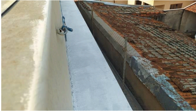
Figura 25C: Impermeabilização da marquise posterior
