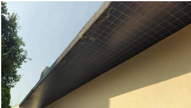
Figura 17C: Limpeza das pastilhas e pintura das fachadas
