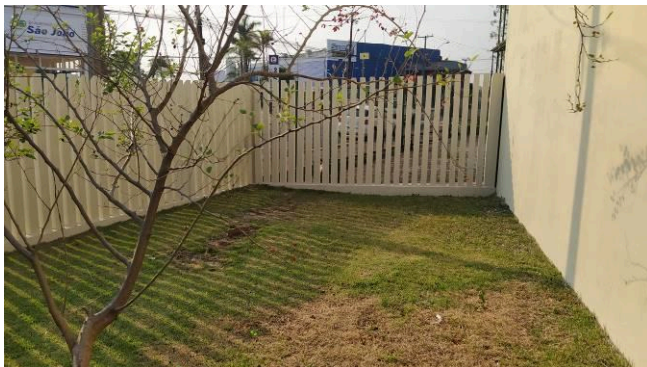
Figura 11C: Pintura parcial do muro palito
