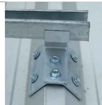
DETALHE DE FIXAÇÃO
