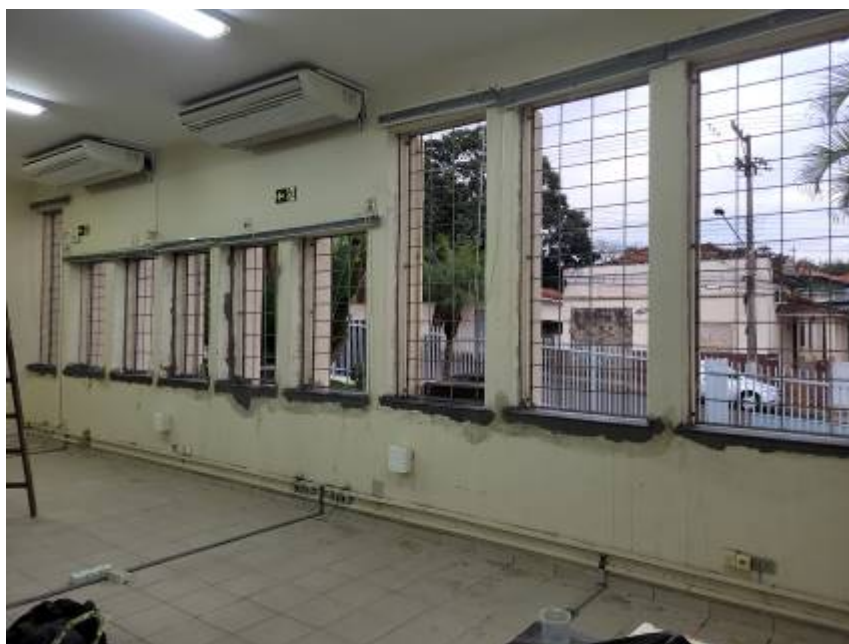
Figuras 01: remoção das janelas existentes
