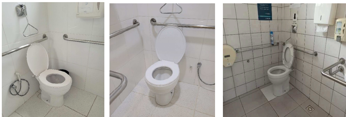
Figuras 13 – Vasos Sanitários e Assentos substituídos – Ponta Grossa e União da Vitória
