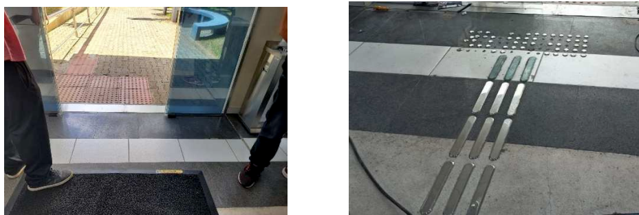
Figuras 10 – Preenchimento do rebaixo do capacho, antes e depois.
