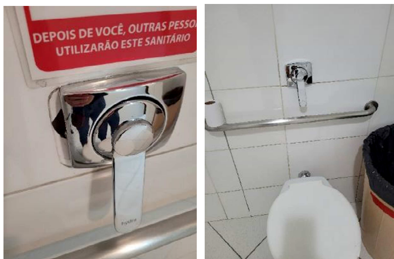
Figuras 25 – Válvulas substituídas – Banheiros Públicos Adaptados no térreo do Fórum de Curitiba.
