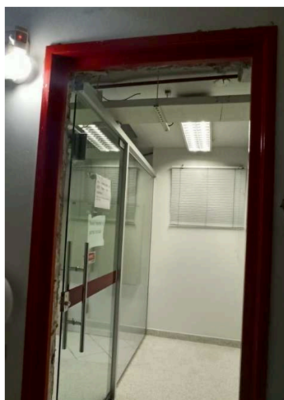
Figuras 11 – Relocação de porta e acréscimo de vidro temperado fixo - STI
