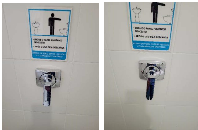
Figuras 27 – Válvulas substituídas – Banheiros Públicos Adaptados no 6º pavimento do Fórum de Curitiba.
