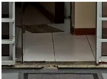
Figuras 21 – Soleira quebrada na porta fundos, acesso estacionamento no Fórum do Trabalho de Araucária.
