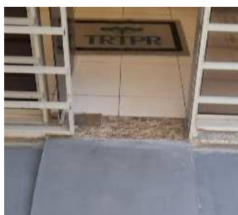
Figuras 23 – Instalação de soleira na porta fundos, acesso estacionamento no Fórum do Trabalho de Araucária.
