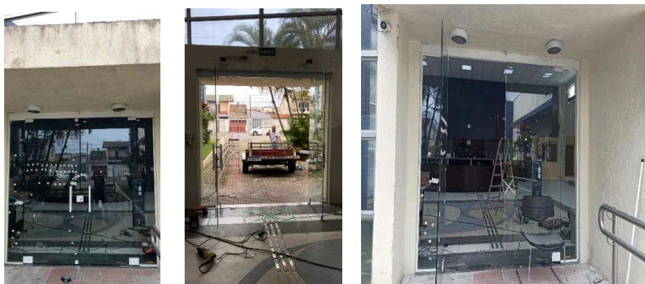
Figuras 12 – Porta principal instalada em vidro temperado 10 mm, com molas e ferragens.
