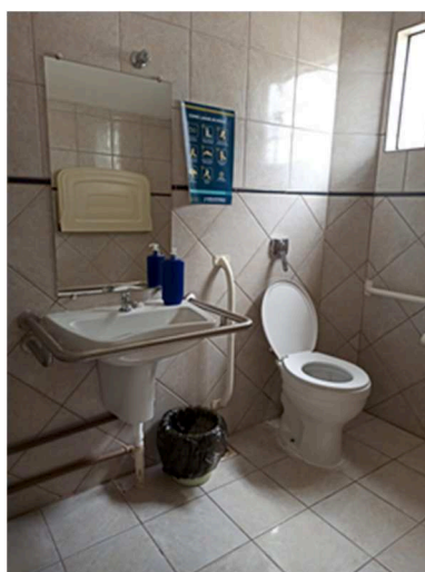
Figuras 33 – Execução de piso cerâmico sob vaso.
