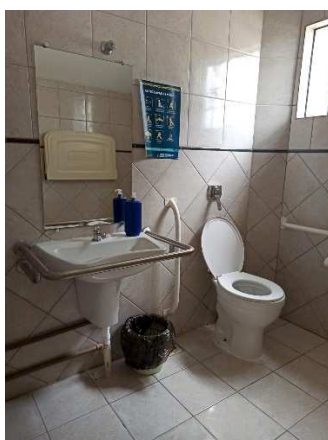
Figuras 31 – Válvulas substituídas – Banheiros Públicos Adaptados em Irati.
