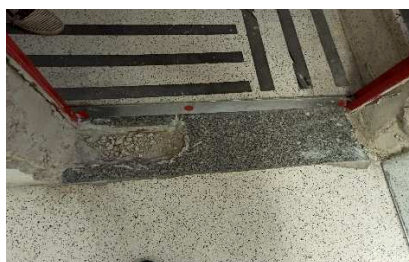
Figuras 22 – Soleira quebrada na porta STI no Fórum do Trabalho de Curitiba.
