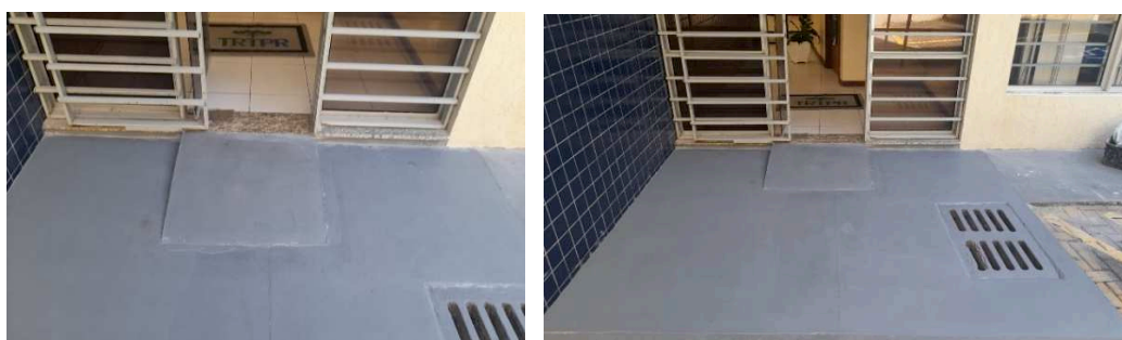
Figuras 9 – Execução de rampa no acesso ao Fórum pelos fundos.
