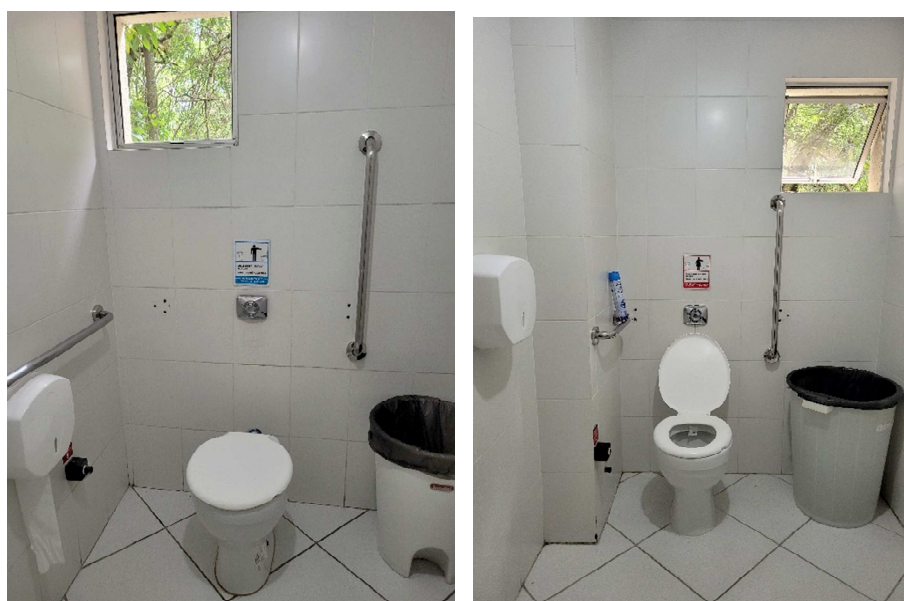
Figuras 14 – Banheiros adaptados 2º Piso do Fórum Trabalhista de Curitiba
