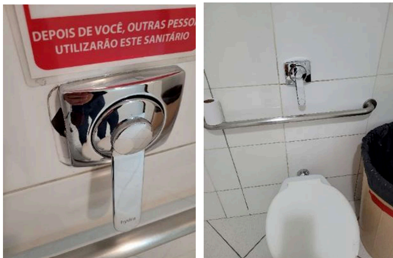
Figuras 9 – Base das válvulas substituídas – Banheiros Públicos Adaptados no térreo
