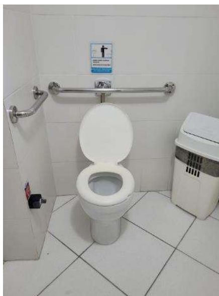
Figuras 3 – Vaso Sanitário e Assento substituído - Banheiro Público 4º Piso
