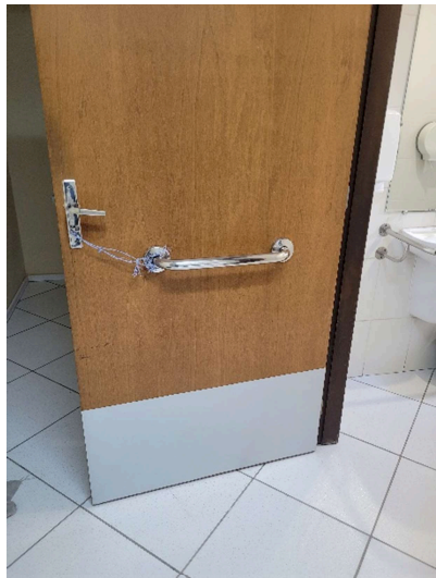
Figuras 17 – Chapas de laminado nas portas – Banheiros Públicos Adaptados no 6º Pavimento.
