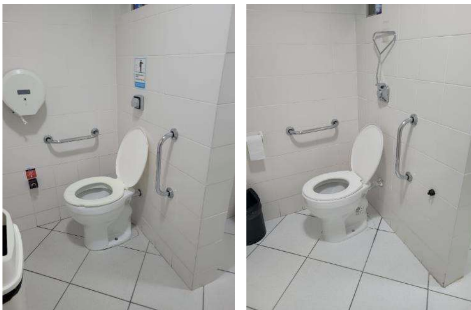
Figura 6 – Louça Sanitária substituída e barras de apoio instaladas – Banheiro Adaptado 5ª Vara
