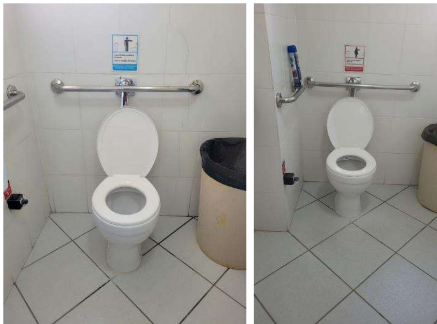
Figuras 5 – Vasos Sanitários e Assentos substituídos - Banheiros Públicos 10º Piso
