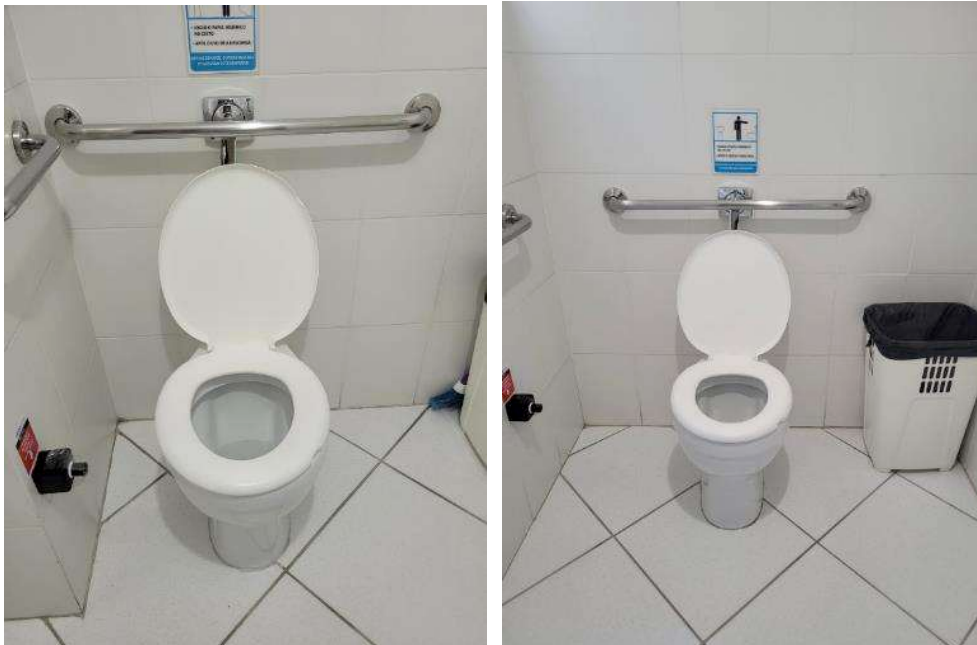
Figuras 4 – Vasos Sanitários e Assentos substituídos - Banheiros Públicos 6º Piso
