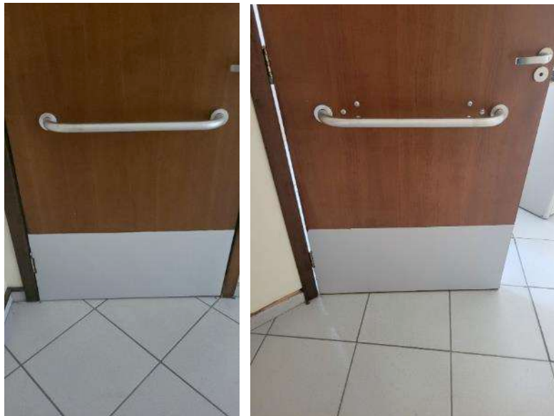
Figuras 18 – Chapas de laminado nas portas – Banheiros Públicos Adaptados no 8º Pavimento.
