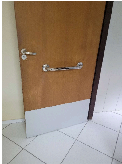
Figuras 17 – Chapas de laminado nas portas – Banheiros Públicos Adaptados no 6º Pavimento.
