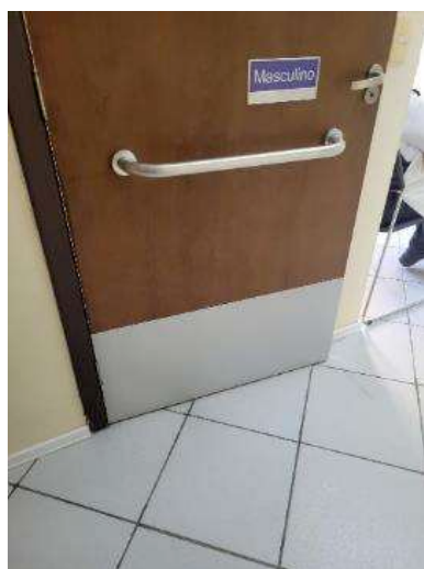
Figuras 17 – Chapas de laminado nas portas – Banheiros Públicos Adaptados no 6º Pavimento.
