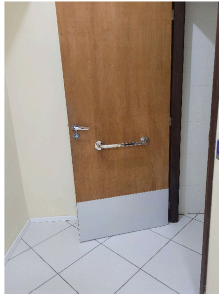
Figuras 15 – Chapas de laminado nas portas – Banheiros Públicos Adaptados no 2º Pavimento.
