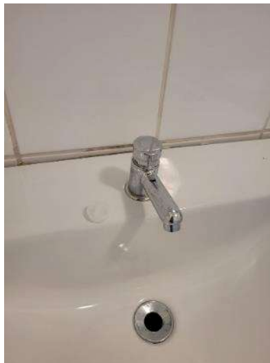
Figura 8 – Torneira substituída - Banheiro Adaptado da 5ª Vara
