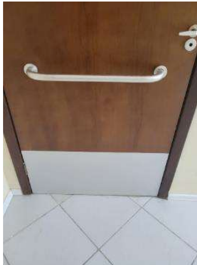
Figuras 17 – Chapas de laminado nas portas – Banheiros Públicos Adaptados no 6º Pavimento.
