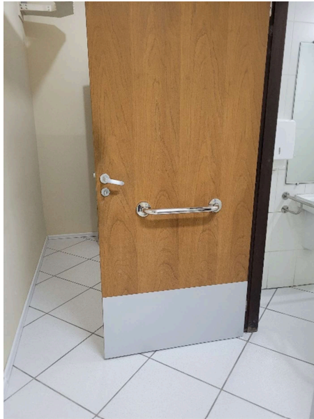
Figuras 15 – Chapas de laminado nas portas – Banheiros Públicos Adaptados no 2º Pavimento.
