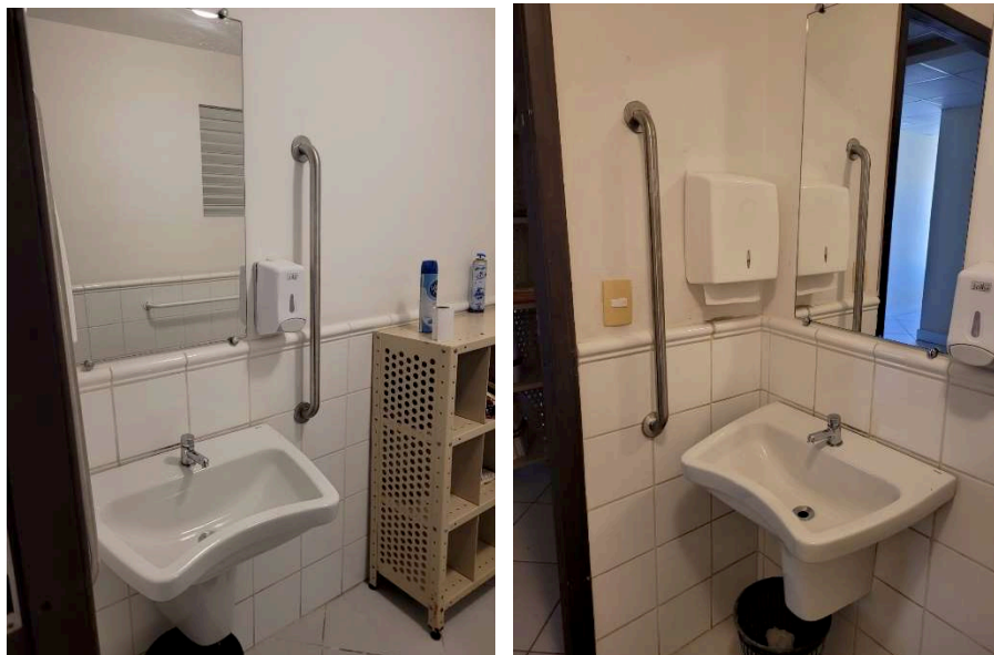
Figura 6 – Louça Sanitária substituída e barras de apoio instaladas – Banheiro Adaptado 5ª Vara
