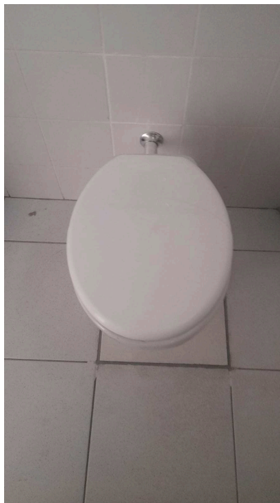
Vaso sanitário, assento sanitário e válvula de descarga.
