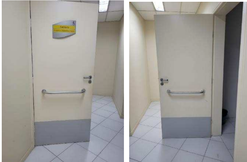
Chapa nas portas do banheiro adaptado.
