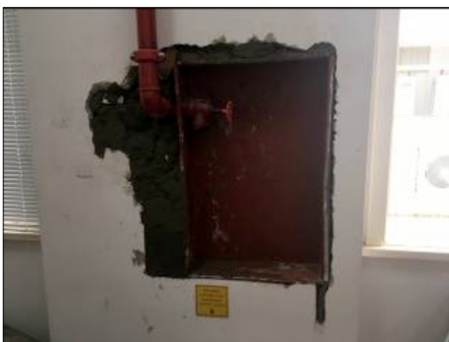
Figura 01 – Fechamento em alvenaria – Hidrante OAB
