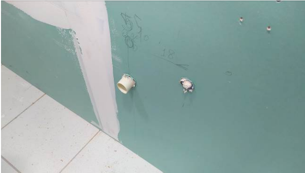
Figura 53C: Instalação de ponto de água fria e de esgoto, no sanitário público feminino do primeiro pavimento
