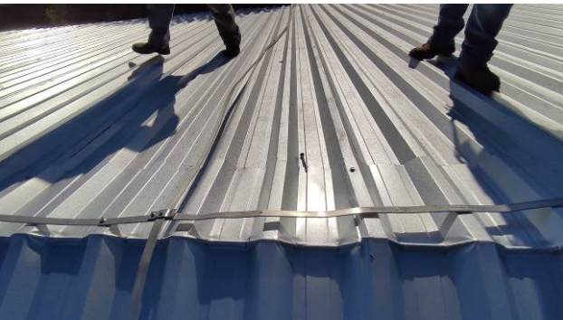
Figura 61E: retirada, posicionamento e reinstalação do SPDA barracão
