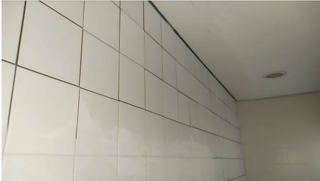
Figura 59C: Finalização da instalação dos azulejos em parede de gesso acartonado verde, no sanitário PNE do pavimento térreo. No detalhe o forro já reconstruído.
