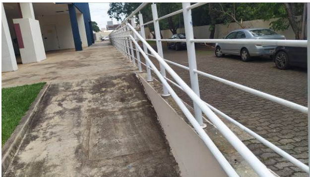
Figura 45C: Corrimão duplo, em tubos de aço galvanizado, instalado no lado esquerdo do Fórum (terraceo técnico)
