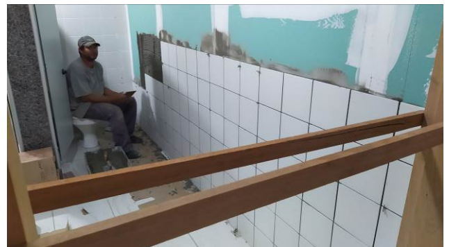
Figura 58C: Início da instalação dos azulejos em parede de gesso acartonado verde, no sanitário feminino do primeiro pavimento.
