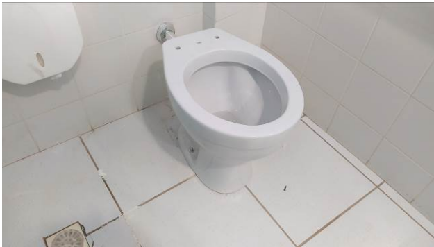
Figura 61C: Bacia sanitária instalada no BWC PNE do primeiro pavimento
