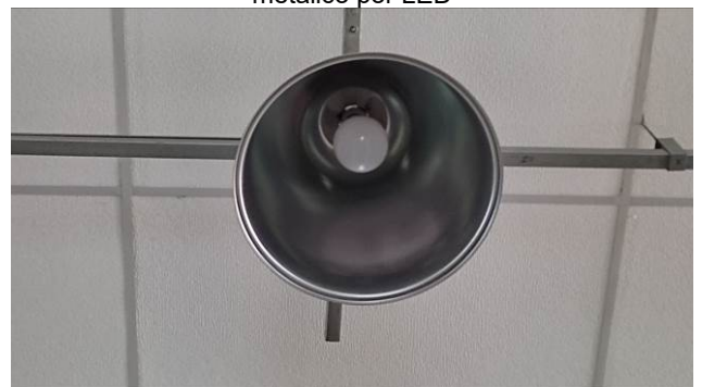
Figura 74E: iluminação barracão – substituição vapor metálico por LED
