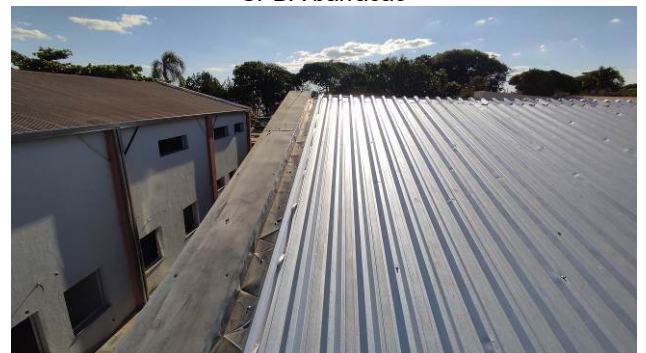
Figura 68E: retirada, posicionamento e reinstalação do SPDA barracão
