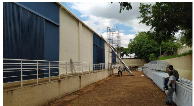
Figura 02C: Utilização de andaime no processo de remoção e instalação de telhas no barracão
