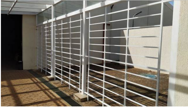
Figura 81C: Gradil de fechamento (em metalon) dos vãos existentes na região da cobertura de vidro
