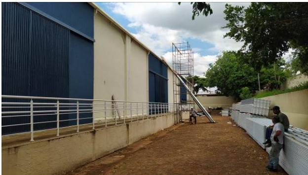
Figura 67C: Processo de elevação das telhas novas até a cobertura
