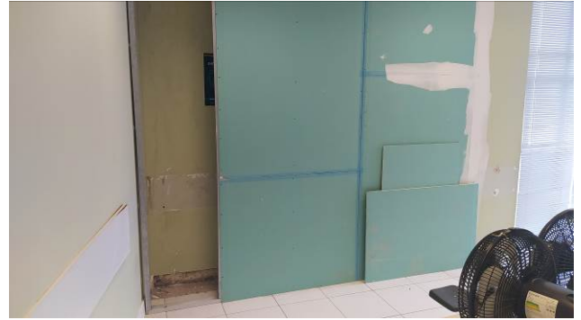
Figura 77C: Início da instalação da parede de gesso acartonado, na sala de audiência 1 da 5ª Vara
