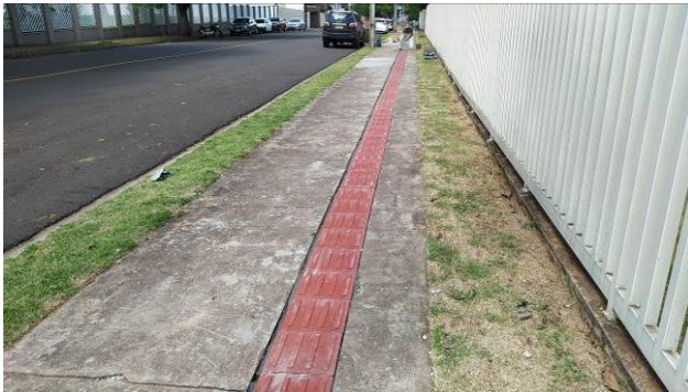
Figura 43C: Finalização do piso tátil externo, no passeio público
