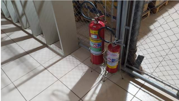
Figura 03C: Extintores de pó químico seco e de água pressurizada, instalados no almoxarifado da Setorial
