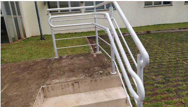
Figura 49C: Corrimão duplo, em tubos de aço galvanizado, instalado na escada de acesso à doca da Setorial
