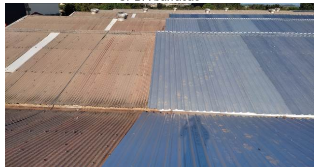
Figura 70E: retirada, posicionamento e reinstalação do SPDA barracão
