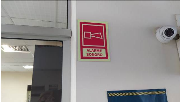
Figura 27C: Placa E1, instalada no pavimento térreo
