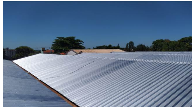
Figura 68C: Telhas termoacústicas instaladas no arquivo e estacionamento
