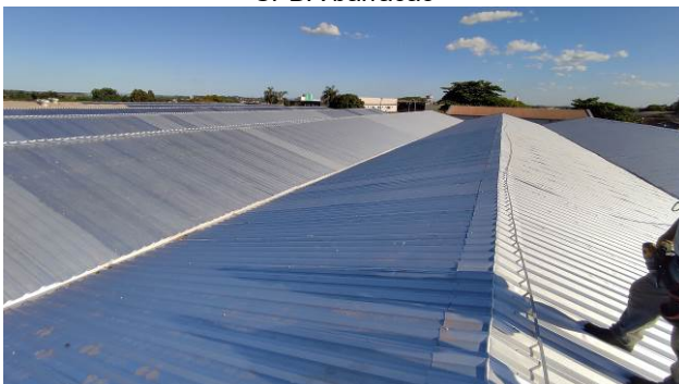
Figura 67E: retirada, posicionamento e reinstalação do SPDA barracão
