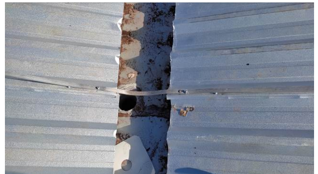
Figura 66E: retirada, posicionamento e reinstalação do SPDA barracão
