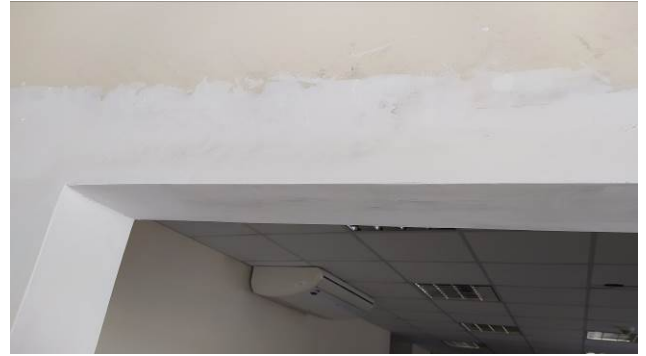
Figura 40C: Requadro da verga, no vão para instalação de porta na rota de fuga do auditório
