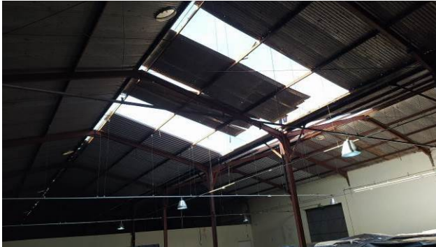
Figura 65C: Processo de remoção das telhas antigas no barracão – visto por baixo
