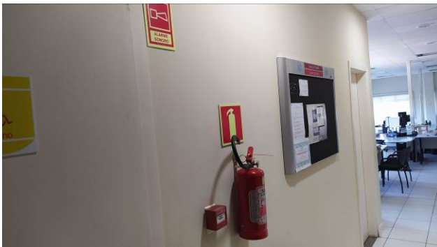
Figura 31C: Extintor de PQS 4kg, instalado no corredor da Copa da 4ª Vara
