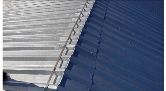
Figura 64E: retirada, posicionamento e reinstalação do SPDA barracão
