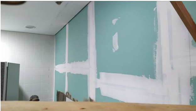
Figura 55C: Parede de gesso acartonado verde, executada no BWC feminino do segundo pavimento. No detalhe o forro já reconstituído.
