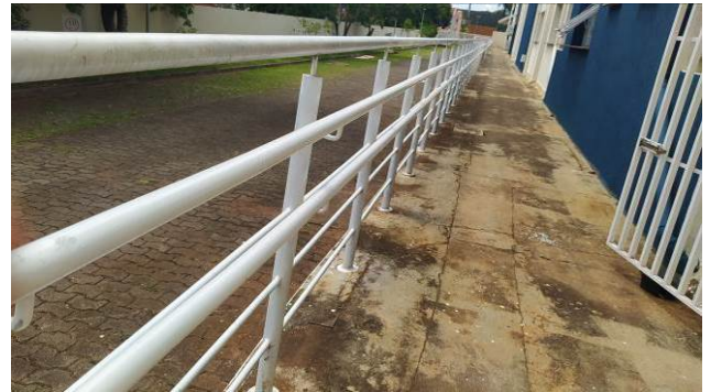
Figura 44C: Corrimão duplo, em tubos de aço galvanizado, instalado no lado esquerdo do barracão
