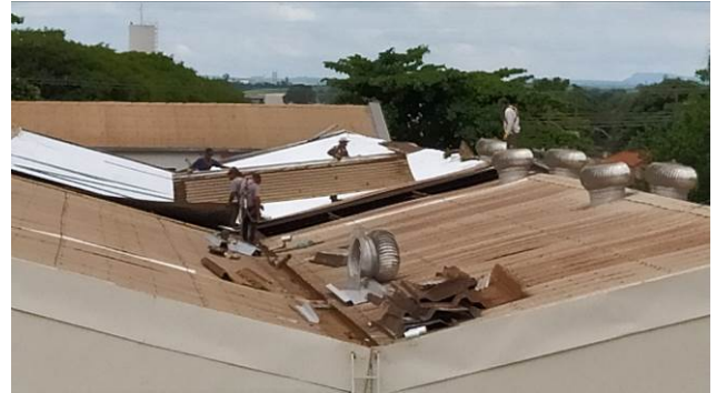
Figura 66C: Processo de remoção das telhas antigas no barracão – visto por cima
