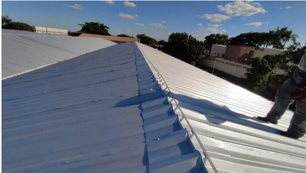
Figura 63E: retirada, posicionamento e reinstalação do SPDA barracão
