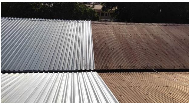
Figura 69E: retirada, posicionamento e reinstalação do SPDA barracão
