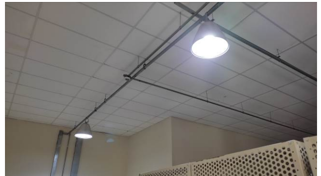
Figura 72E: iluminação barracão – substituição vapor metálico por LED
