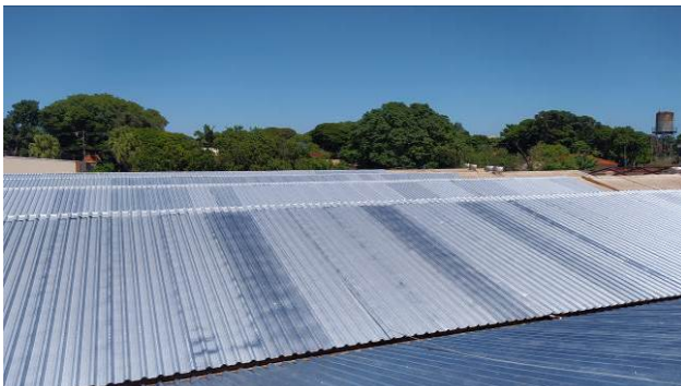
Figura 69C: Telhas termoacústicas instaladas no arquivo e estacionamento
