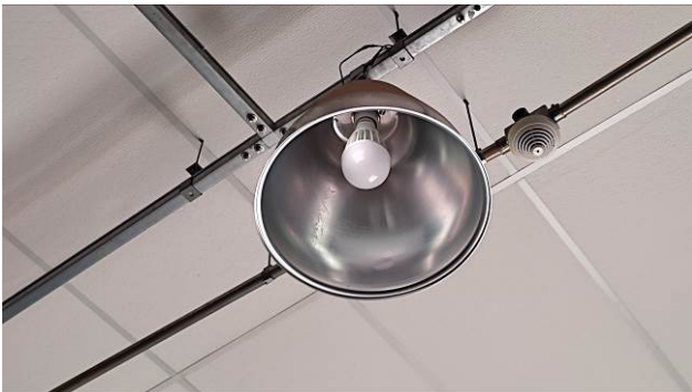
Figura 71E: iluminação barracão – substituição vapor metálico por LED
