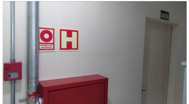
Figura 24C: Placas E3 e E7, instaladas junto a hidrante, no arquivo. No canto superior direito da imagem, placa S12
