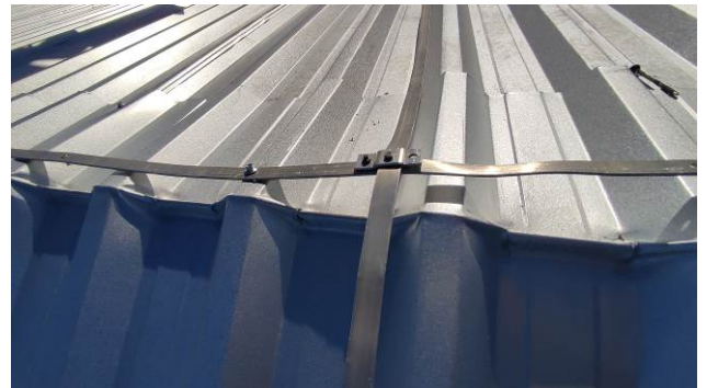
Figura 62E: retirada, posicionamento e reinstalação do SPDA barracão
