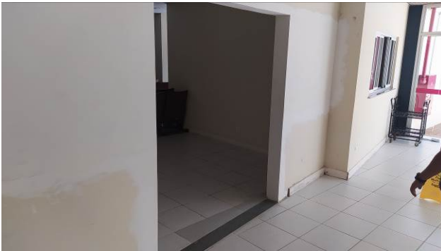
Figura 41C: Requadro das paredes, no vão para instalação de porta na rota de fuga do auditório
