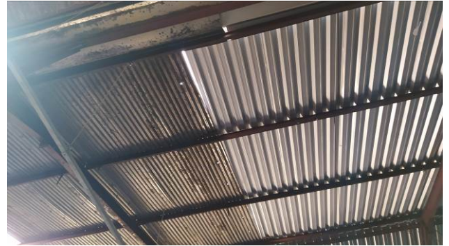
Figura 72C: Telhas termoacústicas instaladas no estacionamento – região de término das telhas antigas e início das telhas novas
