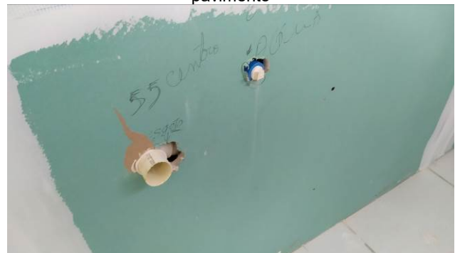
Figura 52C: Instalação de ponto de água fria e de esgoto, no sanitário público feminino do pavimento térreo
