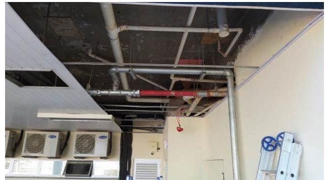
Figura 36C: Demolição de forro de PVC em régua e instalação de tubulação de aço galvanizado, para atender o hidrante H24, no terraço técnico (térreo)
