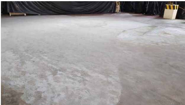
Figura 83C: Recuperação de parte do piso no estacionamento
