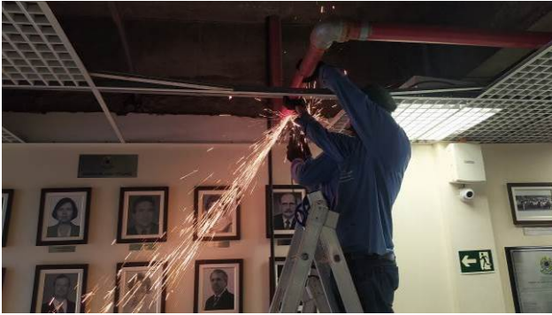
Figura 39C: Operário realizando derivação na tubulação de incêndio, no pavimento térreo, após demolir forro de gesso acartonado para acessar a tubulação
