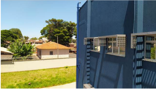
Figura 76C: Pintura da chaminé (escapamento) do gerador
