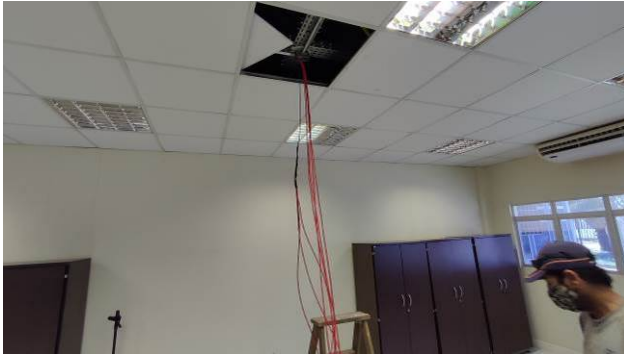
Figura 27E: sistema de acionamento da bomba hidrantes
