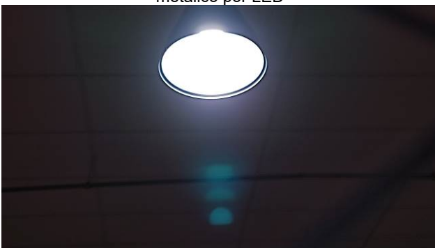
Figura 73E: iluminação barracão – substituição vapor metálico por LED
