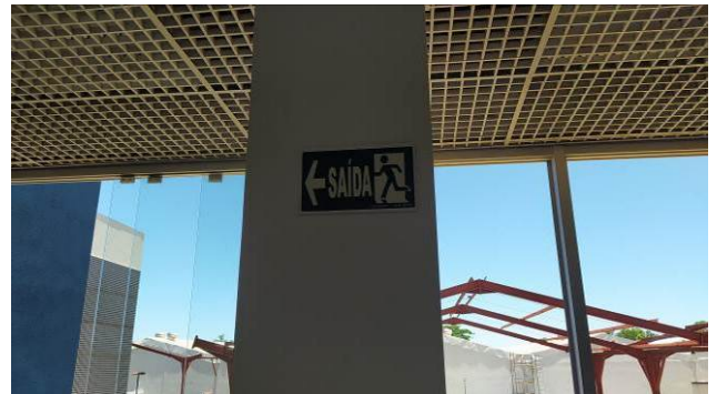
Figura 30C: Placa S2, instalada no primeiro pavimento (hall de circulação do bloco oeste)
