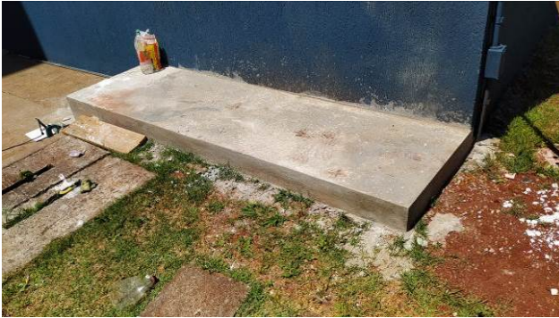
Figura 75C: Base para assentamento das cisternas de reuso de água da chuva
