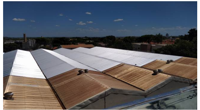
Figura 74C: Vista panorâmica da cobertura do barracão – região do estacionamento
