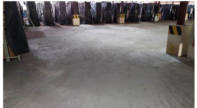
Figura 84C: Recuperação de parte do piso no estacionamento
