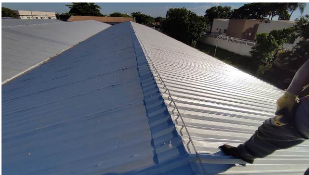
Figura 65E: retirada, posicionamento e reinstalação do SPDA barracão
