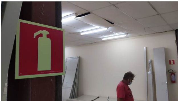
Figura 13C: Placa E5, fotoluminescente, instalada no arquivo
