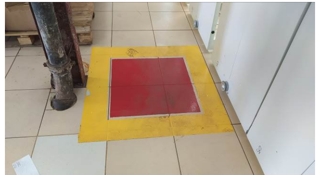
Figura 18C: Demarcação de solo (E17), executada no almoxarifado da setorial
