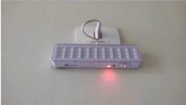
Figura 17E: Blocos de emergência – área Setorial
