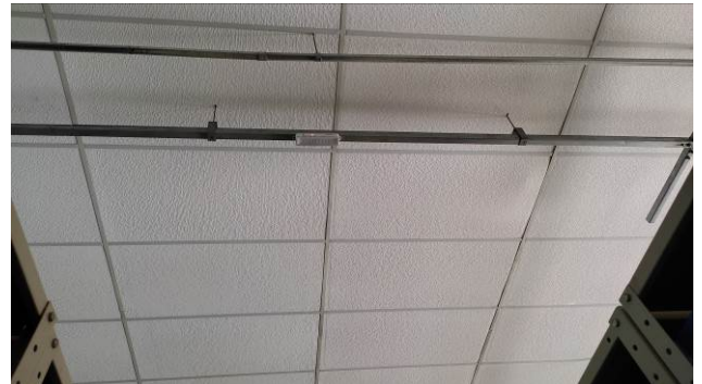
Figura 16E: Blocos de emergência – área Setorial
