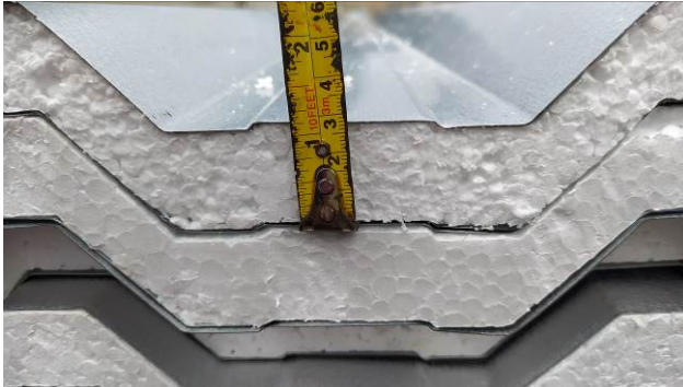
Figura 35C: Aferição da espessura do preenchimento em EPS da telha
