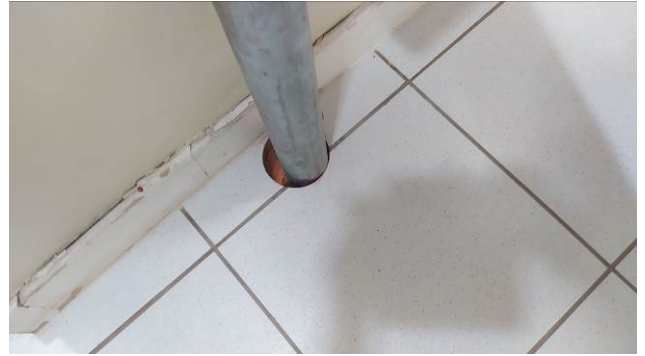
Figura 26C: Furo realizado em concreto para passagem da tubulação de incêndio
