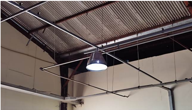
Figura 29E: Substituição de lâmpadas Vapor metálico por LED, área do barracão – antigo estacionamento coberto
