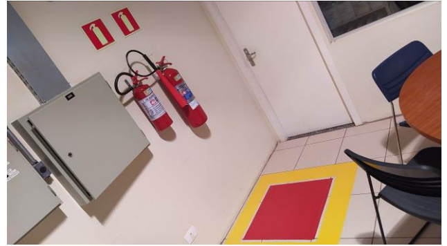
Figura 16C: Demarcação de solo (E17), executada no arquivo
