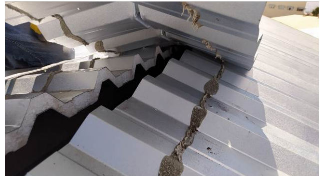
Figura 32C: Detalhe da retirada de uma goiva para verificação do uso da fita butílica de vedação
