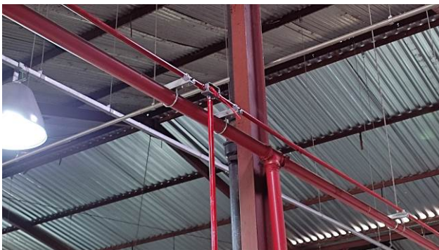
Figura 09E: Infraestrutura e cabeamento para acionamento da bomba dos hidrantes – antigo estacionamento coberto
