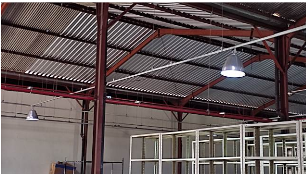
Figura 31E: Substituição de lâmpadas Vapor metálico por LED, área do barracão – antigo estacionamento coberto
