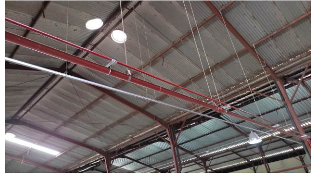
Figura 06E: Infraestrutura e cabeamento para acionamento da bomba dos hidrantes – antigo estacionamento coberto
