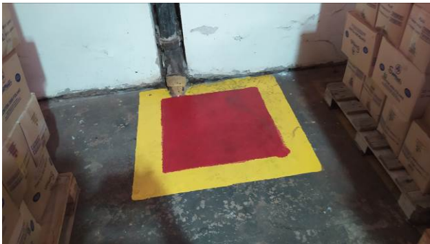
Figura 17C: Demarcação de solo (E17), executada no estacionamento
