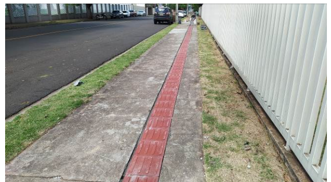
Figura 28C: Instalação do piso tátil em placa cimentícea no passeio público
