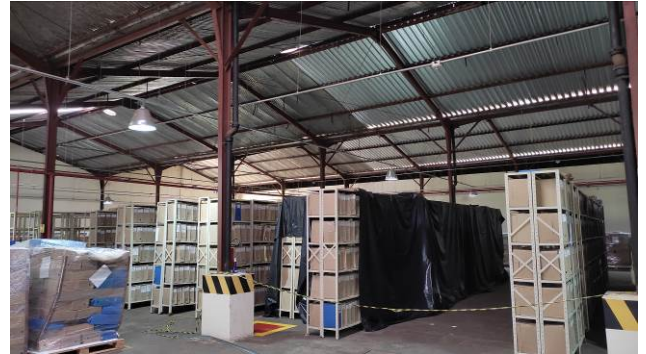
Figura 34E: Substituição de lâmpadas Vapor metálico por LED, área do barracão – antigo estacionamento coberto
