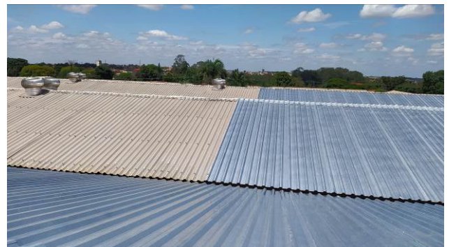
Figura 34C: Cobertura com telha tipo sanduíche, na região do arquivo
