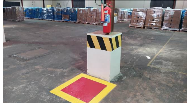
Figura 04C: Alteração da posição de extintores no estacionamento. Execução de demarcação de piso (E17)
