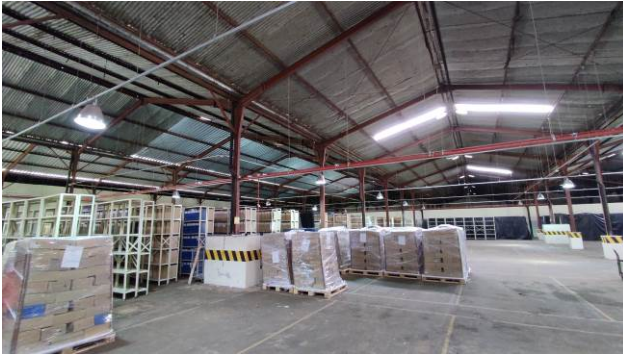
Figura 33E: Substituição de lâmpadas Vapor metálico por LED, área do barracão – antigo estacionamento coberto
