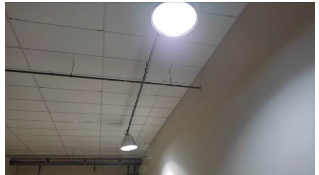
Figura 36E: Substituição de lâmpadas Vapor metálico por LED, área do barracão – Setorial
