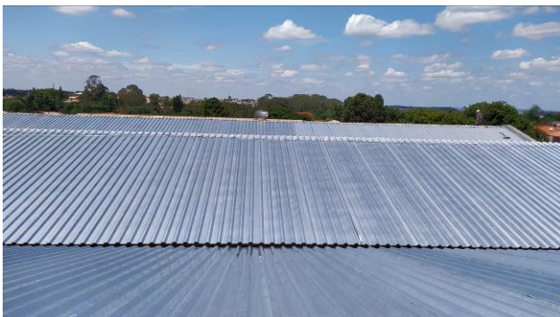
Figura 33C: Cobertura com telha tipo sanduíche, na região do arquivo
