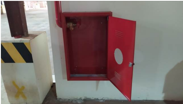
Figura 05C: Instalação de abrigo para hidrante, na parede entre o almoxarifado da setorial e o arquivo
