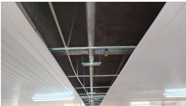
Figura 19C: Demolição de trecho do forro de PVC em réguas e instalação de tubulação de aço galvanizado 2 ½", no estacionamento do fórum
