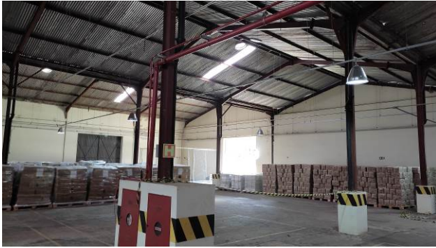
Figura 11E: Infraestrutura e cabeamento para acionamento da bomba dos hidrantes – antigo estacionamento coberto
