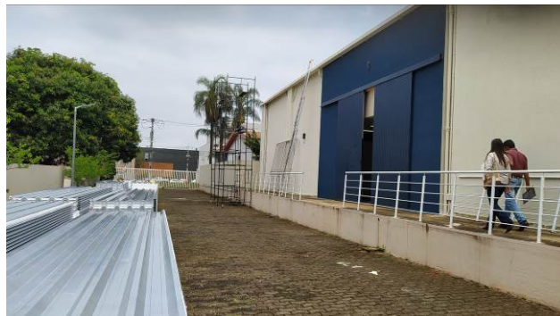
Figura 02C: Utilização de andaime
