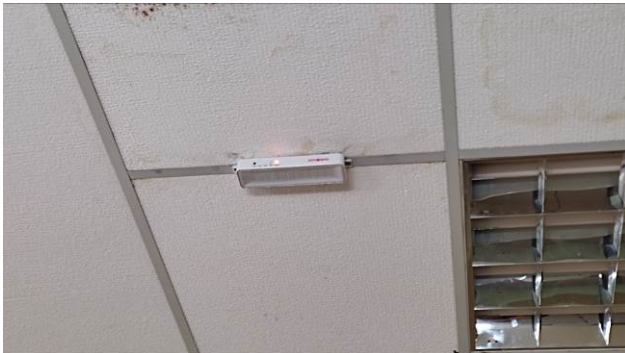
Figura 15E: Blocos de emergência – área Setorial
