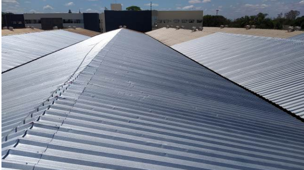
Figura 29C: Telha tipo sanduíche, instalada na cobertura do barracão (região do estacionamento)
