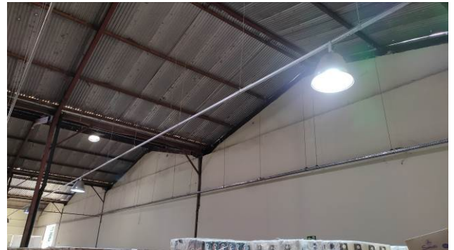
Figura 30E: Substituição de lâmpadas Vapor metálico por LED, área do barracão – antigo estacionamento coberto
