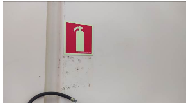
Figura 12C: Placa E5, fotoluminescente, instalada no arquivo
